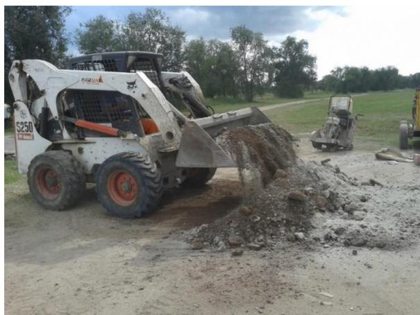
**Figura 5.23:** Pala cargadora mezclando la base.
