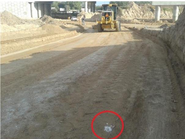
**Figura 3.24:** Vista de la subbase nivelada y corte de cabeza de estaca.
