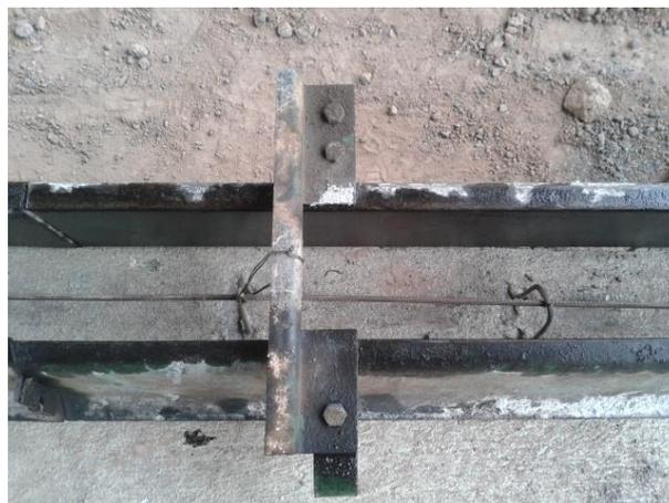
**Figura 3.54:** Vista sujeción de encofrado.
