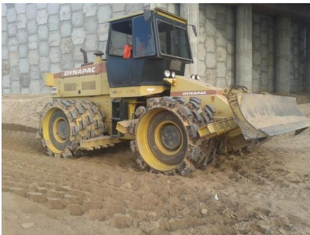
**Figura 3.20:** Rodillo pata de cabra estático compactando subbase.
