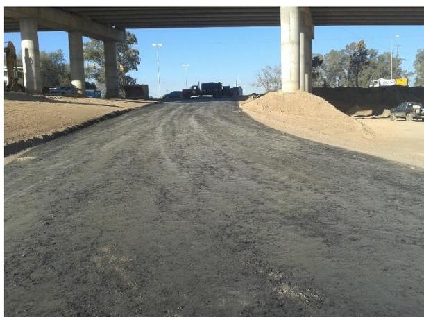
**Figura 3.55:** Riego de imprimación realizado.
