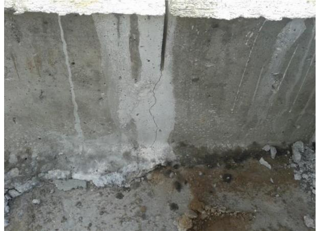
**Figura 3.48:** Fisura en el lugar deseado.
