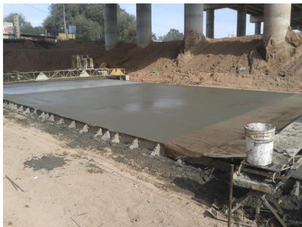
**Figura 3.40:** Superficie con textura final a la espera del curado.
