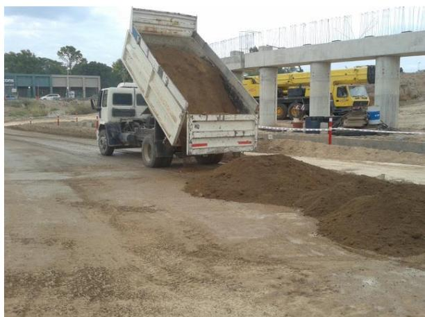
**Figura 3.16:** Descarga de la mezcla en el sector del camino.
