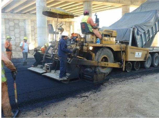
**Figura 3.57:** Colocación de la mezcla asfáltica con terminadora.
