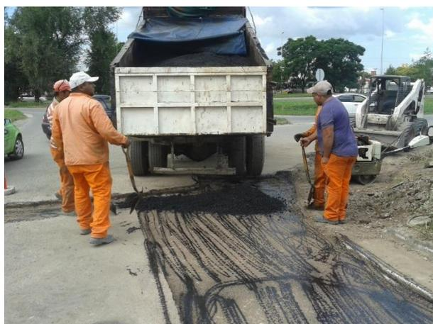
**Figura 5.28:** Colocación de la mezcla asfáltica.
