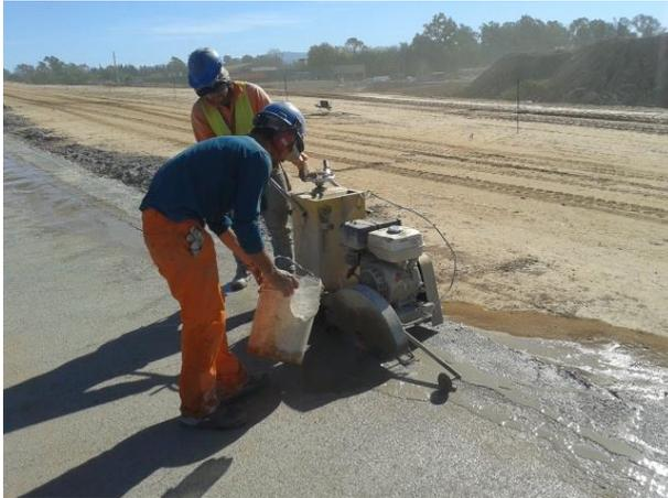
**Figura 3.47:** Aserrado de las juntas.
