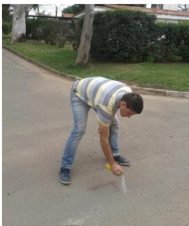
*Figura 5.18: Marcado de la zona a bachear con aerosol.*
