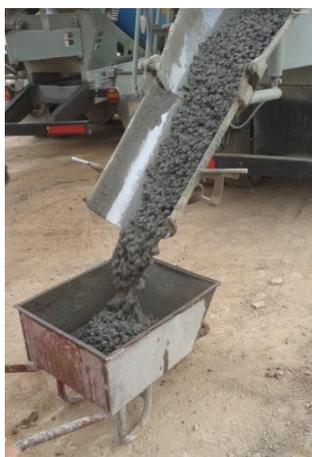
**Figura 3.94:** Llenado de carretilla con hormigón para ensayar.
