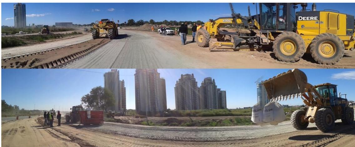
**Figura 3.26:** Vista distribución del cemento y mezclado.
