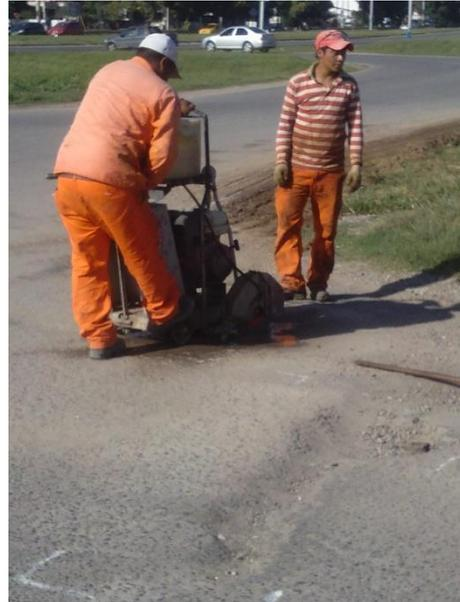
**Figura 5.20:** Aserrado de la carpeta de rodamiento a remover.
