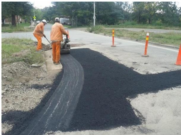
**Figura 5.30:** Compactación de la carpeta de asfalto.
