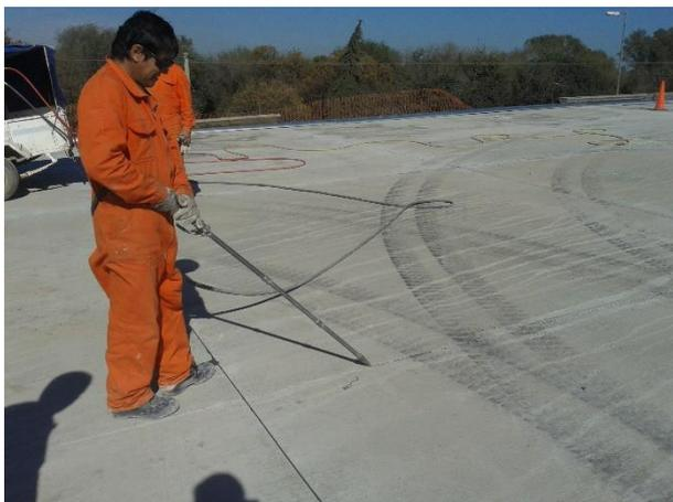
**Figura 3.51:** Colocación del líquido sellador.
