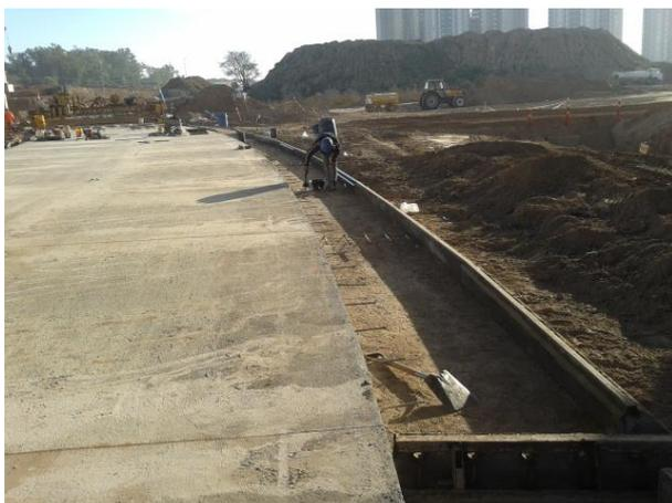
**Figura 3.60:** Vista sobreancho previa al hormigonado.
