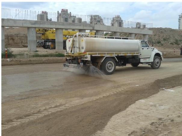
**Figura 3.15:** Regado de la base de asiento previa descarga de la subbase.
