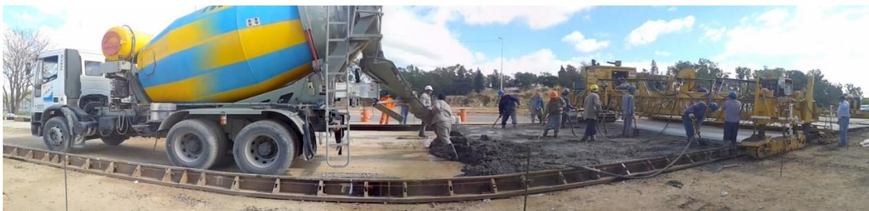
**Figura 3.38:** Vista descargar, distribución y compactación del hormigón.
