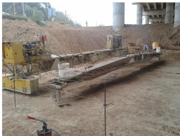
**Figura 3.37:** Tren de curado (fondo) y tren de texturizado (adelante).
