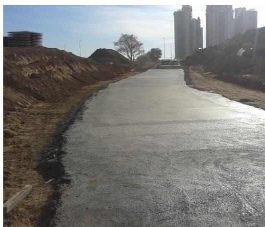
**Figura 3.62:** Base ejecutada con Hormigón H-8.
