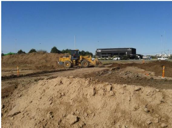
**Figura 3.11:** Extracción del terreno natural con pala cargadora frontal.
