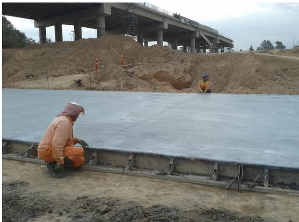
**Figura 3.44:** Marcado de la junta transversal.
