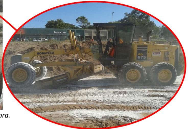
**Figura 3.7:** Distribución de la cal con motoniveladora.
