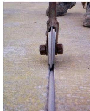
**Figura 3.50:** Colocación del cordón de respaldo.
