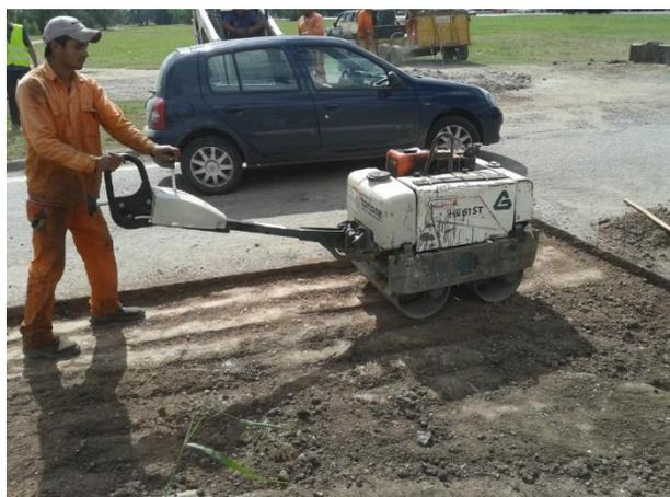
**Figura 5.22:** Compactado de la subbase.
