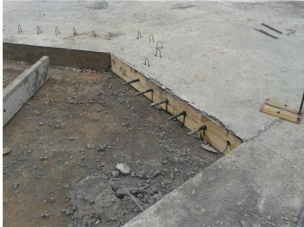
**Figura 3.5:** Vista junta de construcción.
