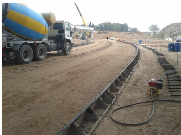
**Figura 3.31:** Vista ingreso de camión hormigonero. Posición final de los canastos con barras de unión y canastos de pasadores a la espera de avance de hormigonado.
