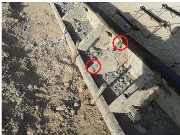
**Figura 3.27:** Fijación de encofrado a base estabilizada y unión entre moldes.
