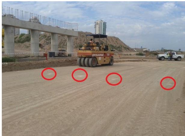
**Figura 3.25:** Vista subbase cortada y compactándola con rodillo liso para terminación.
