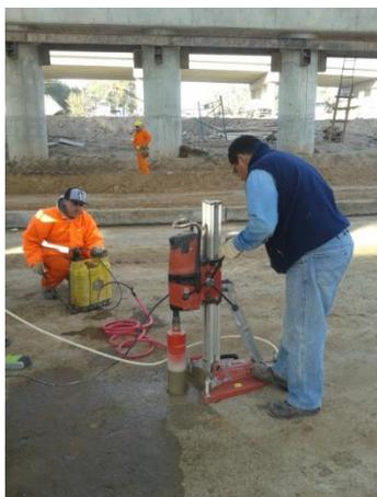
**Figura 3.90:** Extracción del testigo de la base.
