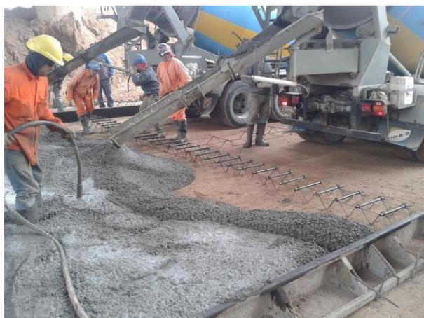
**Figura 3.35:** Vista del canasto de pasadores colocado a la espera de hormigón.
