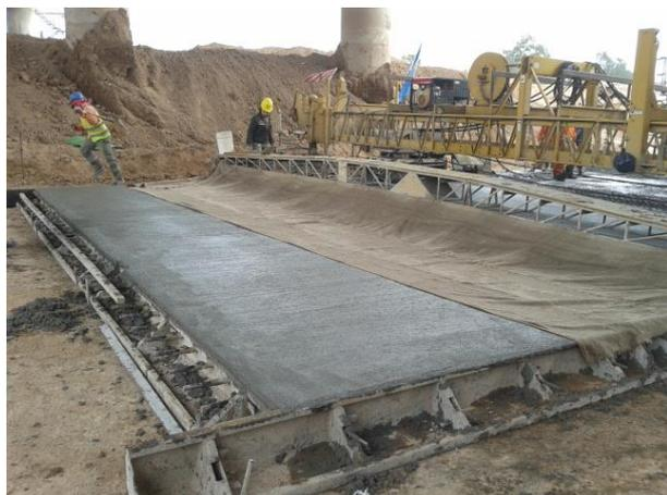
**Figura 3.39:** Vista de la tela de arpillera utilizada para el texturizado.
