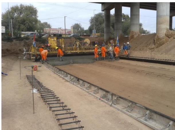
**Figura 3.34:** Vista avance de hormigonado y canasto preparado para ser colocado en su posición final.
