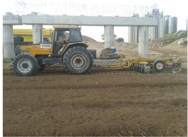
**Figura 3.19:** Mezclado del material con rastra.
