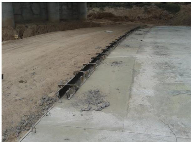
**Figura 3.53:** Vista encofrado para el cordón.
