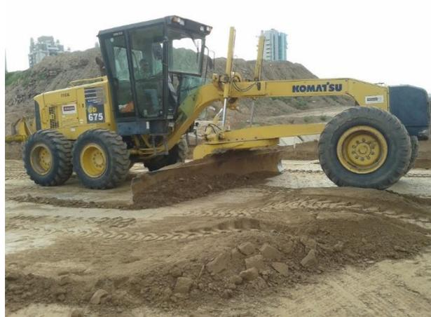
**Figura 3.23:** Motoniveladora cortando la subbase.
