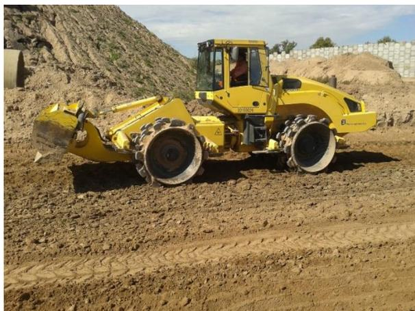
**Figura 3.8:** Compactación de la sub-rasante con compactador tipo pata de cabra.
