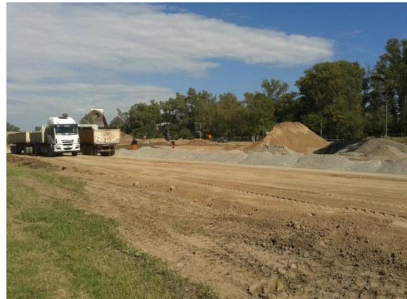
**Figura 3.12:** Montículos de triturado 0-6 sobre suelo ya nivelado.
