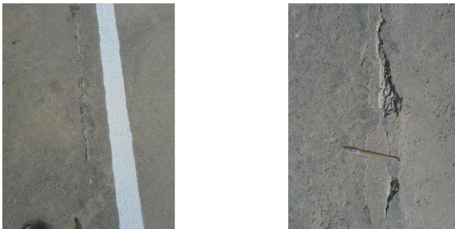
**Figura 5.13:** Vista junta sin material de sellado.
