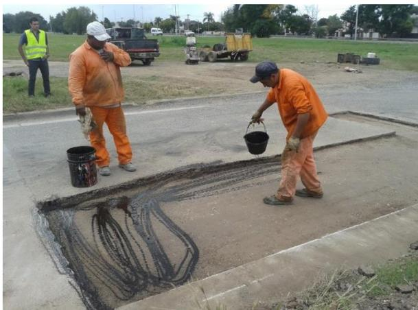
**Figura 5.26:** Aplicación de la imprimación.
