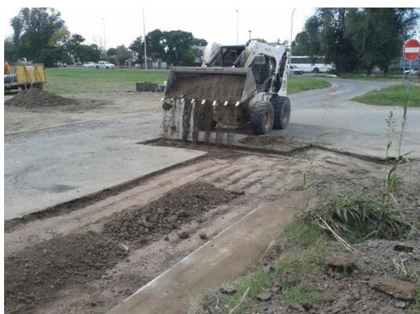
**Figura 5.24:** Distribución de la base suelo – arena - cemento.
