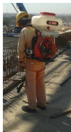
**Figura 3.43:** Equipo para colocar el compuesto de curado.
