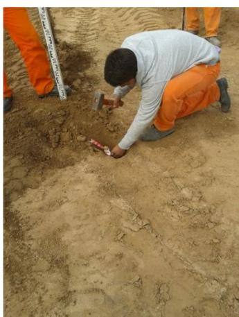
**Figura 3.9:** Colocación de la estaca.
