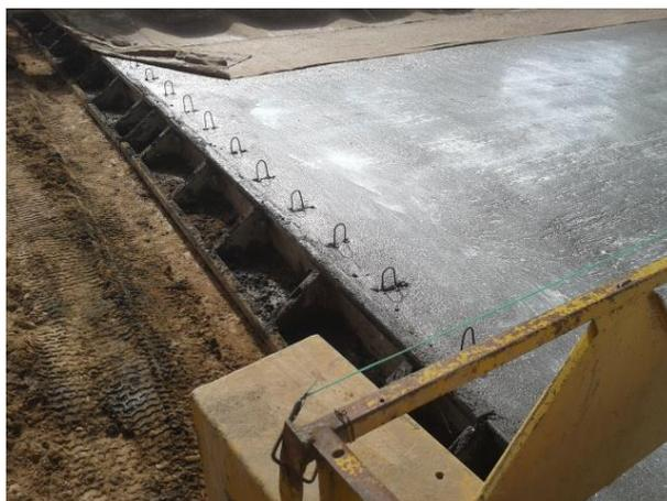
**Figura 3.41:** Hierros colocados para la fijación del cordón.
