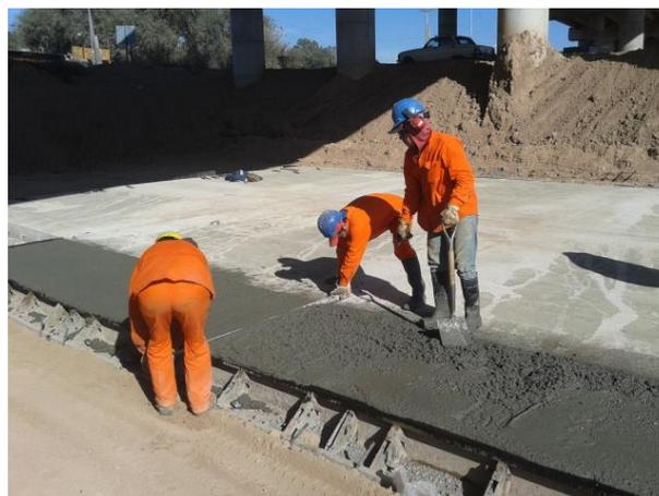
**Figura 3.61:** Hormigonado de sobreancho.
