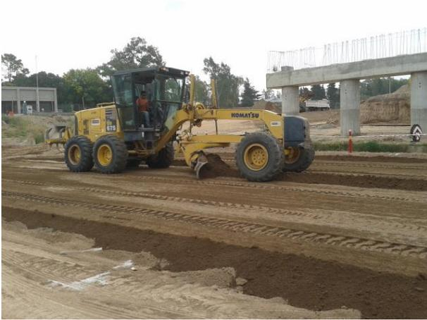
**Figura 3.18:** Distribución de la mezcla con motoniveladora.
