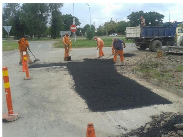
**Figura 5.29:** Distribución manual del material previo paso del compactador.
