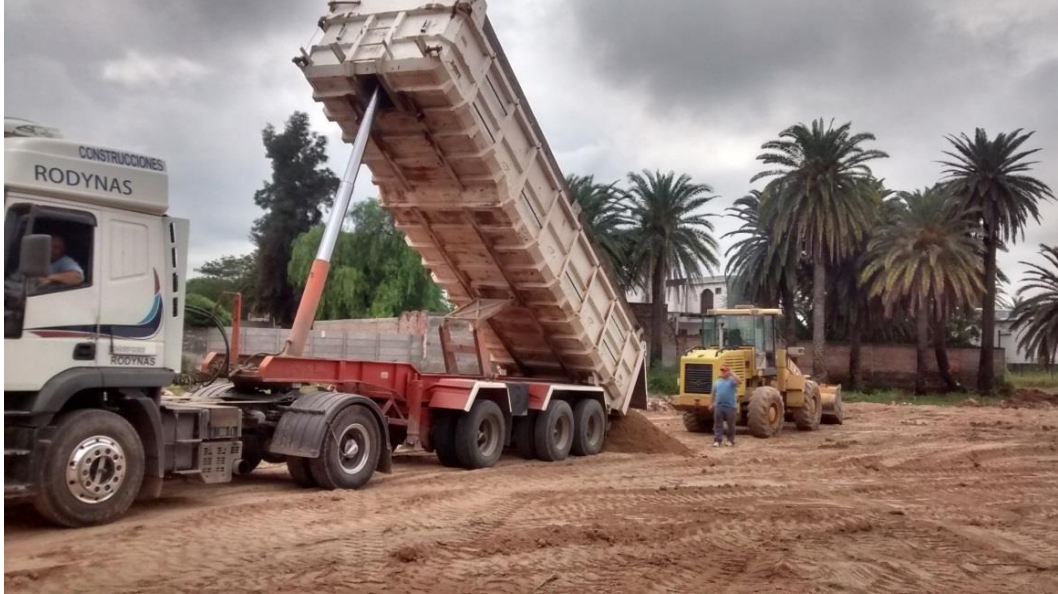
Figura 45: Descarga de la batea con la indicación del maquinista.
