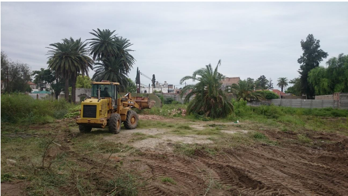
Figura 20: Otro ángulo de la cargadora extrayendo una palmera.
