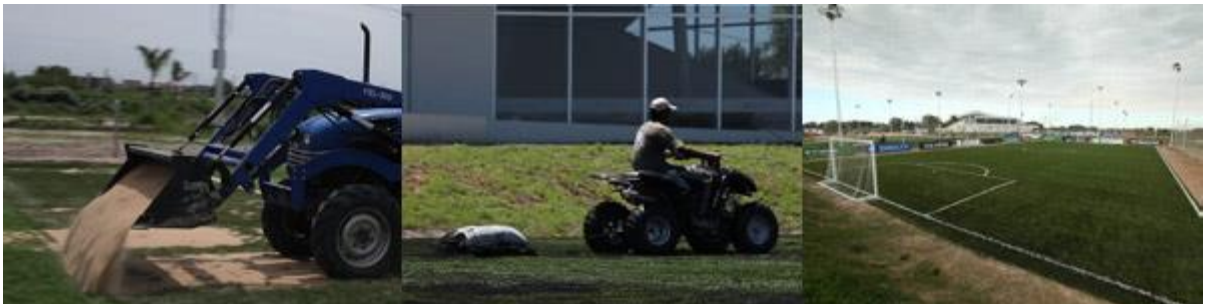
Figura 11: Vertido de la arena, cepillado y disposición final
