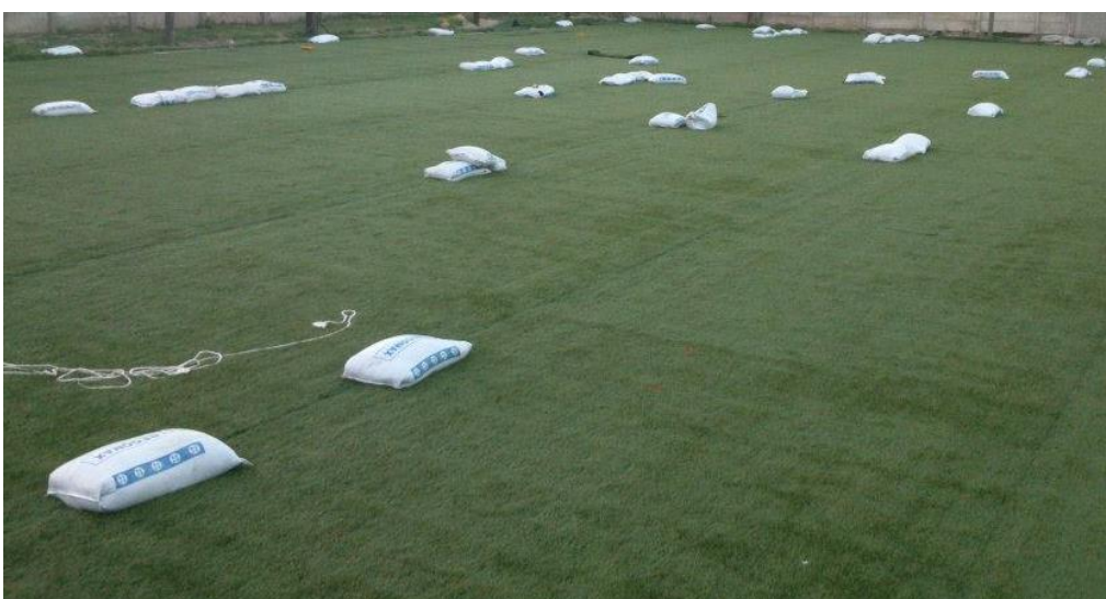
Figura 56: Distribución de las bolsas de caucho. Imagen extraída de otra obra similar realizada por la empresa.
