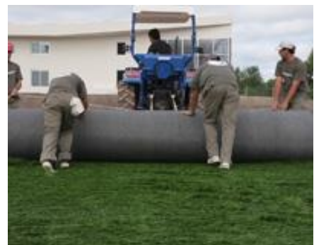
Figura 9: Extendido de los rollos de césped artificial
