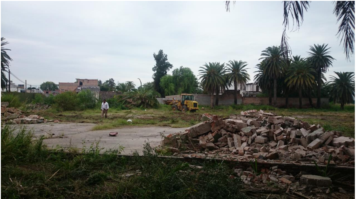
Figura 18: Imagen de la cargadora frontal trabajando en la demolición de las canchas y extracción del manto vegetal.
