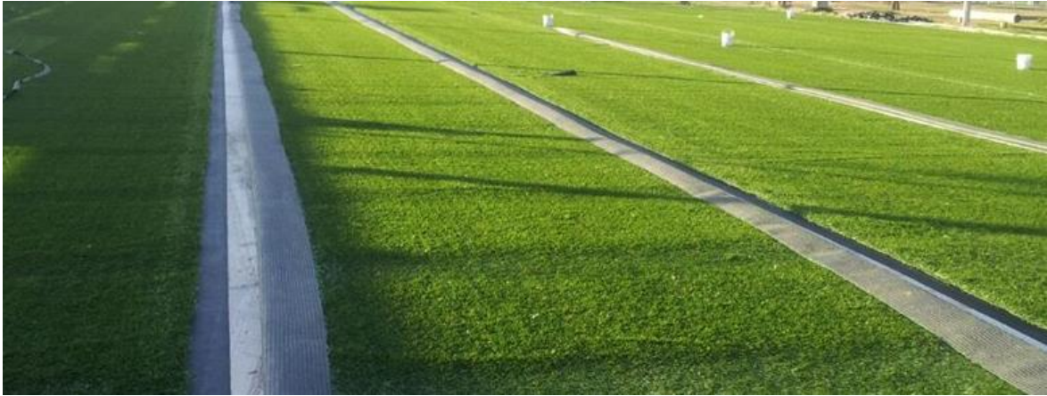
Figura 54: Forma de tendido del césped sintético. Imagen extraída de otra obra similar realizada por la empresa.
