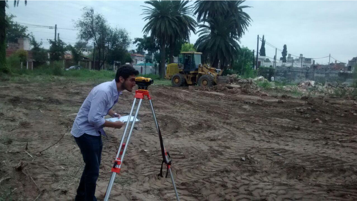
Figura 22: Medición altimétrica con nivel y mira topográfica.
