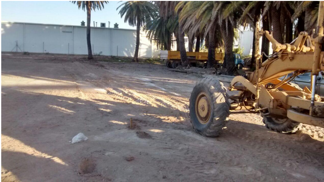
Figura 49: Mezclado y distribución del caballete sobre el suelo con la motoniveladora.
