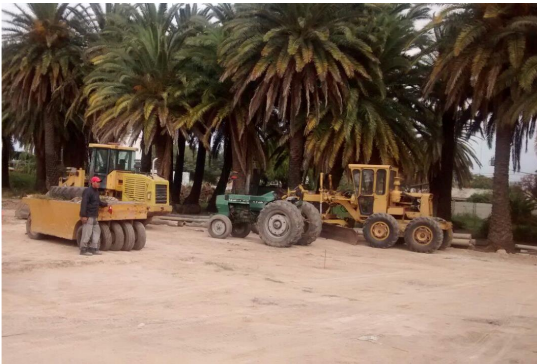
Figura 40: Equipos. Cargadora Frontal, Tractor, Compactador neumático y Motoniveladora
