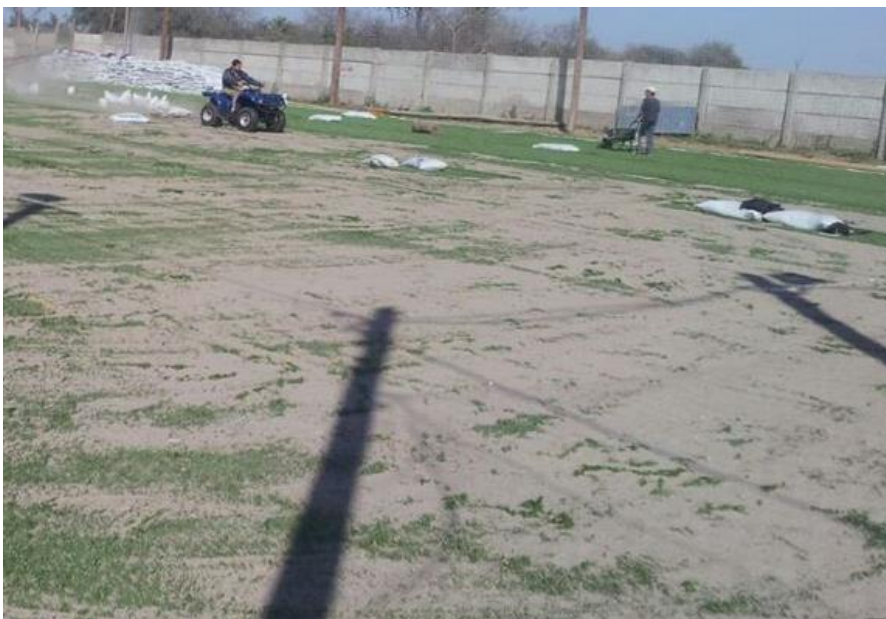
Figura 55: Cepillado de la arena tamizada. Imagen extraída de otra obra similar realizada por la empresa.
