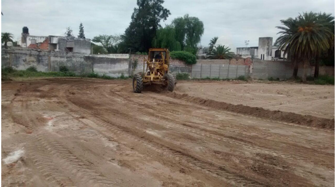
Figura 47: Motoniveladora extendiendo el material y nivelando.
