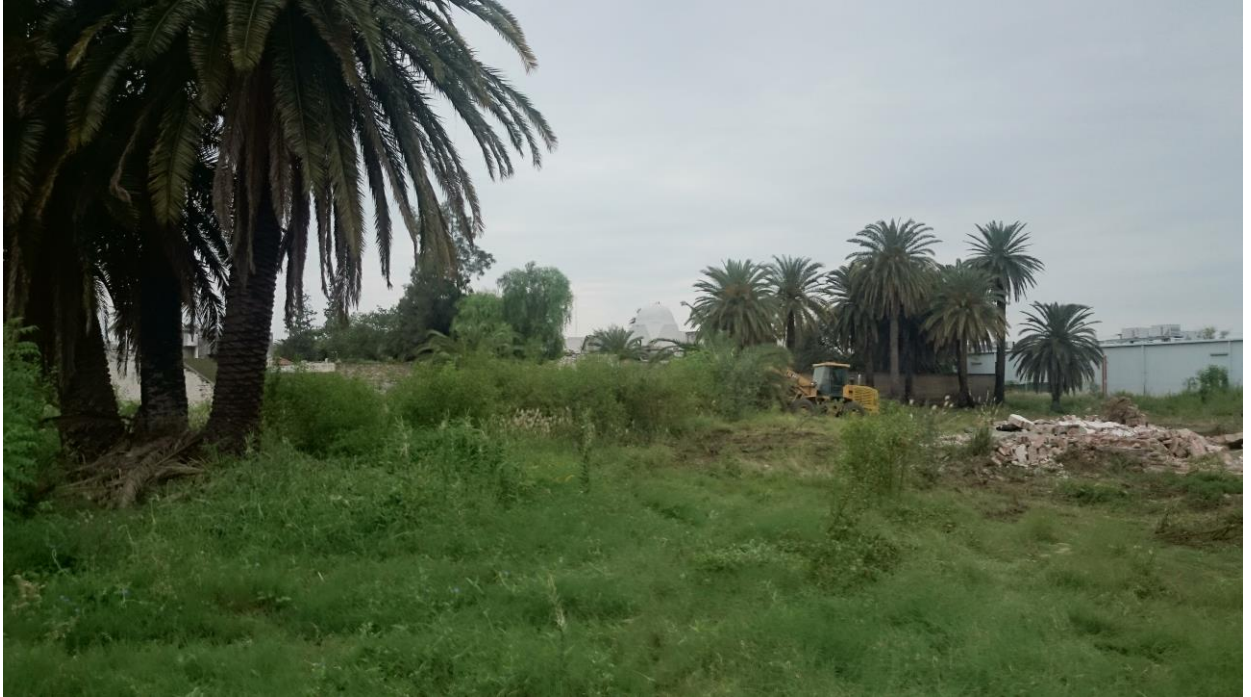
Figura 19: Imagen del estado del terreno y al fondo la maquina extrayendo un árbol de mediana altura.
