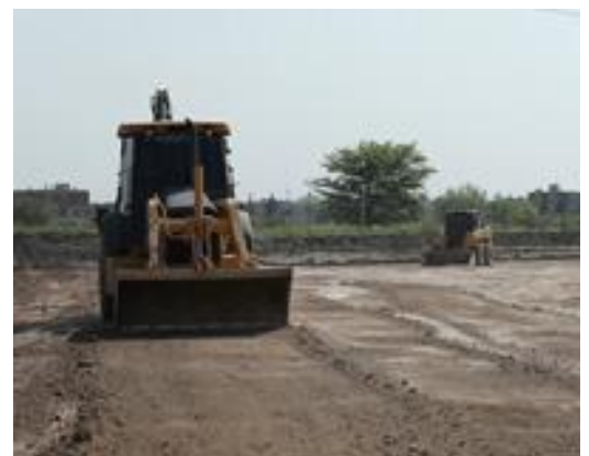
Figura 8: Preparación del terreno
