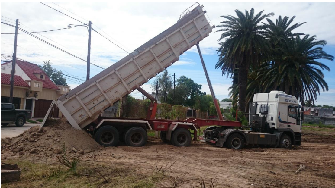
Figura 43: Descarga a la entrada del terreno para liberar peso
