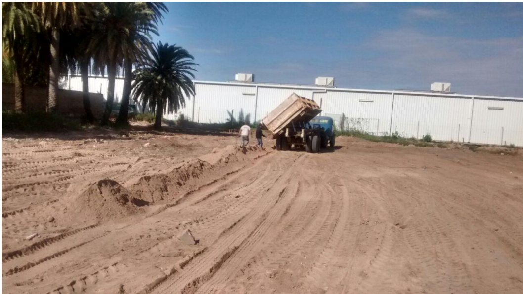
Figura 46: Descarga de un camión semirremolque de vuelco lateral.
