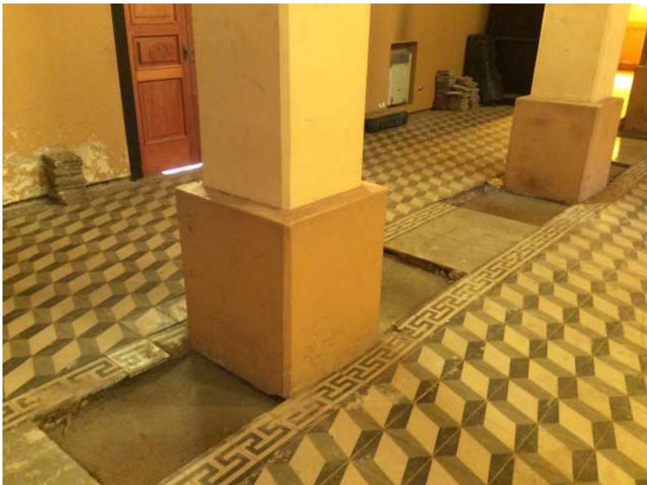
Foto 11. Pozos realizados para la construcción del cabezal de cada pilote.
