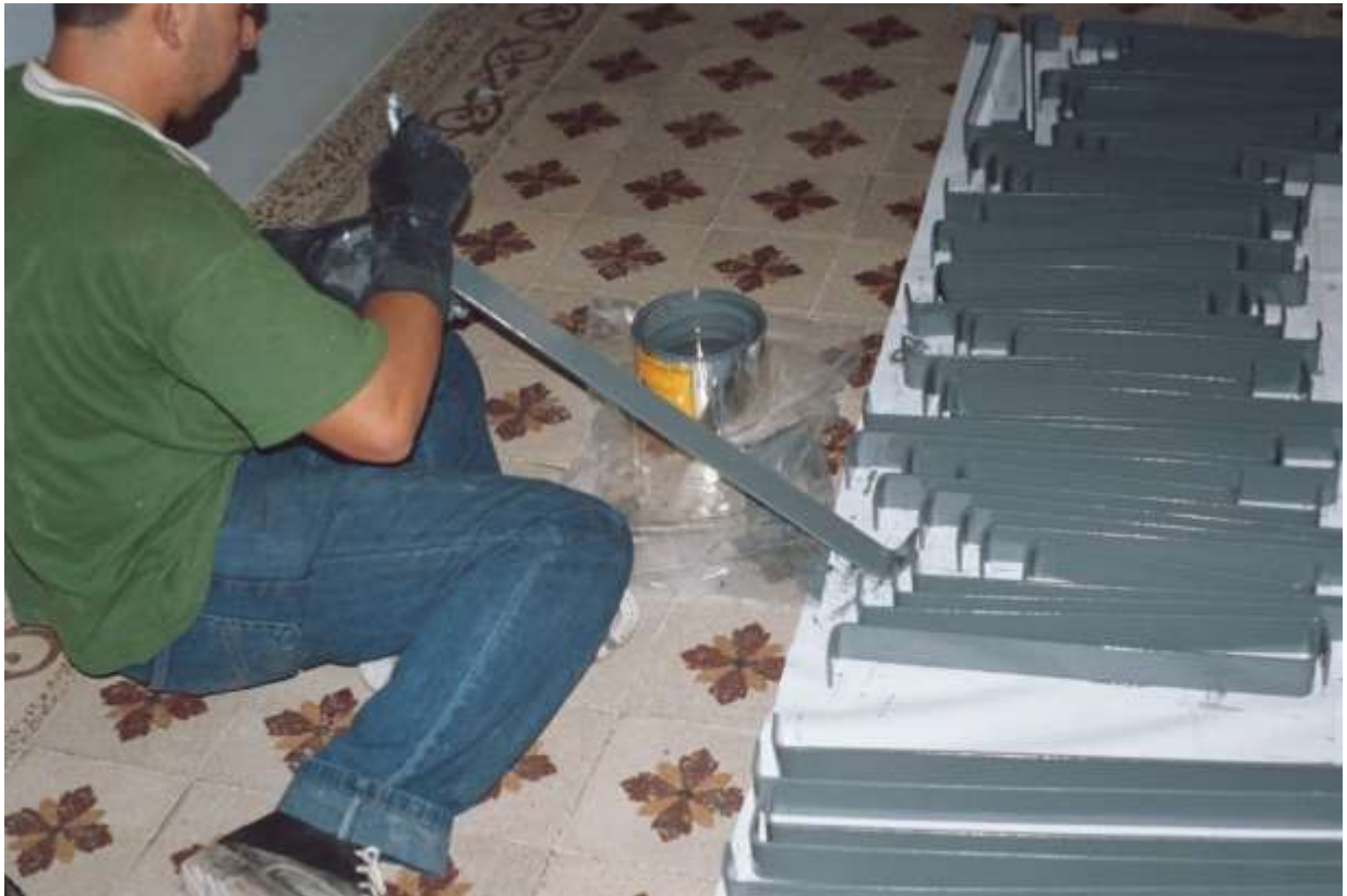
Foto 8. Tratamiento anticorrosivo de las grafas
