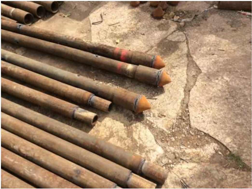
Foto 10. Vista del pilote armado, con el conjunto azuche-fuste. Se observan las perforaciones para inyección en el caño.
