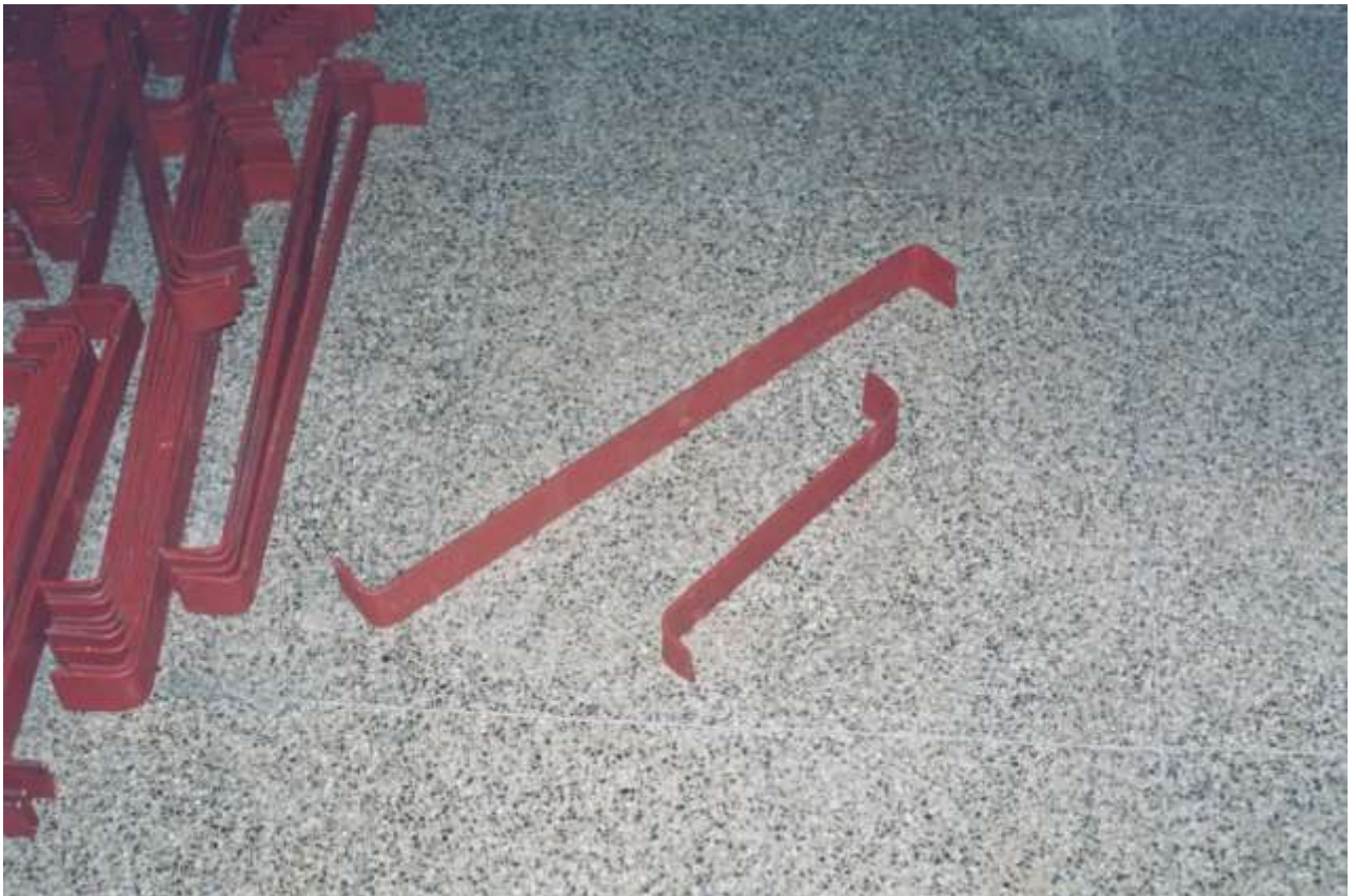
Foto 7. Tratamiento anticorrosivo de las grafas
