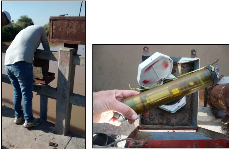
Figura 63. Instalación limnómetro.
