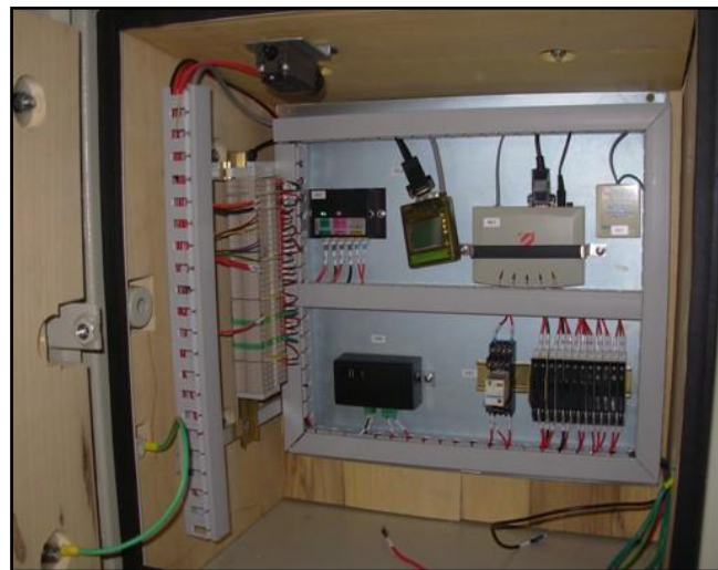
Figura 56. RTU. Gabinete de los sensores Waterlog H-334
