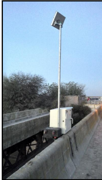
Figura 54. Estructura instalada en Paso de los Oscares.
