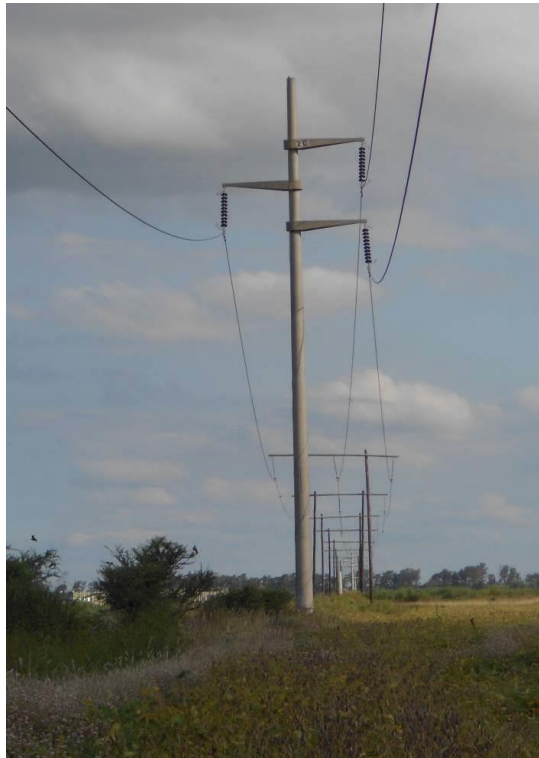
Figura 53: Línea de alta tensión. Se observa el cambio de postes de hormigón a madera.
