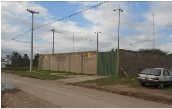
Figura 38: Planta reductora de presión de Ecogas.
