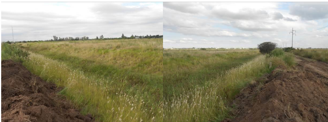
Figura 18: Canal de desagüe existente.
