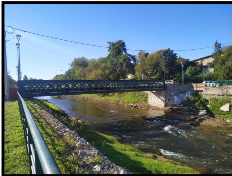
Fotografía 2: cauce del río Suquía, puente oeste, baranda y gaviones
