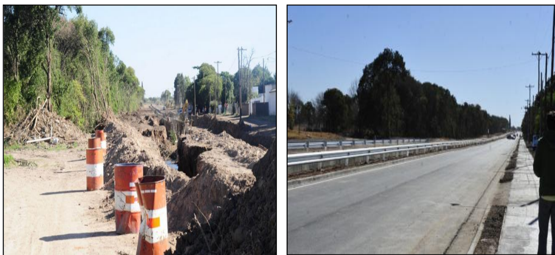
Imagen N° 19: Obra sobre Av. Spilimbergo
