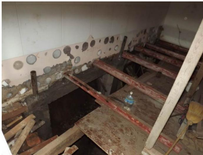
**Figura 24.** Viga y pilares ya hormigonados, conformando un pórtico de dos tramos
