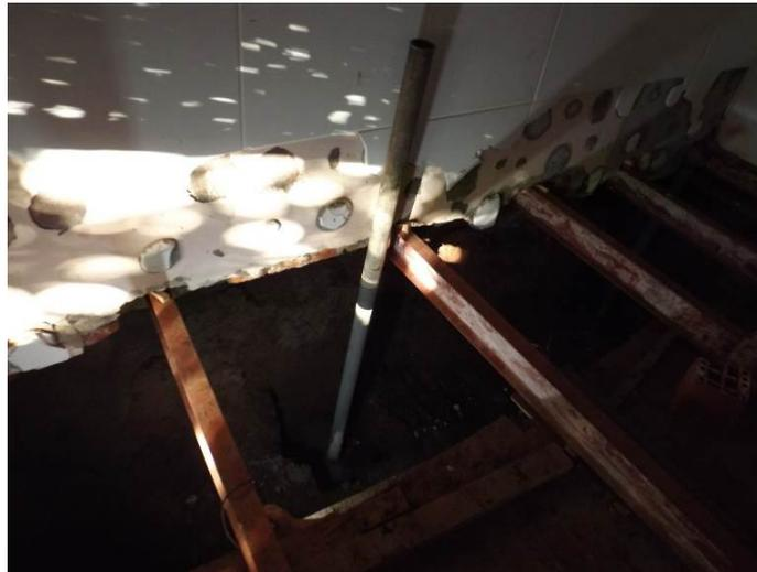
**Figura 21.** Vista de un micropilote hincado bajo el muro comprometido
