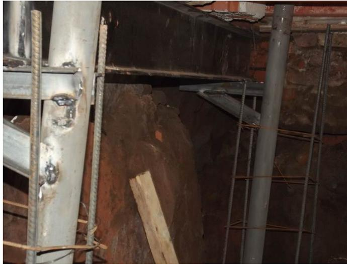
**Figura 23.** Vista de las ménsulas de apoyo de la viga portamuros. Se observa la armadura de las falsas columnas para hormigonar los pilotes
