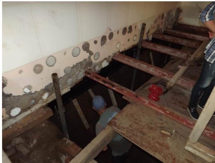
**Figura 22.** Vista general en donde se aprecian los 3 micropilotes y el armado de las ménsulas para sostener la viga portamuros
