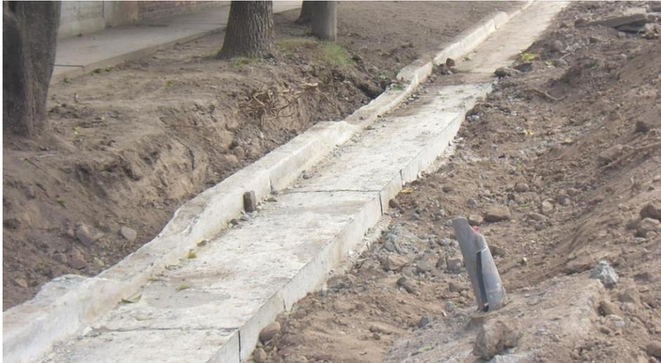
**Figura 3 - 62. Disposición en cordones de abertura para colocación de albañales de desagüe pluvial y cordones bajos para ingreso a cocheras.**
