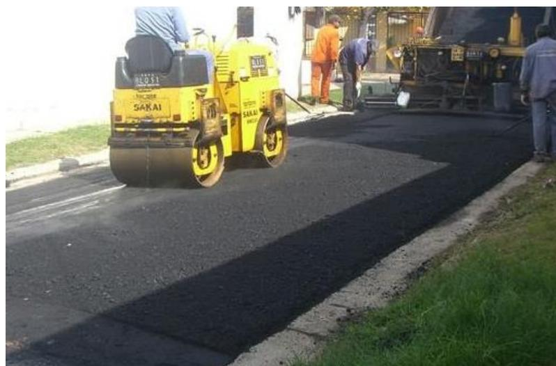
**Figura 4 - 15 .** Uniformizada la capa de carpeta, comienza la compactación de la misma mediante vibro de rodillo liso.
