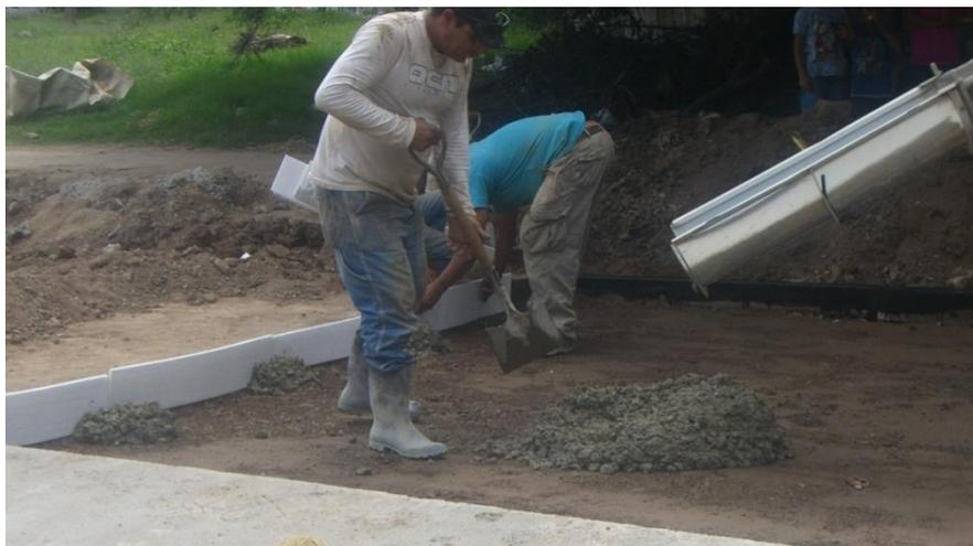
**Figura 3 - 37. Vertido del Hormigón.**
