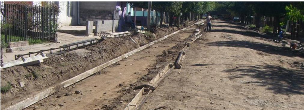
**Figura 3 - 61.** Disposición de moldes para cordón cuneta, verificando que sigan una línea recta longitudinalmente.
