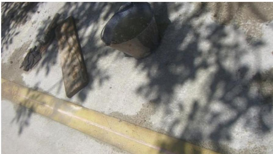
**Figura 3 - 41. Para dar terminación, se pasa una cinta húmeda por toda la superficie recién hormigonada.**
