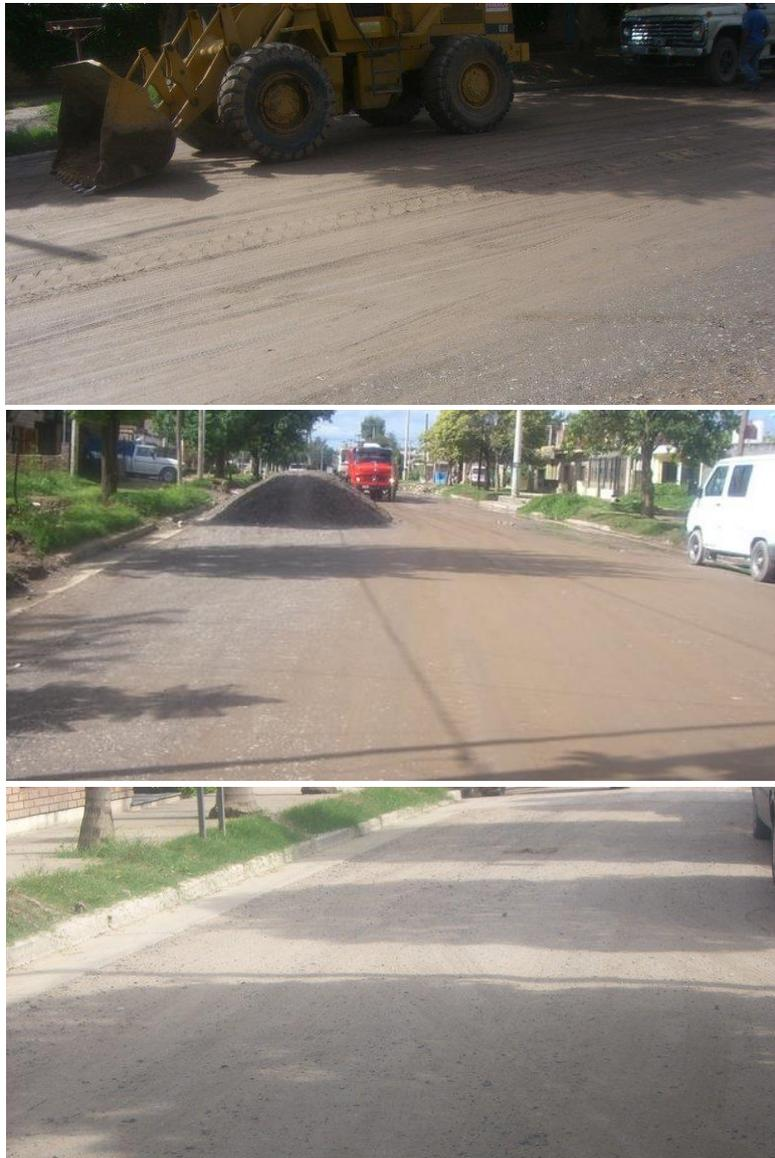
**Figura 4 - 6 . Estado final de base granular para la posterior ejecución de carpeta asfáltica.**
