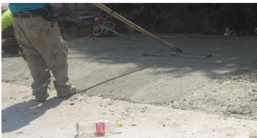
**Figura 3 - 39. Vibrado y fratachado con el que se determinan las pendientes de los planos conforme las líneas de agua.**
