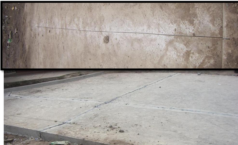
**Figura 3 - 46. Arriba, detalle de aserrado de junta. Abajo, diseño de juntas conformando paños de máximo 22.00 m<sup>2</sup>**
