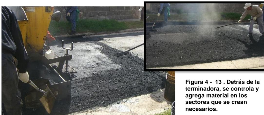
**Figura 4 - 13 .** Detrás de la terminadora, se controla y agrega material en los sectores que se crean necesarios.
