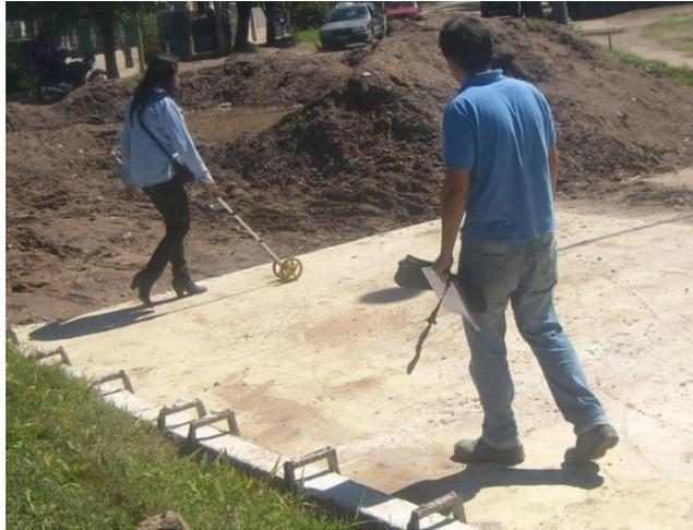
**Figura 3 - 84. Medición de la superficie de los trabajos ejecutados.**
