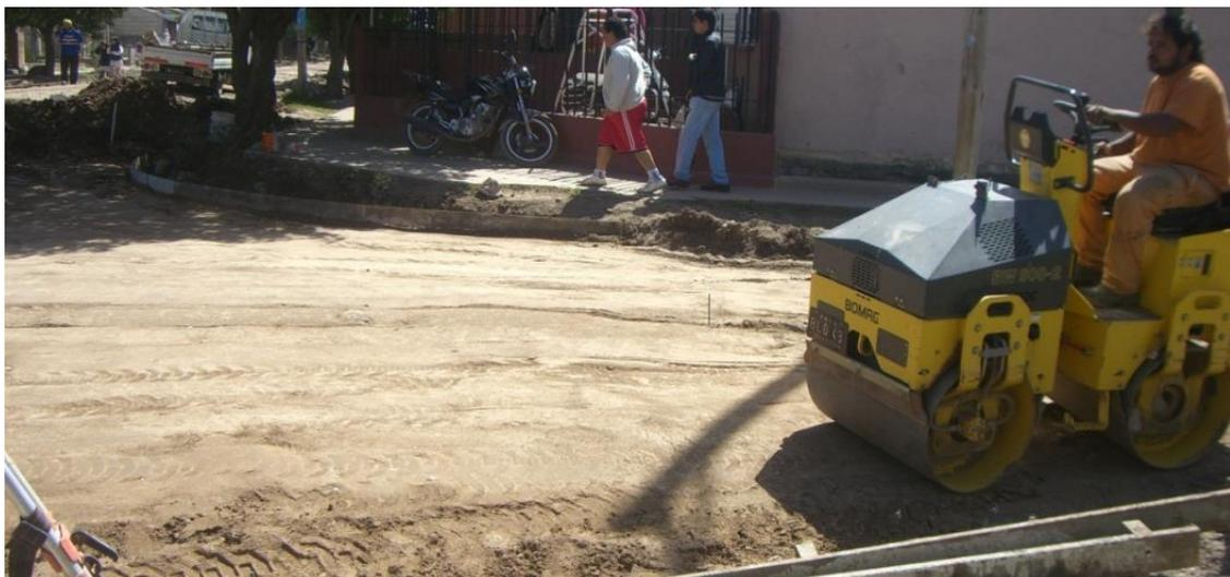
Figura 3 - 32. Compactación del material incorporado.
