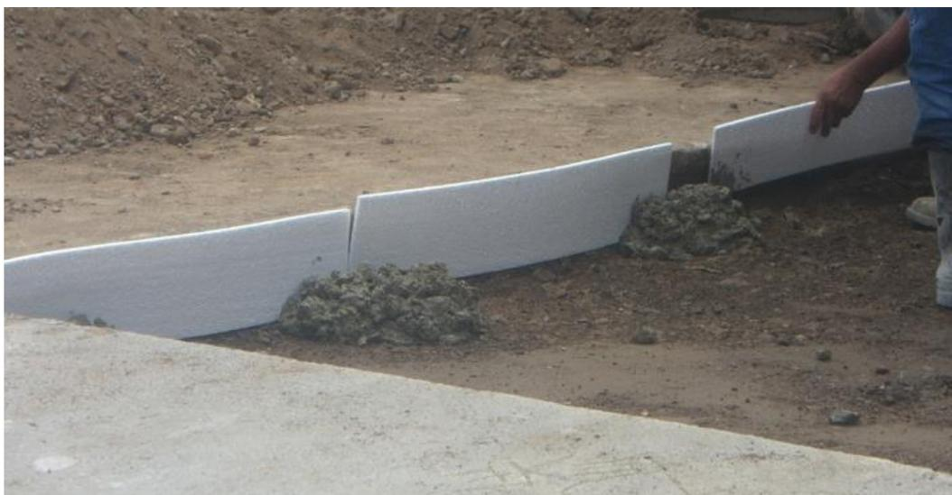
**Figura 3 - 35. Junta de Dilatación - Construcción.**
