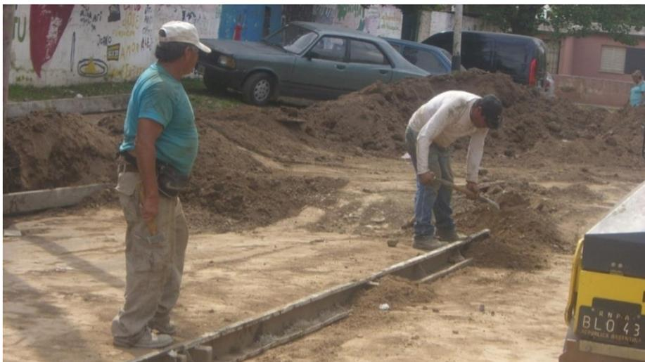
**Figura 3 - 34. Colocación y soporte de moldes.**
