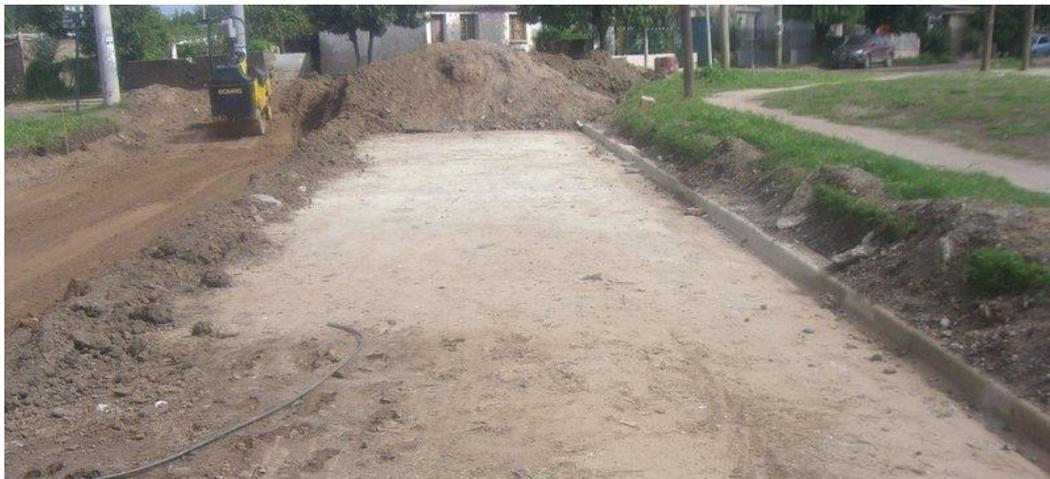
**Figura 3 - 20. Primer tramo terminado de calzada de hormigón.**
