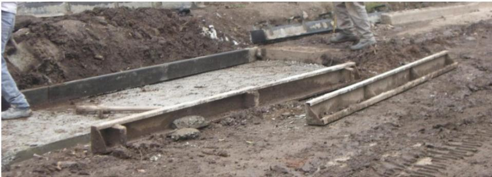
**Figura 3 - 60.** Hormigón de cuneta sobre capa de hormigón pobre.
