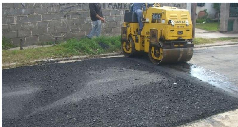
**Figura 4 - 14 .** Sellado de tramo nuevo de carpeta para dar continuidad con tramo ejecutado en período anterior.
