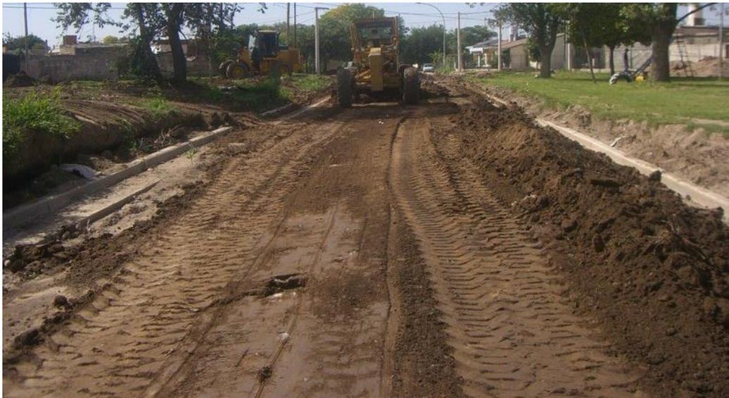
**Figura 4 - 5 . Remoción del material del cajón de calzada para lograr los niveles adecuados y la posterior ejecución de la sub rasante.**
