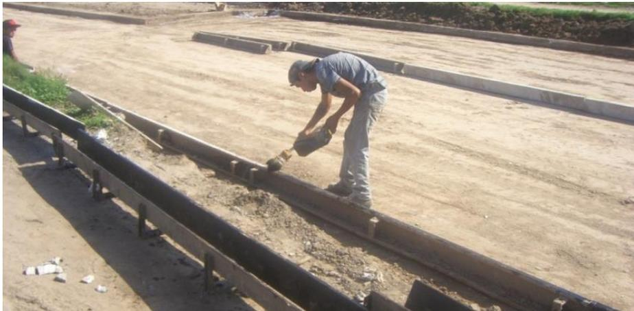
**Figura 3 - 33. Preparación de moldes. Se les aplica una mano de pintura asfáltica para facilitar el desmolde.**
