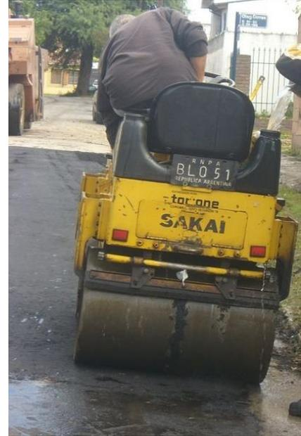
Figura 4 - 16 . Sellado del asfalto mediante rodillo neumático, esta tarea debe hacerse hasta que ya no se observen marcas de neumáticos en la superficie.
