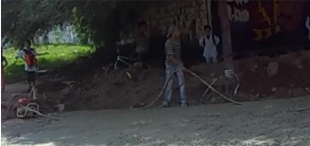
**Figura 3 - 40. Vibrado del hormigón mediante vibrador de inmersión.**
