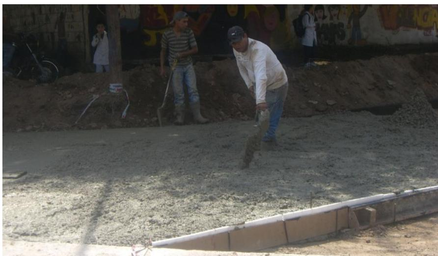
**Figura 3 - 38. Distribución del Hormigón.**
