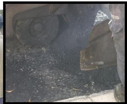
**Figura 4 - 12 . El material transportado en camión, se vuelca sobre la terminadora.**
