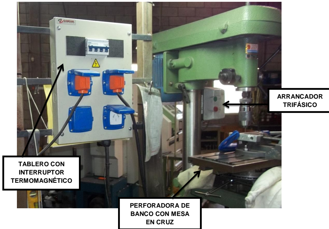
Figura 7.7 Banco de perforado con las mejoras implementadas
