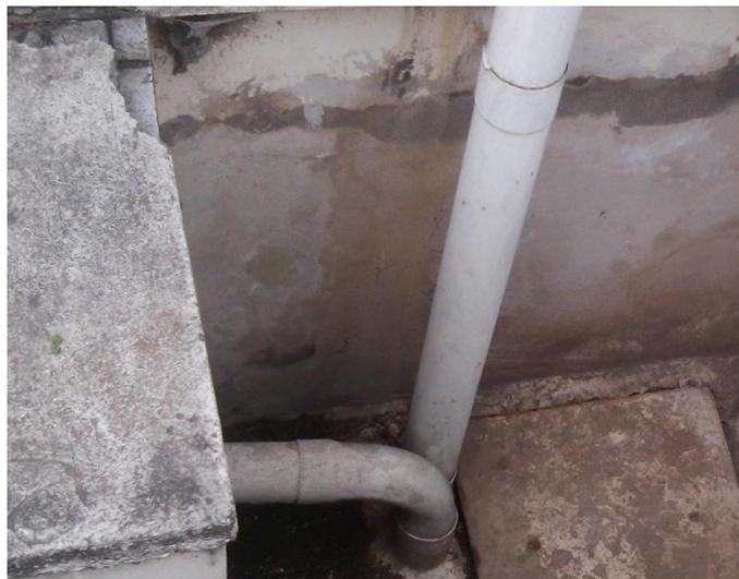
Figura 41 - Incorporación del caño pluvial en la boca de registro.
