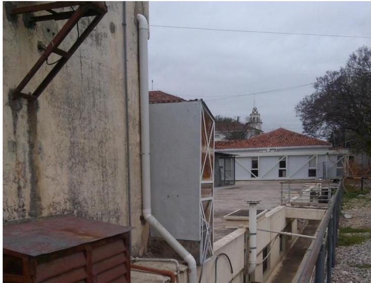
Figura 40 - Descenso de caño pluvial sobre red cloacal.
