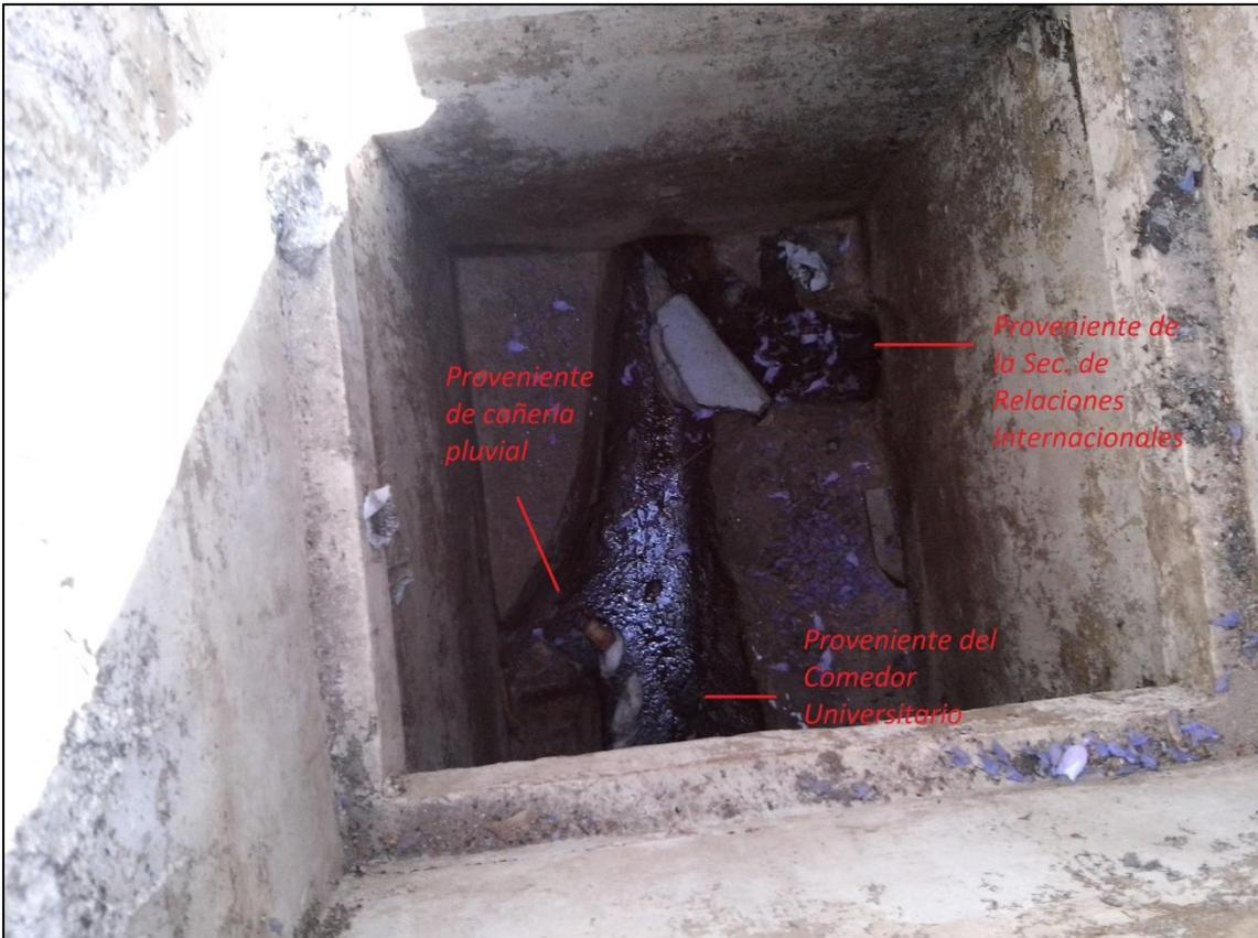
Figura 31 – Cámara de inspección N°1.
