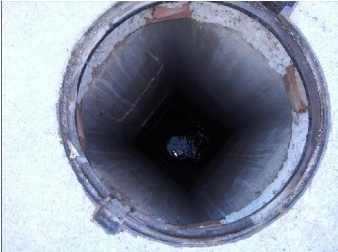
Figura 26 - Boca de registro N°3 (Plano N°2 – Anexo A) de la red cloacal, con acumulación de líquidos.
