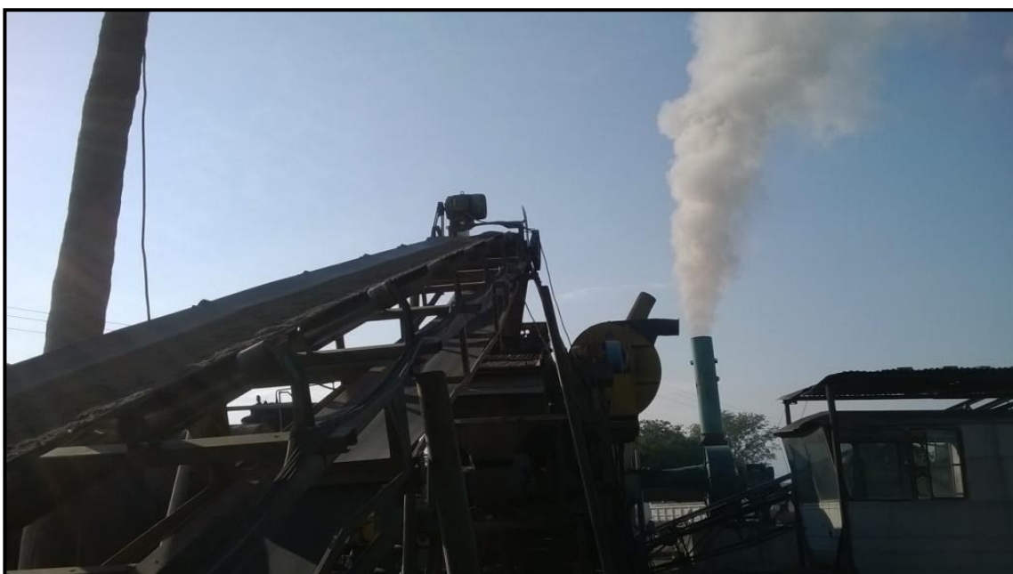
Imag. 3—3 Planta de asfalto en funcionamiento
