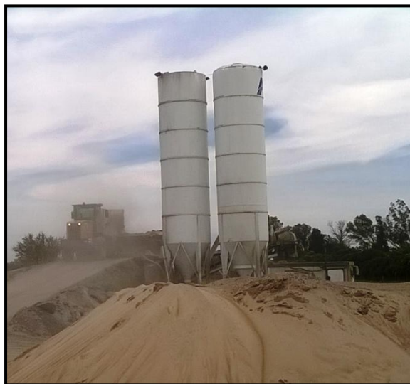
Imag. 4—5 Tolvas de cemento portland
