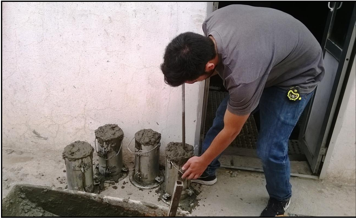
Imag. 5—11 Preparación de probetas de hormigón
