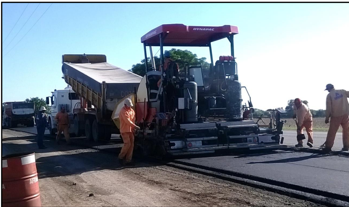
Imag. 5—7 Terminadora trabajando sobre el tramo
