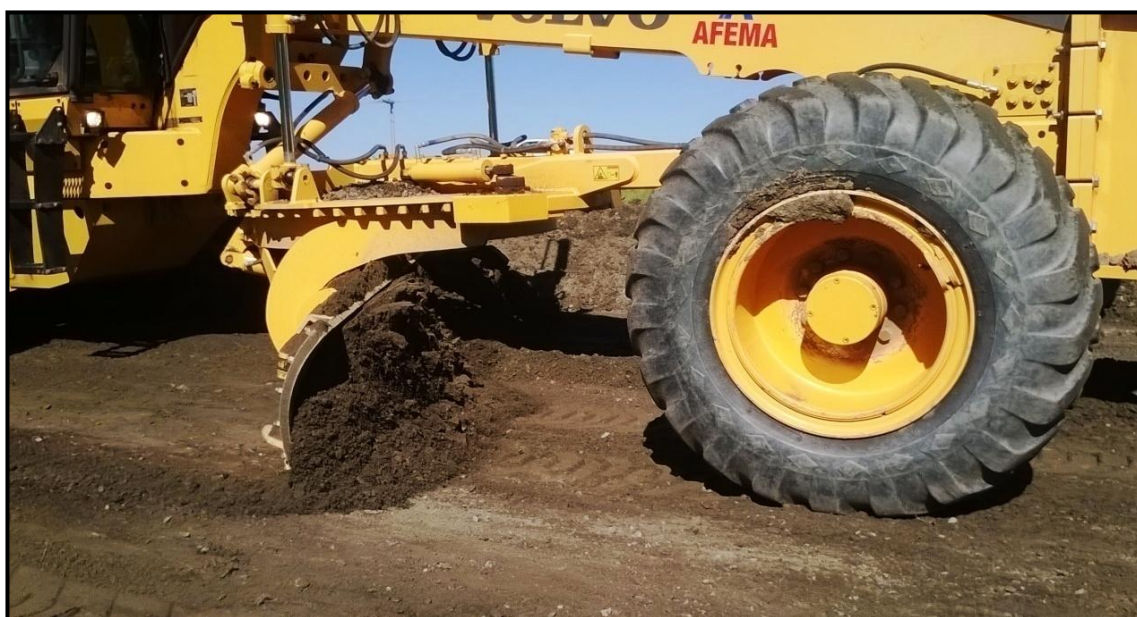
Imag. 5—3 Motoniveladora distribuyendo material
