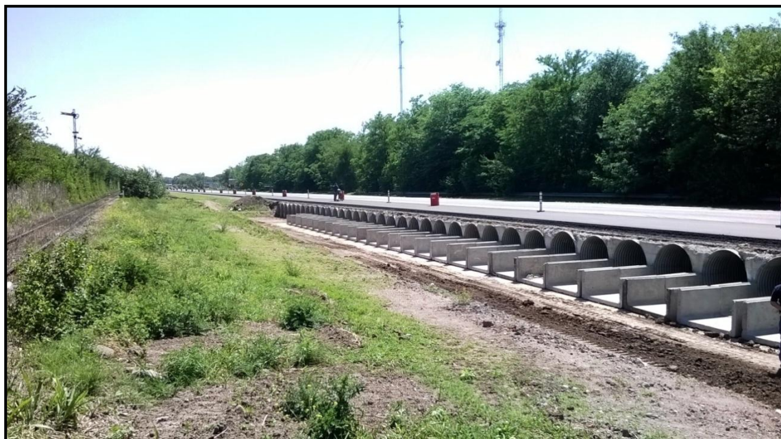
Imag. 2—2 Ensanche de alcantarillas transversales, con mas de 30 bocas.
