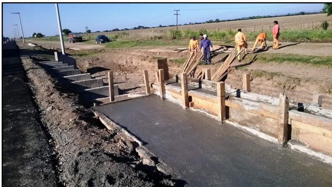
Imag. 5—13 hormigonado de ensanche de alcantarilla
