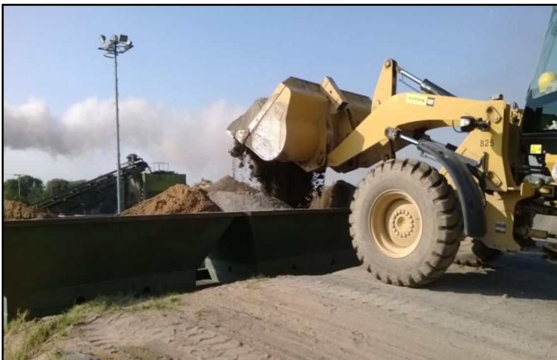
Imag. 3—2 Pala de carga frontal cargando material
