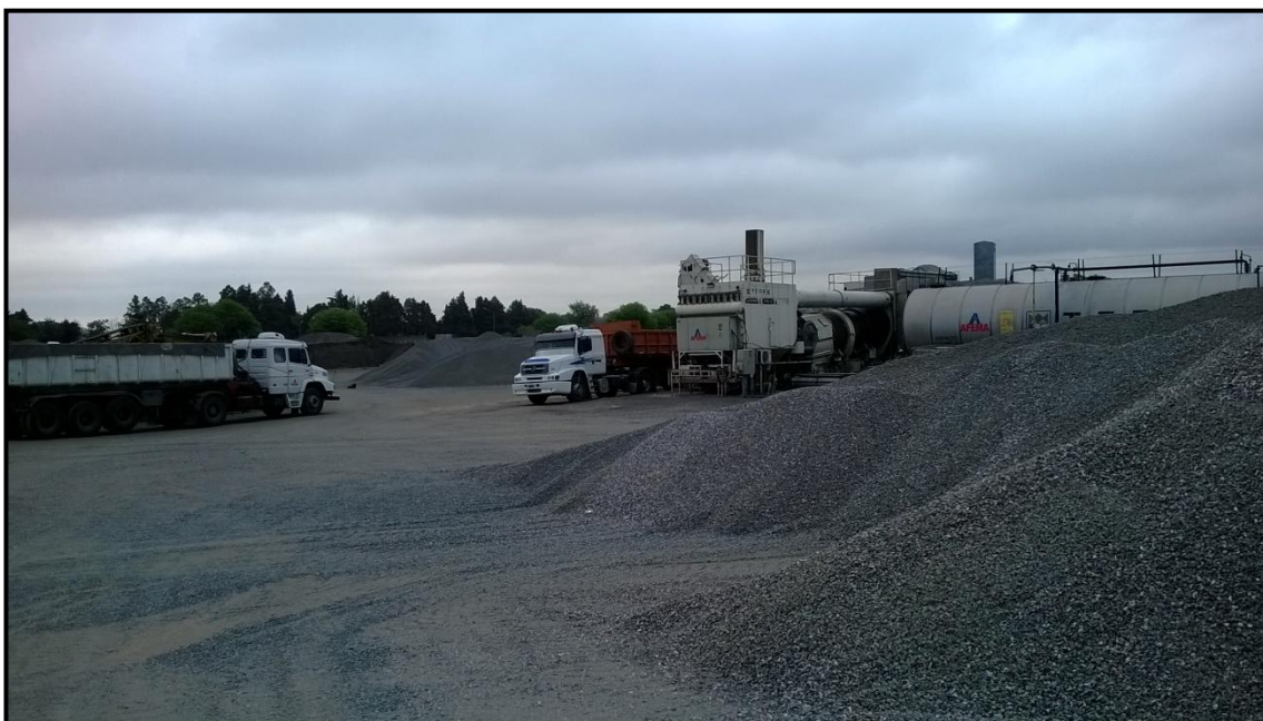
Imag. 3—1 Acopios triturados y camiones descargando material
