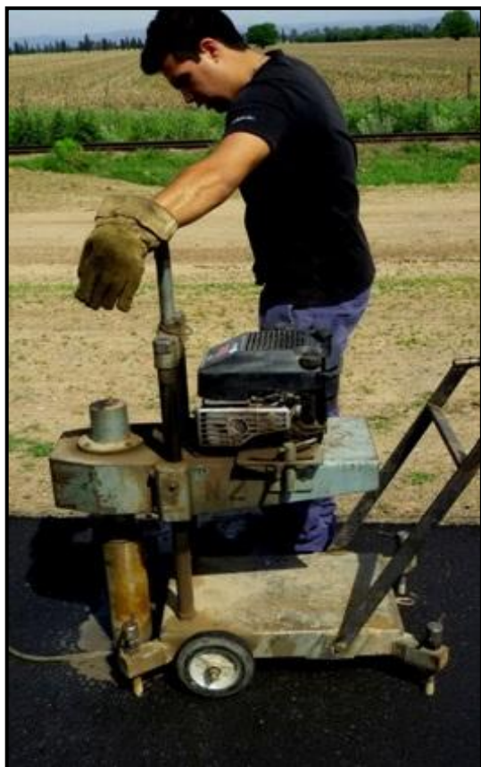
Imag. 5—8 Extracción de testigos de base asfáltica
