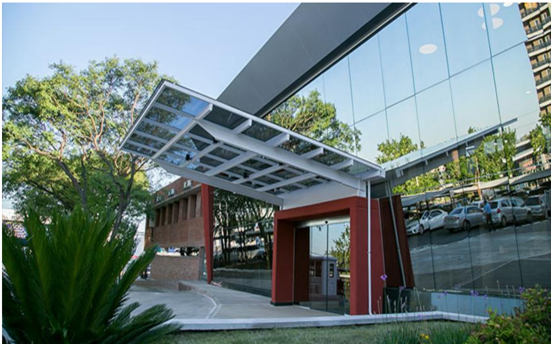
Figura 1: Fachada de ingreso al Instituto Modelo de Cardiología
