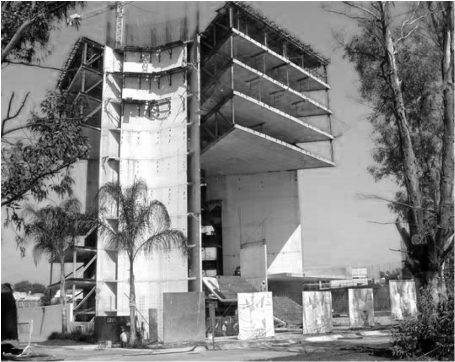
Esquema resistente a la torsión
