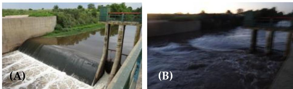
*Figura 96: Azud San Marcos (A) caudal 13,56 m<sup>3</sup>/s (B) caudal 232,75 m<sup>3</sup>/s. Se puede observar que para el caudal extremo el azud se encuentra ahogado y su funcionamiento hidráulico difiere.*
