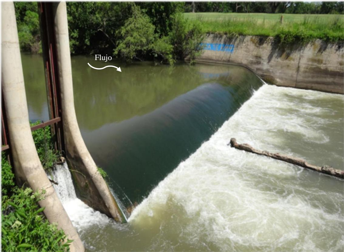
*Figura 36: Sección de aforo en el río Tercero (Ctalamochita) ubicada en el azud Bell Ville.*
