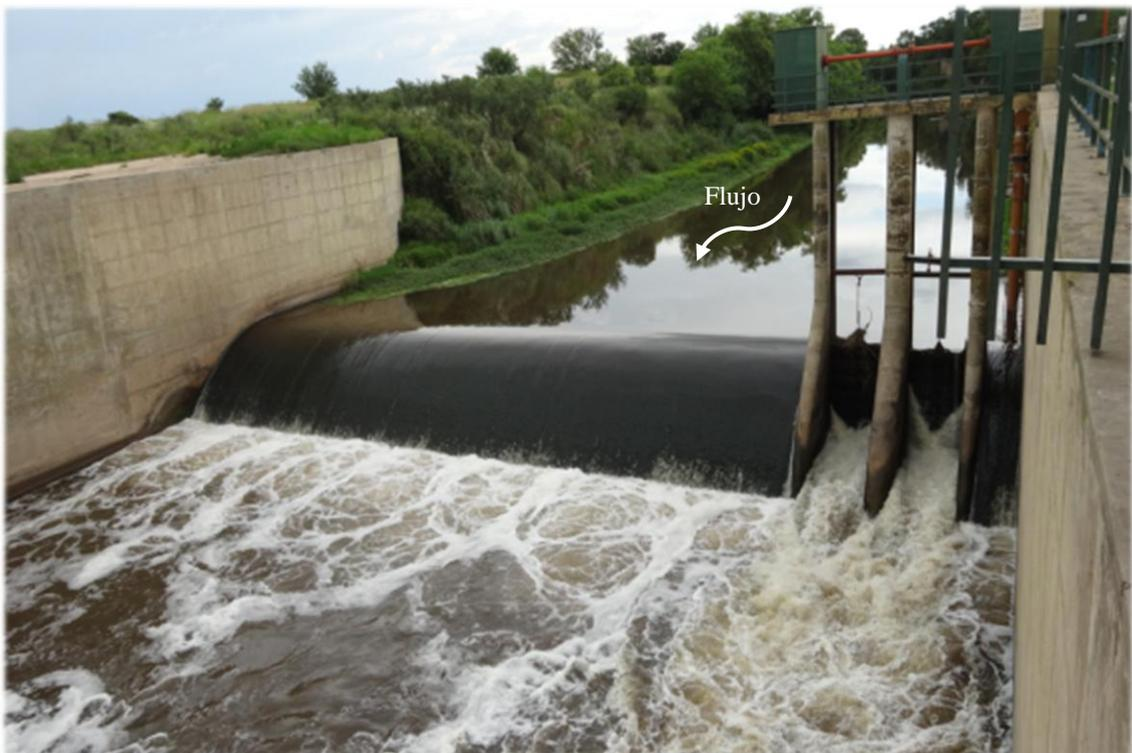
*Figura 40: Sección de aforo en el río Tercero (Ctalamochita) ubicada en el azud San Marcos.*
