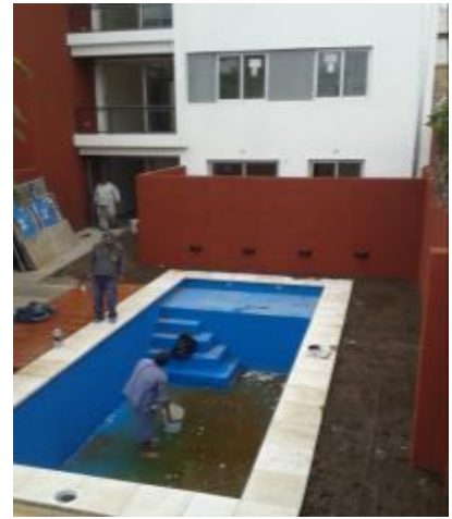
Fachada NE. Fachada hacia patio
