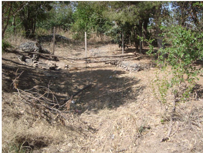
Figura 20: Engavionado en el cementerio Bajo Grande.
