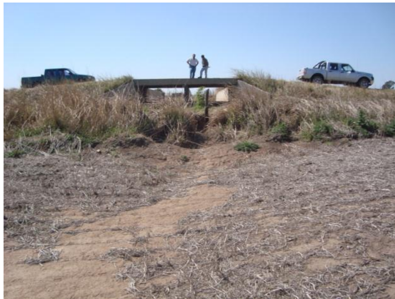
Figura 22: Canal Los Molinos-Córdoba y Desagüe.
