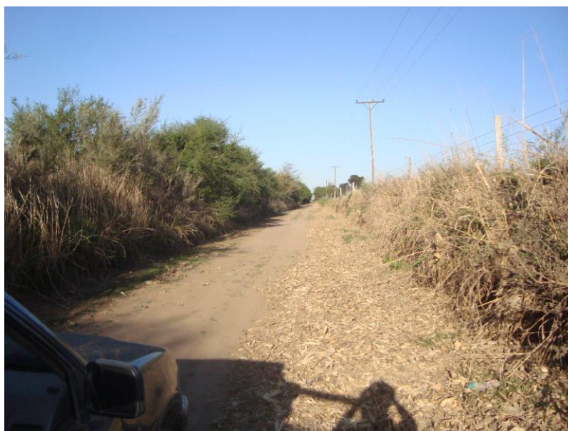
Figura 15: Camino socavado por acción del agua.
