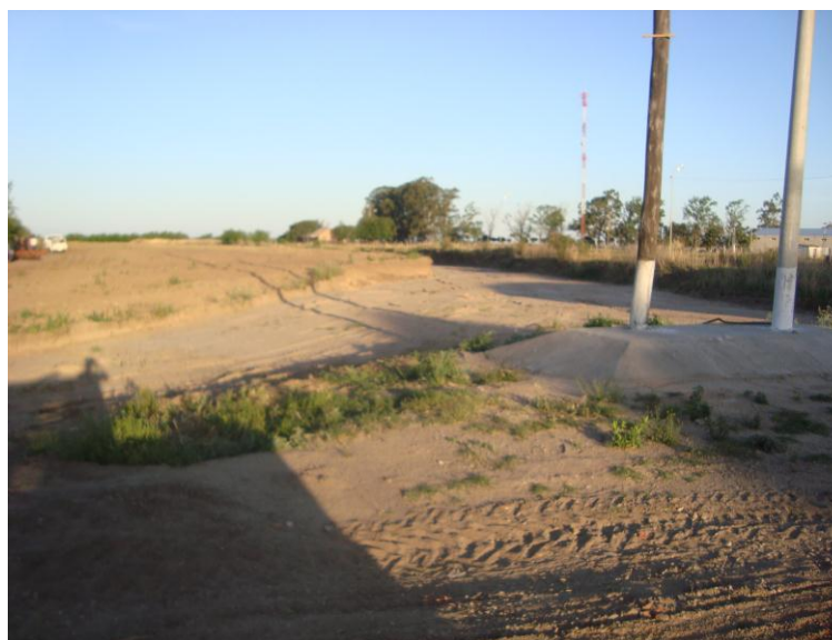
Figura 23: Desagüe en Lozada.
