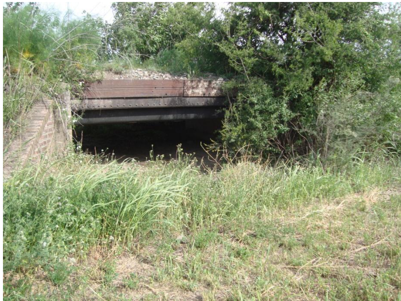
Figura 17: Alcantarilla en la vía ferroviaria .
