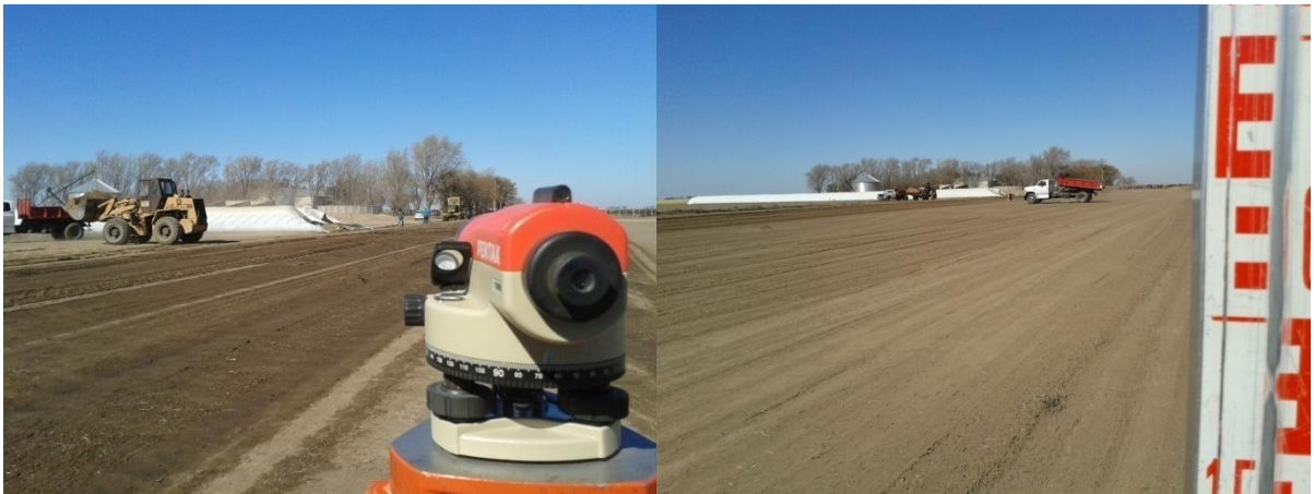
Figura 37: Fotografías nivel óptico y regla utilizados en la nivelación para corral de feed-lot
