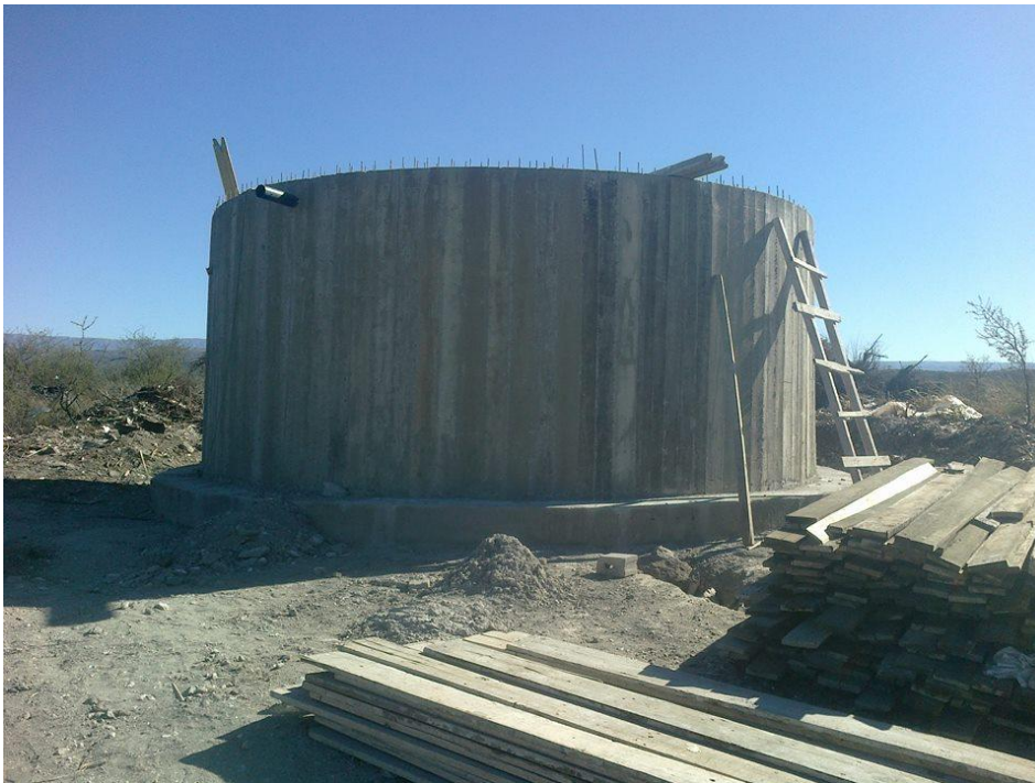
Figura 29: Tanque de agua en segunda etapa (fundación + pared circular lateral)
