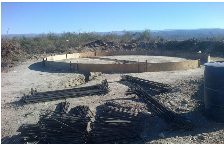
Figura 28: Fotografía encofrado de fundación de tanque.
