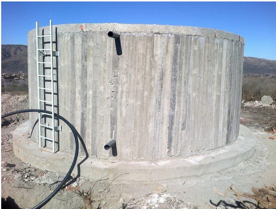
Figura 30:Fotografía tanque de agua terminado(escalera de inspección +Tubería de admisión +Tubería de descarga)
