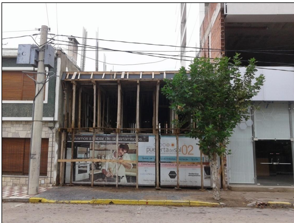
Figura 18: Obra de edificio anexo.
