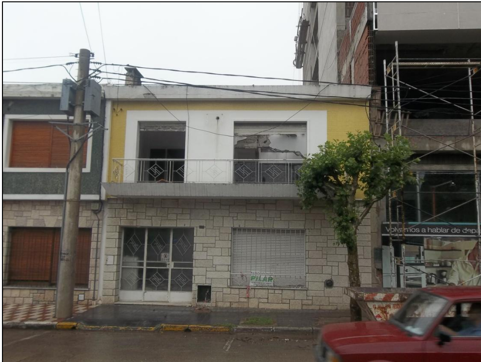
Figura 17: Fachada de vivienda lindante a demoler.
