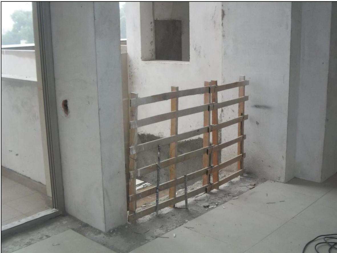
Figura 11: Vallado en borde de losa.
