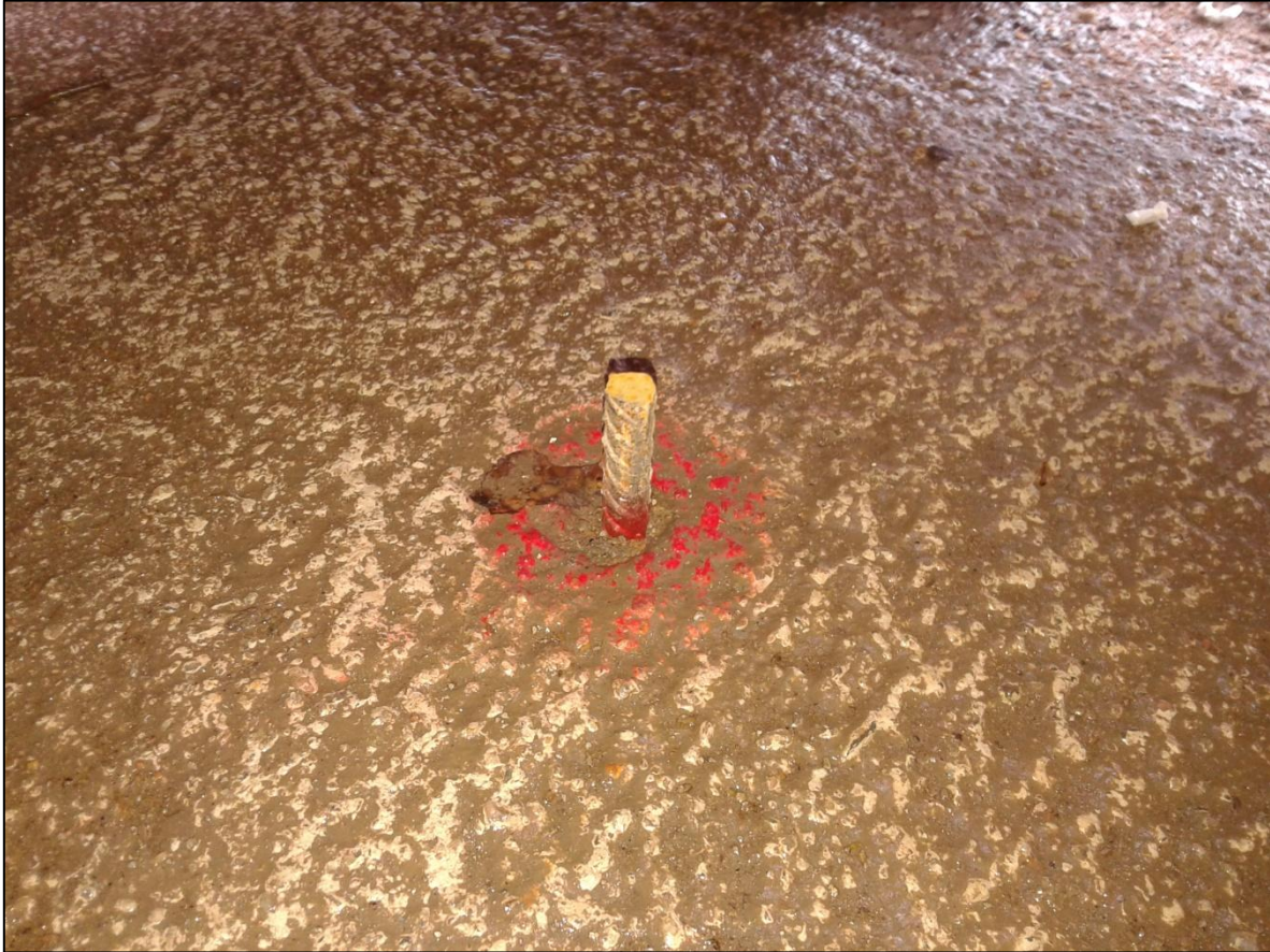
Figura 27: Estaca de referencia correspondiente a eje de replanteo.
