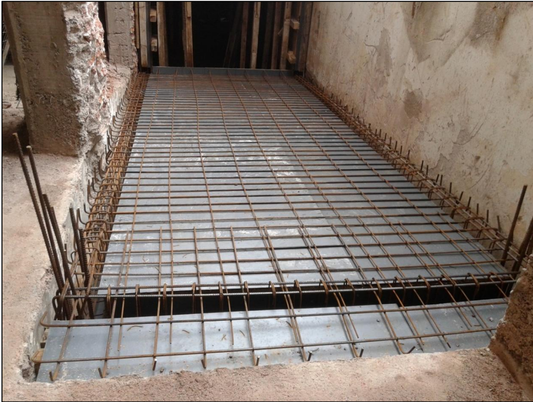
Figura 24: Armadura de losa maciza en edificio Puerta del Sol II anexo.
