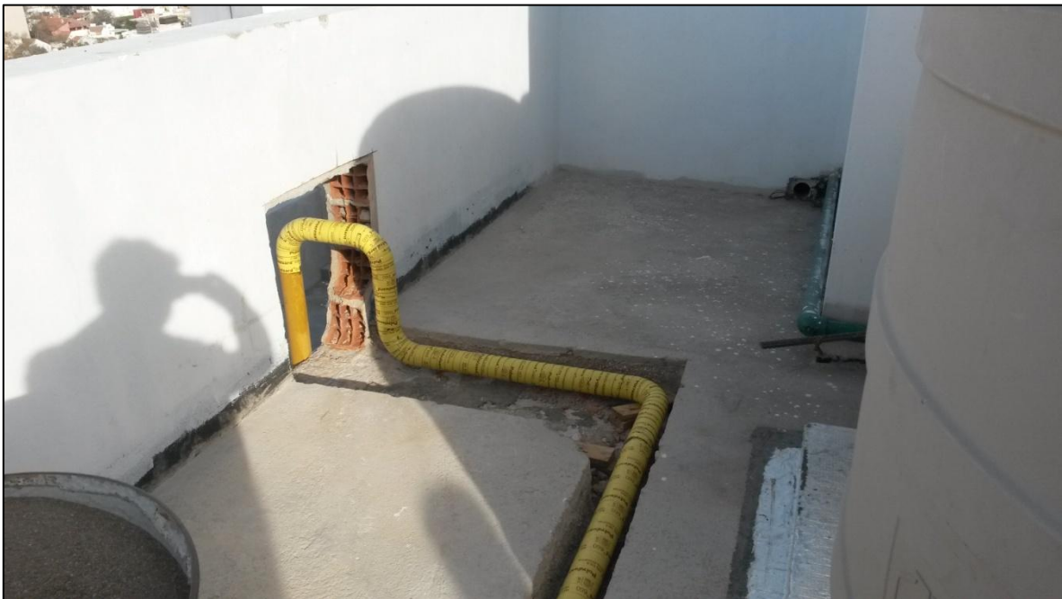
Figura 39: Unión soldada cañería de gas de 3" con imprimación y recubrimiento.
