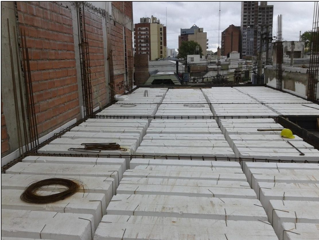
Figura 25: Losa nervurada del edificio Puerta del Sol II anexo.
