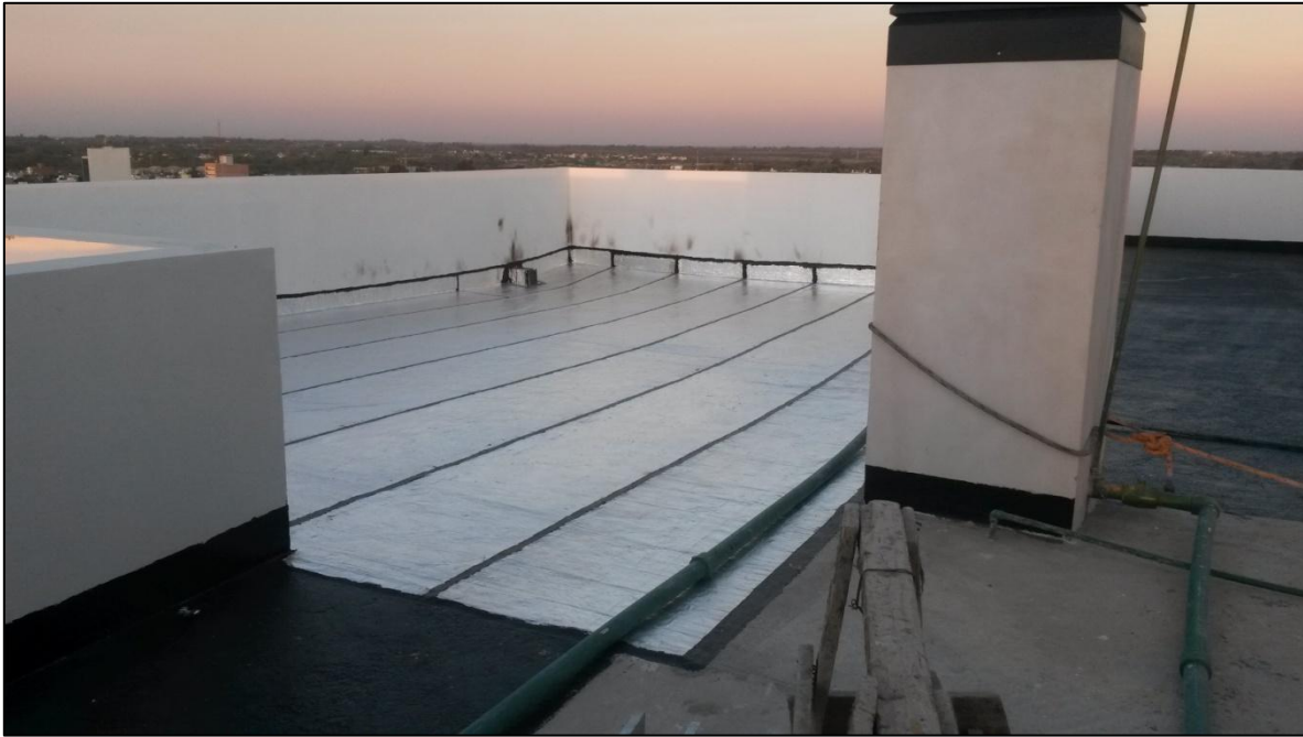
Figura 64: Colocación de membrana asfáltica con aluminio en cubierta de techo.
