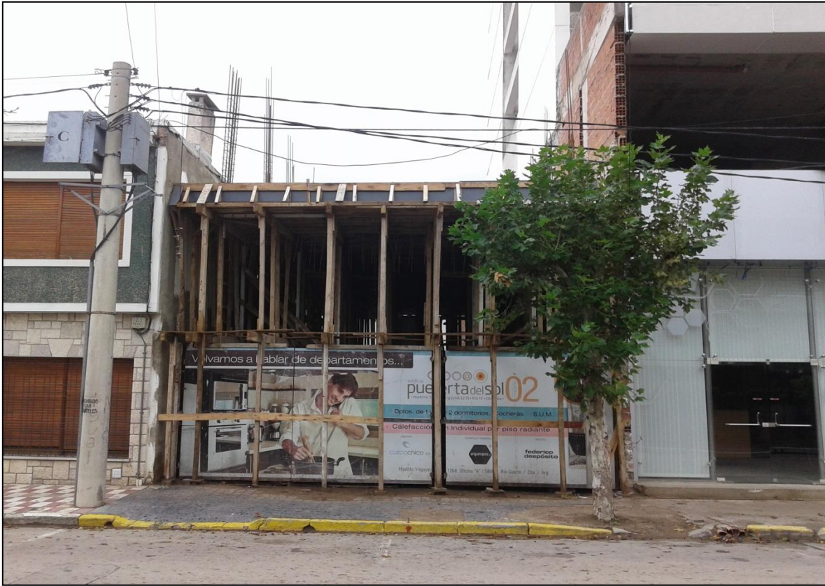
Figura 4: Obra en construcción de edificio anexo.
