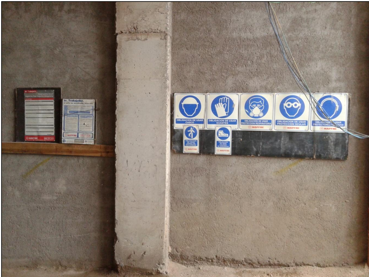
Figura 12: Señalizaciones de obligación.
