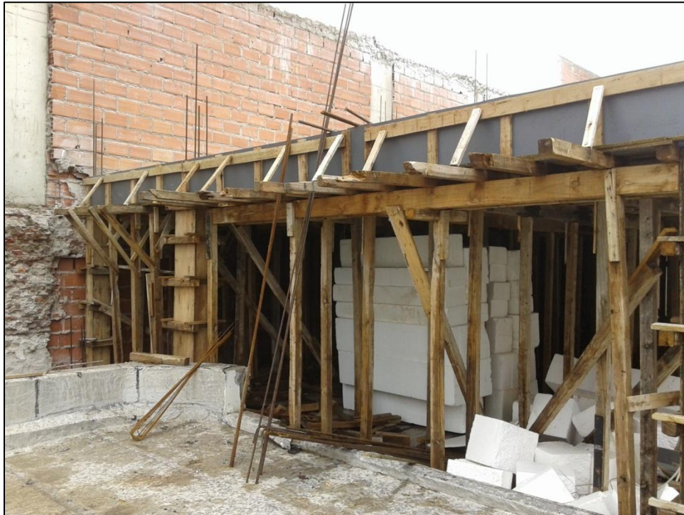
Figura 22: Encofrado de losa. Edificio Puerta del Sol II anexo.
