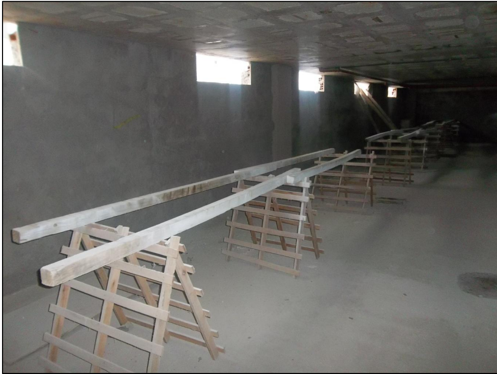
Figura 58: Taller de pintura en obrador de Puerta del Sol II.
