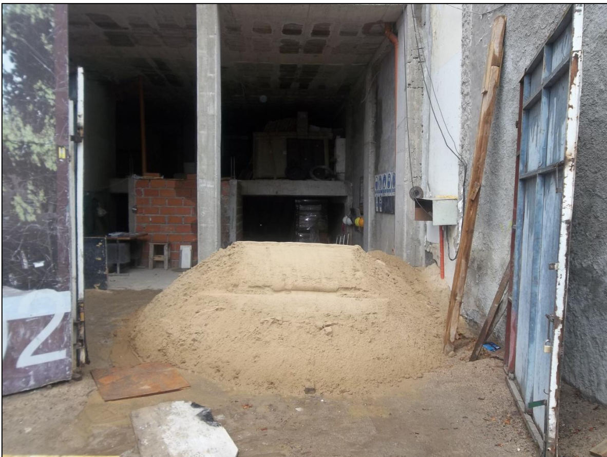
Figura 5: Acopio de arena en depósito abierto frente a portón de ingreso a la obra.
