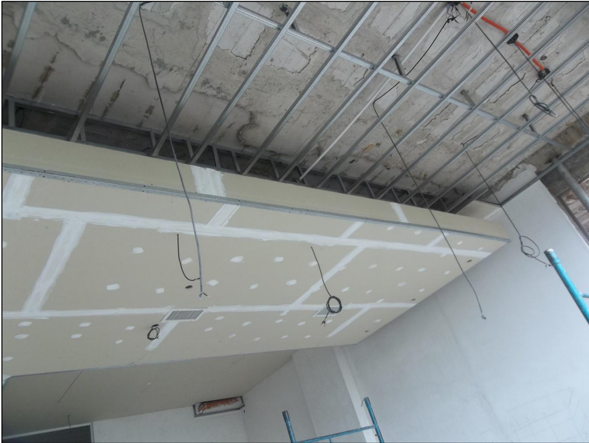
Figura 34: Cielorraso en Durlock en oficina de planta baja de edificio Puerta del Sol II.
