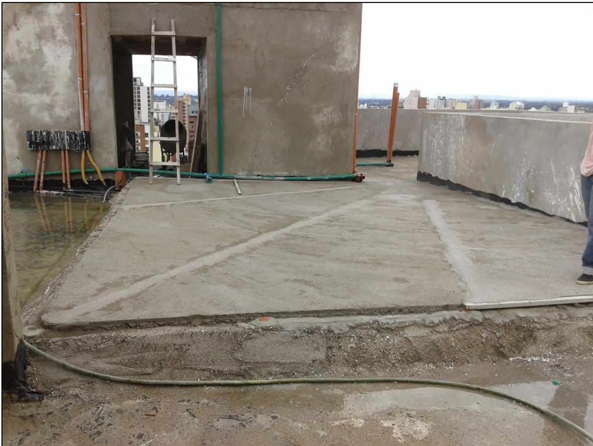
Figura 63: Cubierta de techo
