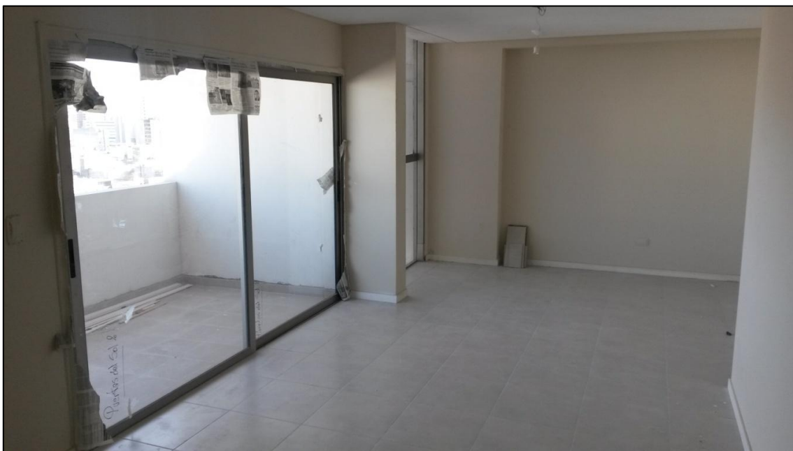
Figura 54: Puerta ventana corrediza de aluminio anodizado.
