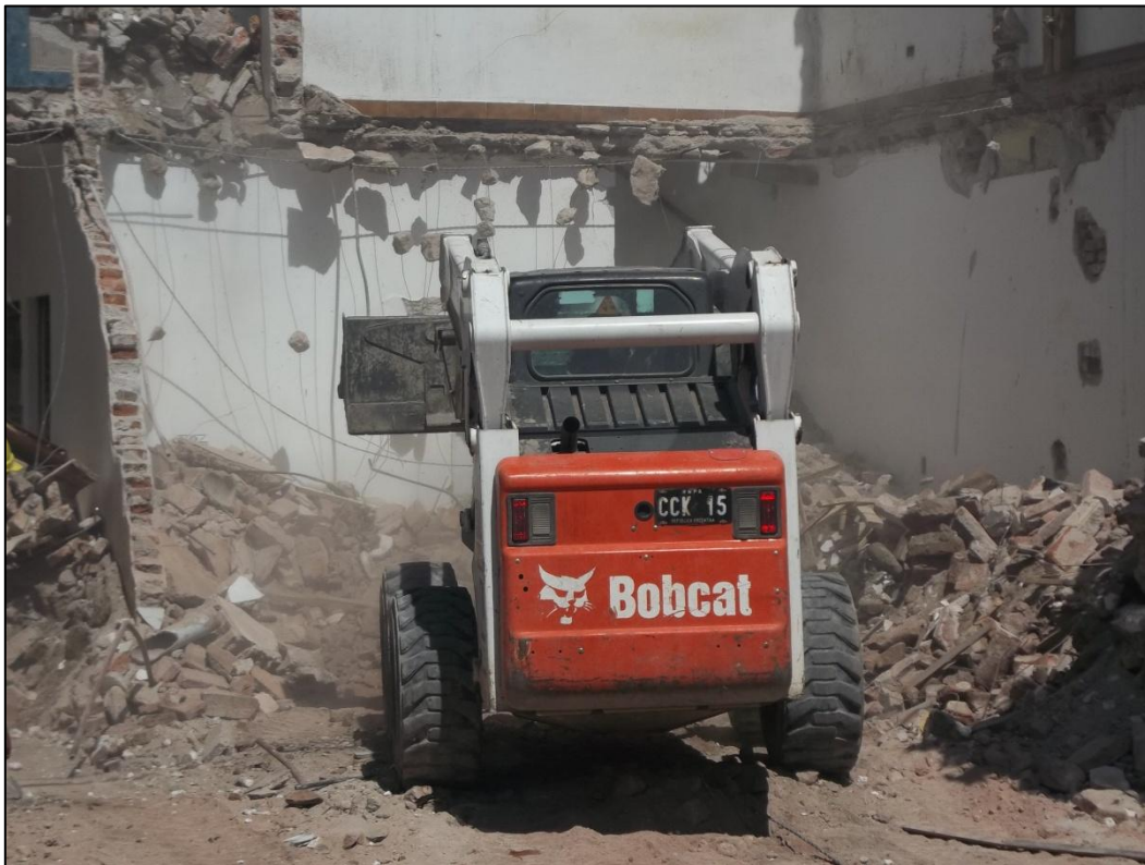
Figura 15: Máquina trabajando en la demolición de la vivienda existente.
