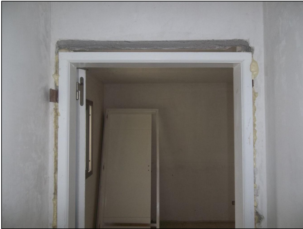
Figura 52: Colocación de marco de madera.
