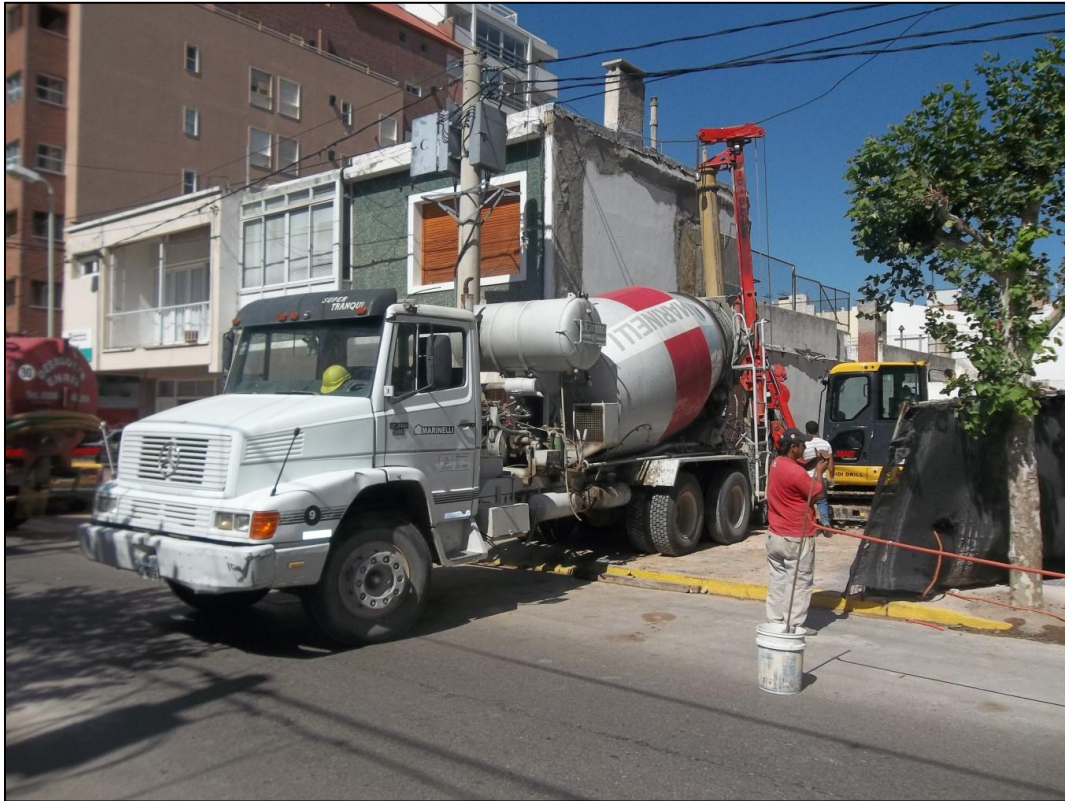
Figura 20: Hormigonado de pilotes en edificio Puerta del Sol II anexo.
