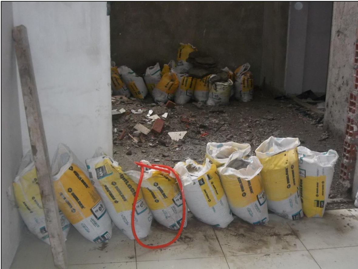
Figura 10: Embolsado de escombros para retirar de la obra.
