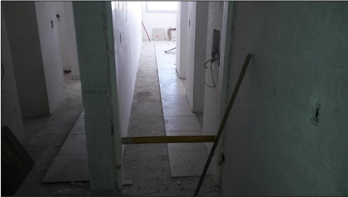
Figura 44: Colocación de porcellanato en departamento "E" (Puerta del Sol II).
