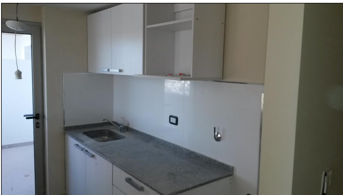
Figura 46: Revestimiento de cocina en departamento “E” (Puerta del Sol II).
