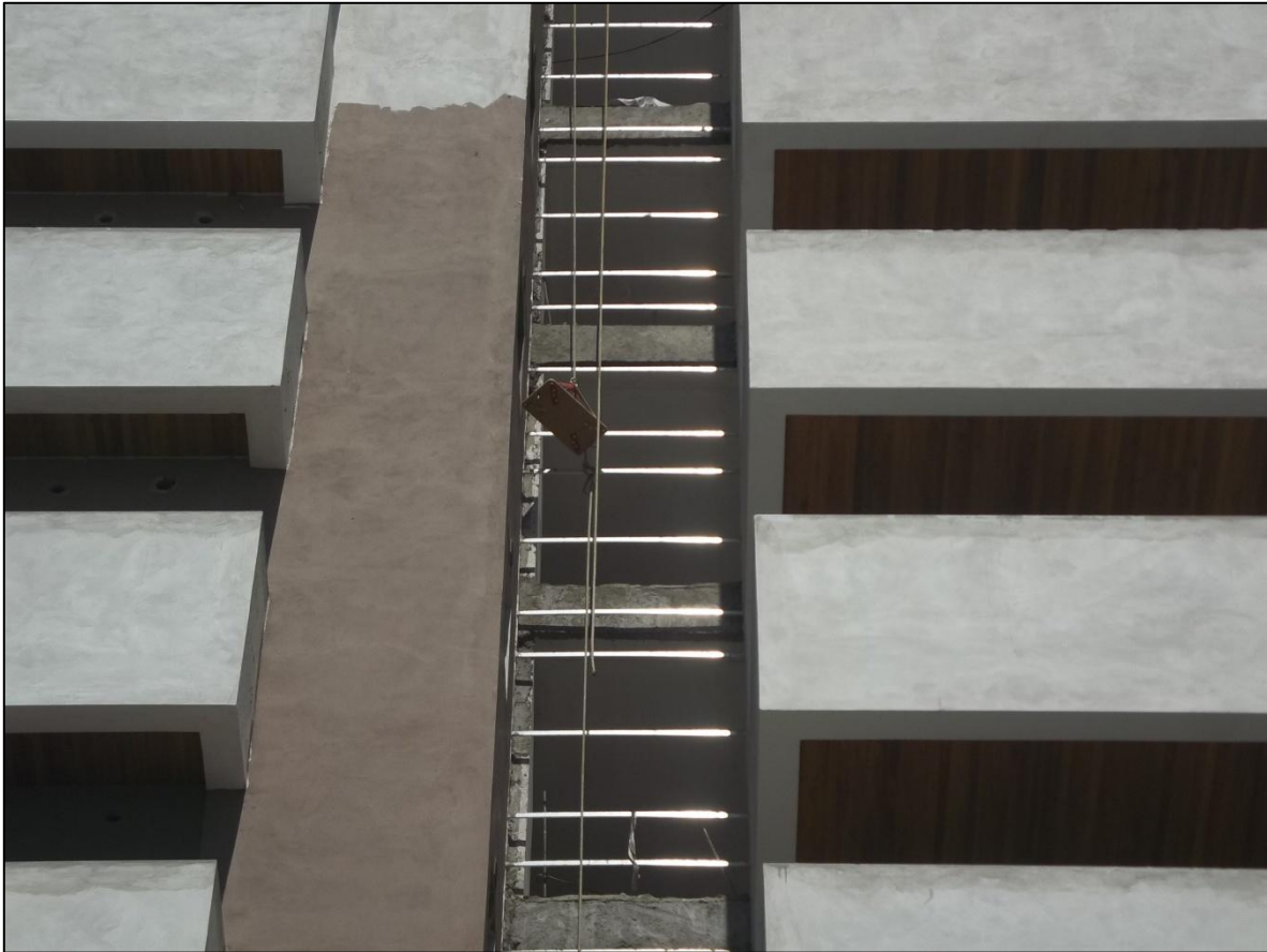
Figura 56: Aplicación de revestimiento plástico en fachada de Puerta del Sol II.
