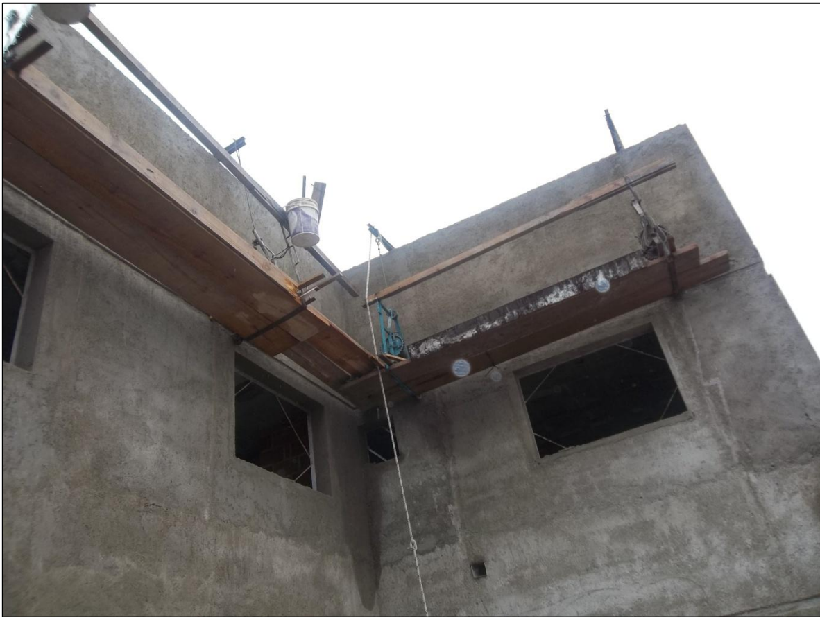
Figura 29: Disposición de andamios colgantes para revoque exterior.
