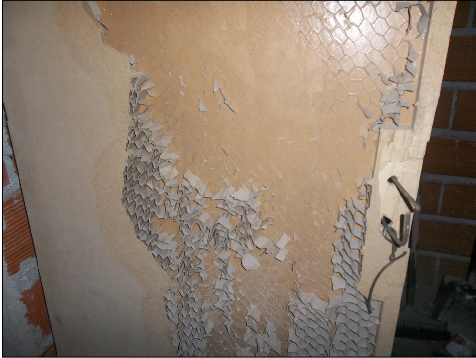
Figura 51: Interior de hoja de madera.
