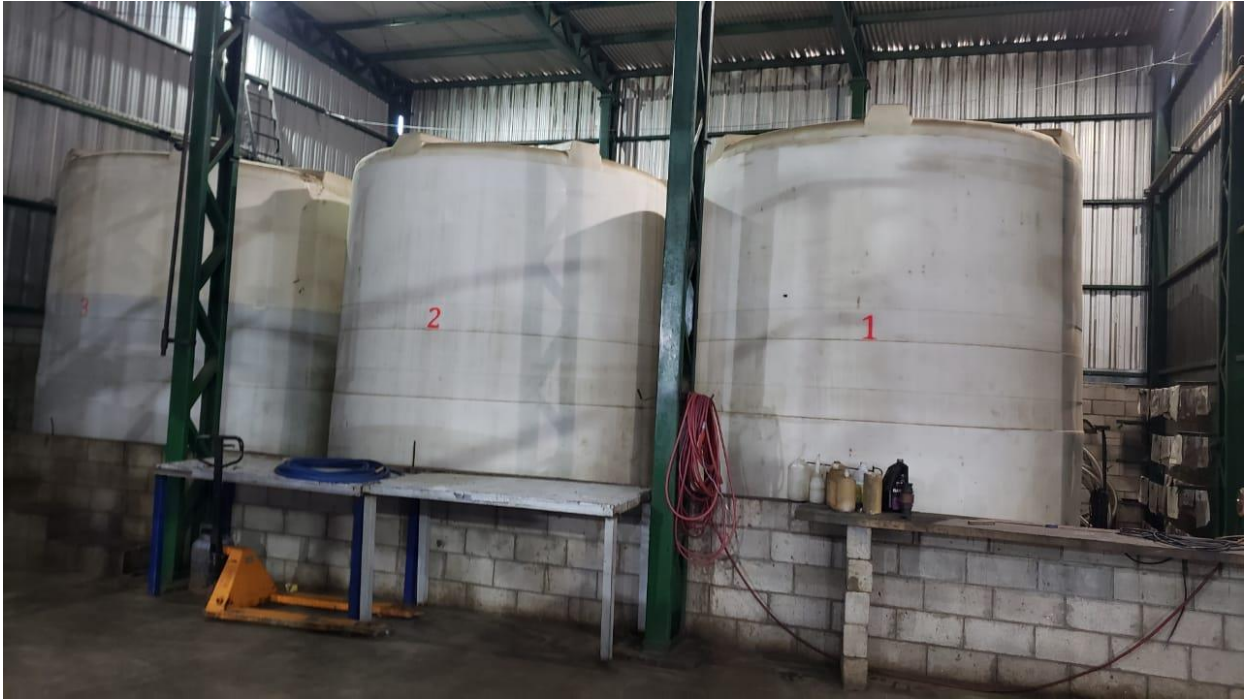
Figura 31: Tanques para el depósito final de aceite en la empresa Barbieri
