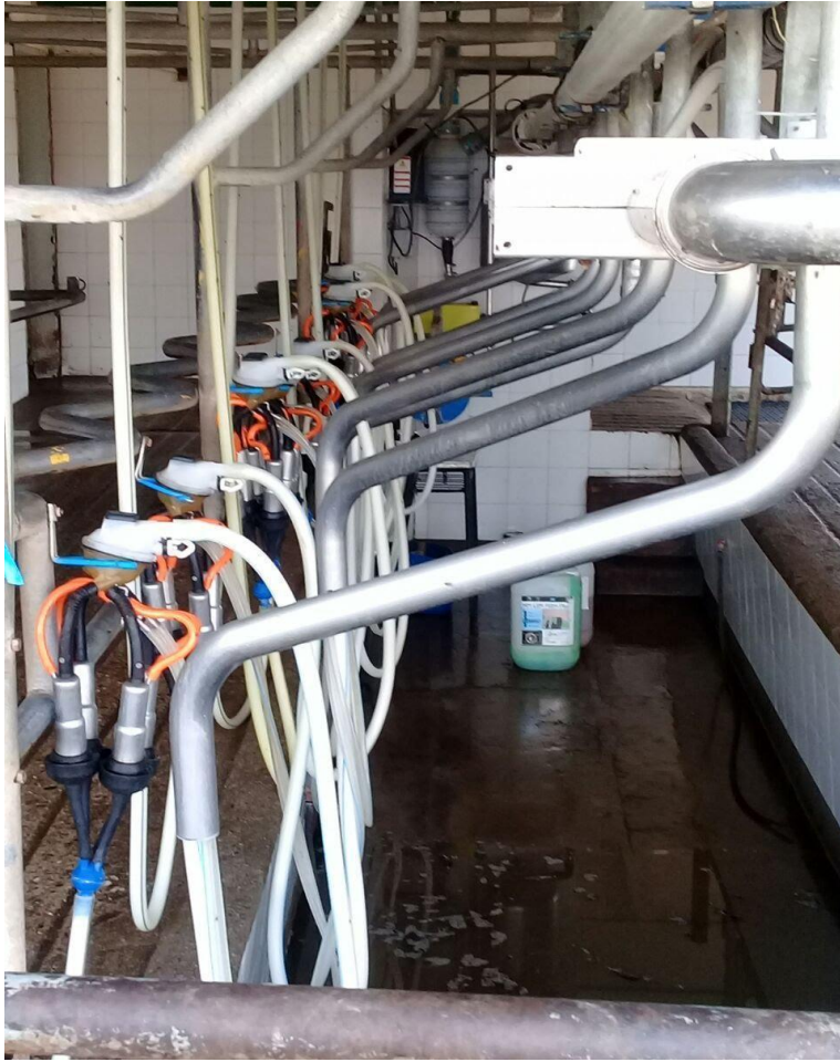
Figura 6: Sala de ordeño e instalaciones del Tambo Escuela FCA - UNC.
