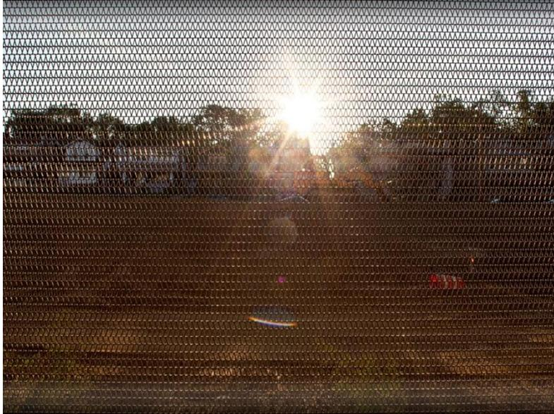
Figura 4-5: Estructuras abiertas – Reducción del resplandor solar
