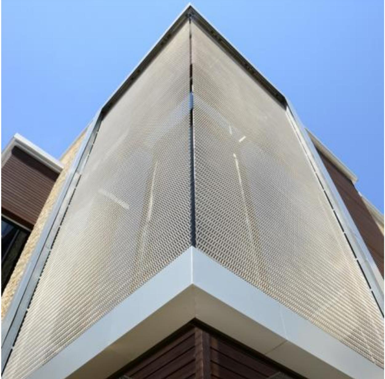
Figura 5-42: En esta imagen se puede observar el prolijo encuentro entre ambas mallas generando una sensación de continuidad de los paneles
