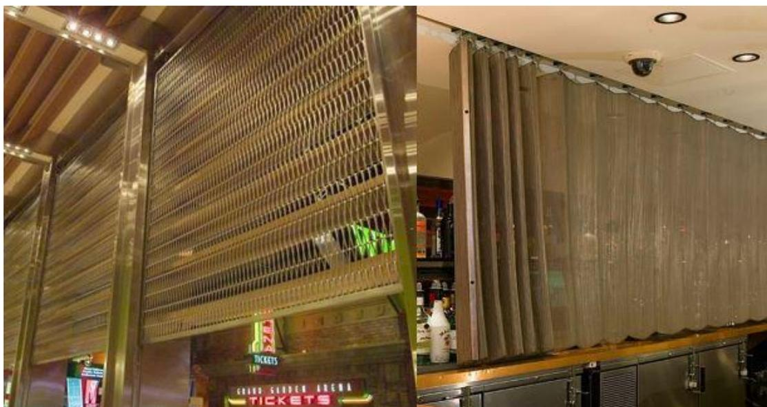
Figura 4-35: Ejemplos de sujeción tipo Cortina, con deslizamiento vertical y horizontal
