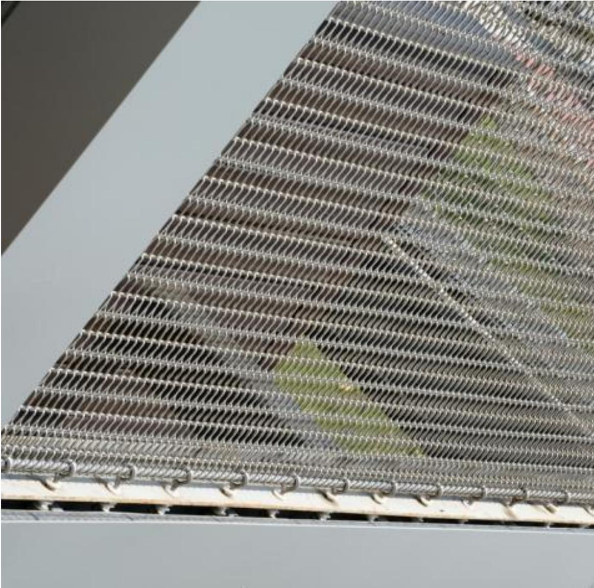
Figura 5-43: Aquí se puede observar en detalle la instalación del sistema Eyebolt. Es posible notar cómo los pernos se unen a la malla a través de una varilla que los atraviesa
