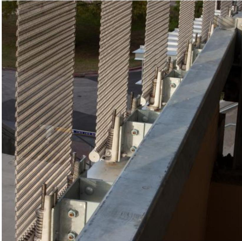
Figura 5-26: Instalación inferior de las mallas metálicas Mid-balance
