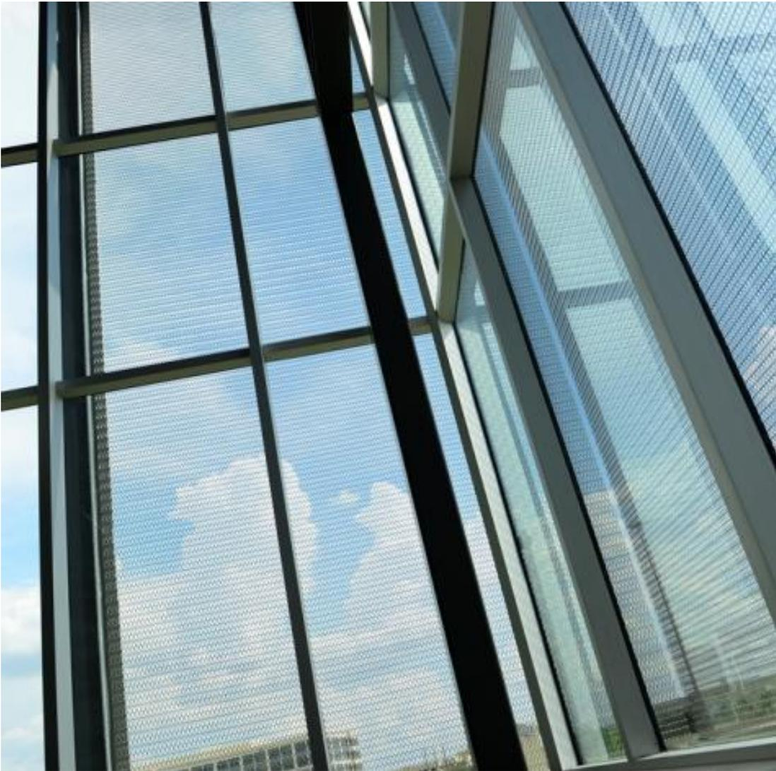
Figura 5-44: Imagen tomada desde el interior del edificio, en la cual se puede notar que la malla actúa como protectora del interior del edificio contra el resplandor solar, sin afectar la visual de los clientes
