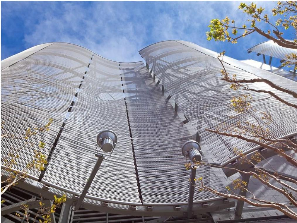
Figura 4-21: Sujeción de los paneles curvos
