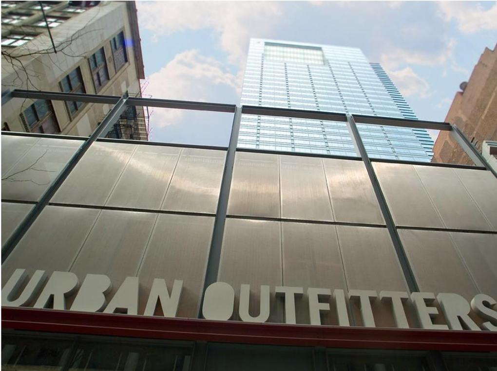
Figura 4-19: Mallas arquitectónicas utilizadas en la marca corporativa de una tienda
