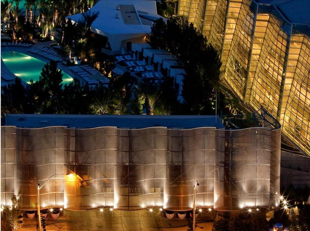
Figura 4-22: Reflejo de luz blanca nocturna en fachada de malla metálica
