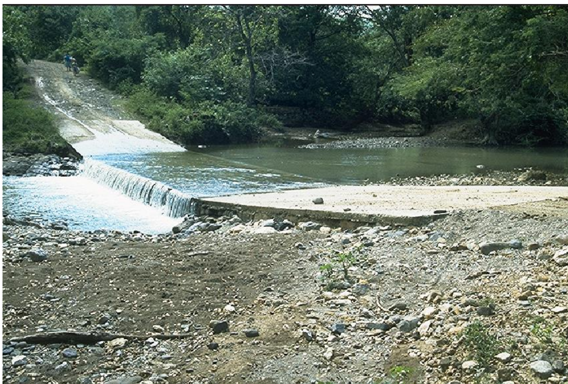
Figura 31: Vado de losa de hormigón en camino rural
