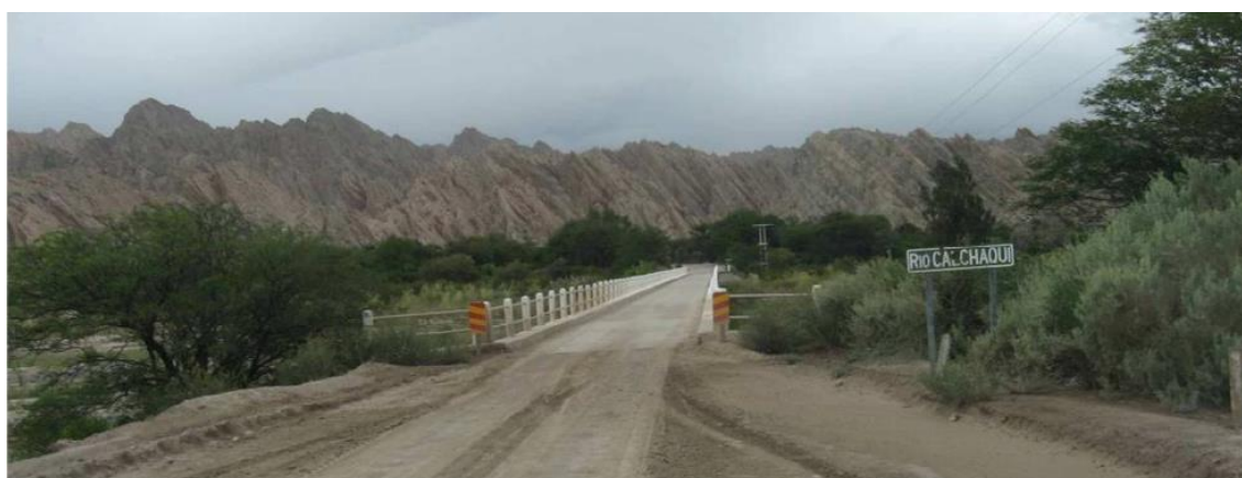
Figura 6: Puente sobre Río Calchaquí
