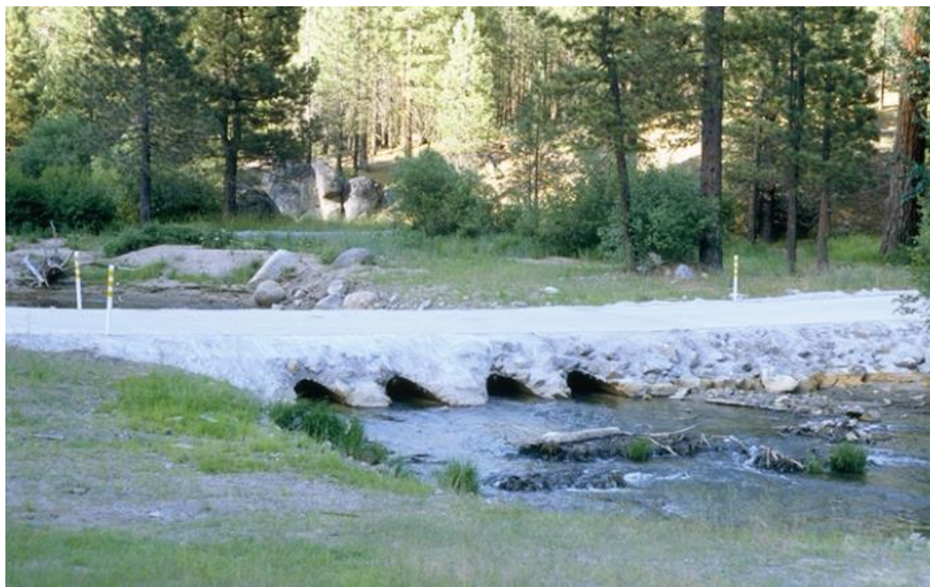
Figura 32: Alcantarilla vado en cruce de arroyo
