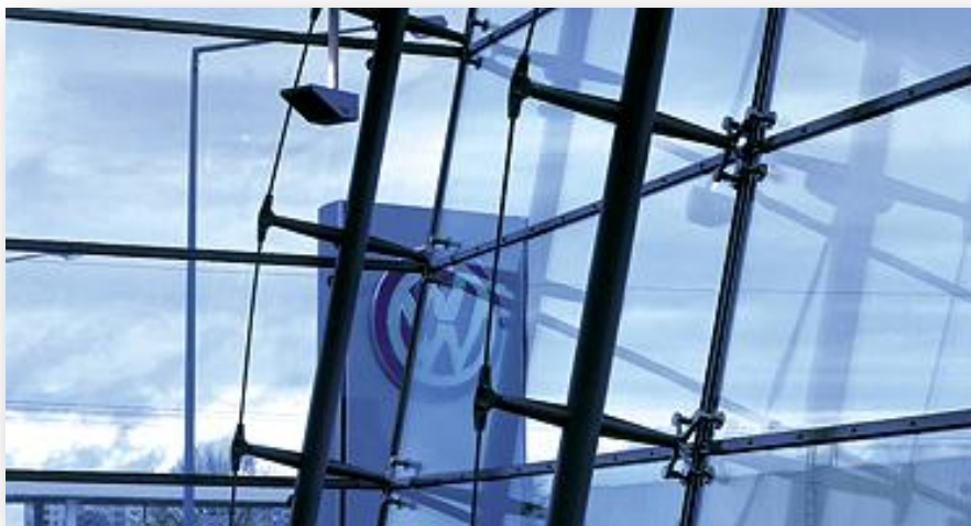
Ilustración 3.8: Vista Fachada de cristal: piel de vidrio
