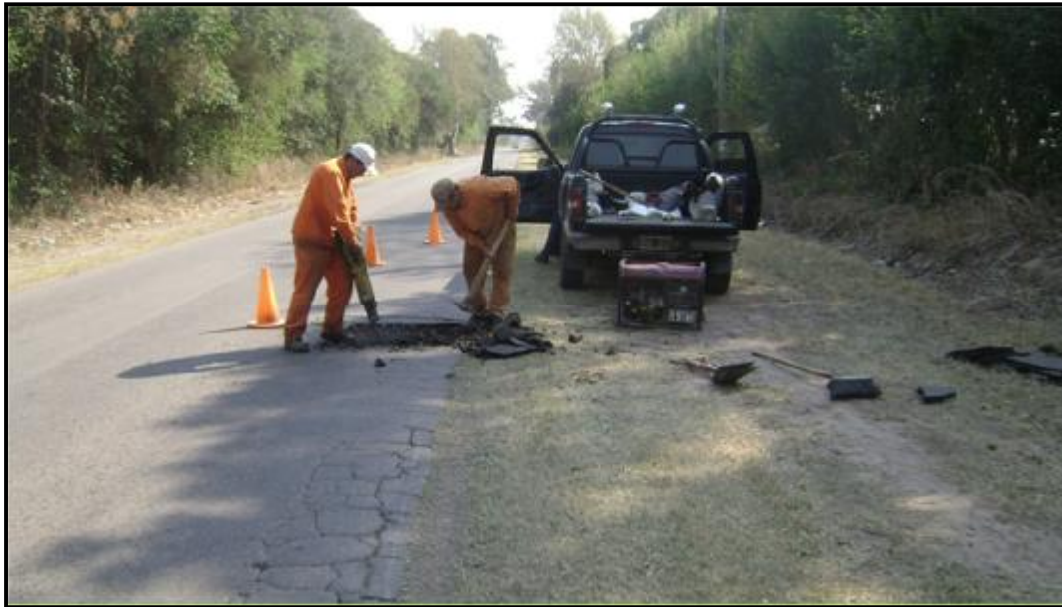
Figura 5 Ejecucion de calicatas
