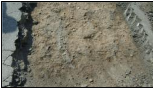
Figura 6 Limpieza de calicata
