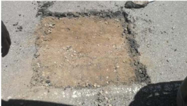
Figura 114 APERTURA DE CALICATA
