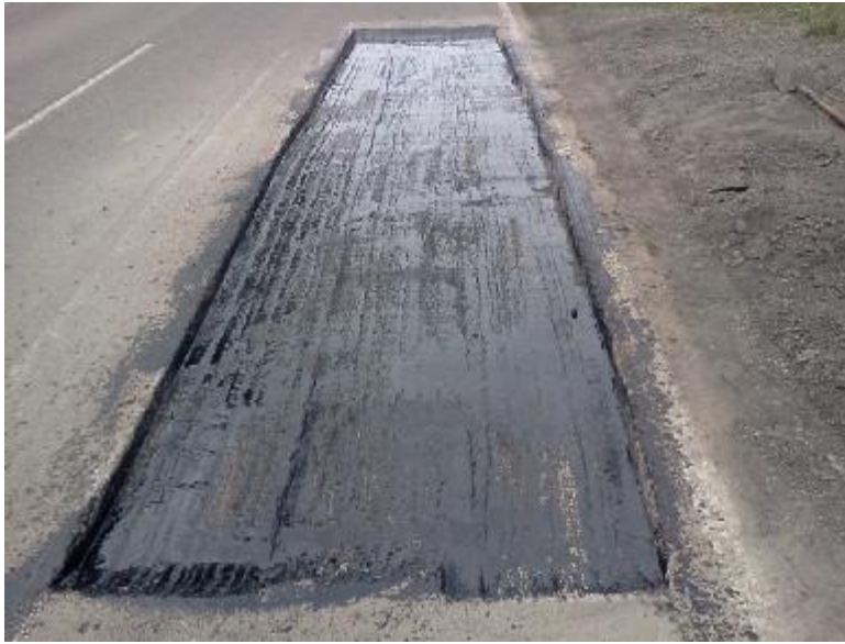
Figura 119 BACHEO CON FRESADORA
