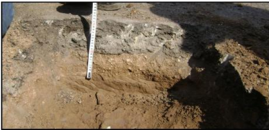
Figura 8 Espesores en calicata
