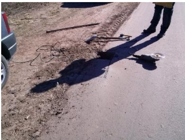
Figura 136 EXTRACCION DE PAÑOS DE CARPETA ASFALTICA
