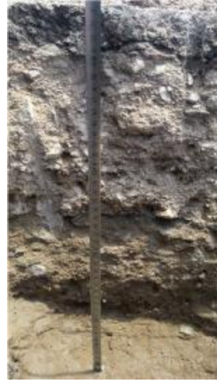
Figura 113 ESPESORES DE ESTRUCTURA EN CALICATA
