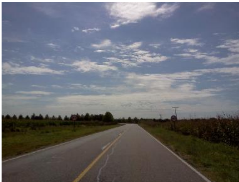
Figura 118 ESTADO DE LA OBRA PREVIA A LA EJECUCION DE LA CARPETA
