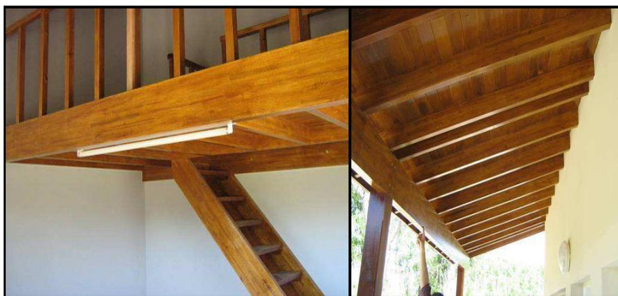
Fig. 1.9. Tirantes, largueros, tablas y machimbre fabricados con madera de lamo. Estos materiales son utilizados en la construccin de viviendas. Vista de una vivienda rural para el personal de campo en el Bajo Delta.
