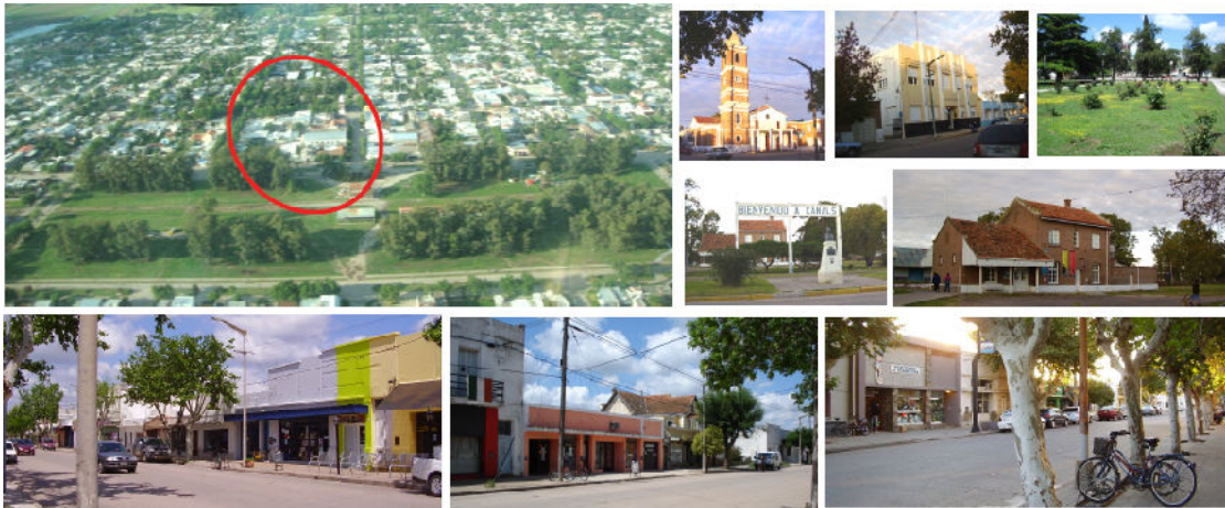
IMÁGENES DEL NODO CENTRAL Y EJES COMERCIALES EN CANALS
