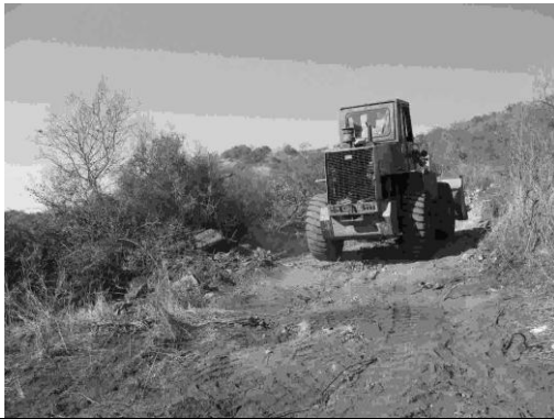
Fig. 3 – Construcción de acceso vehicular
