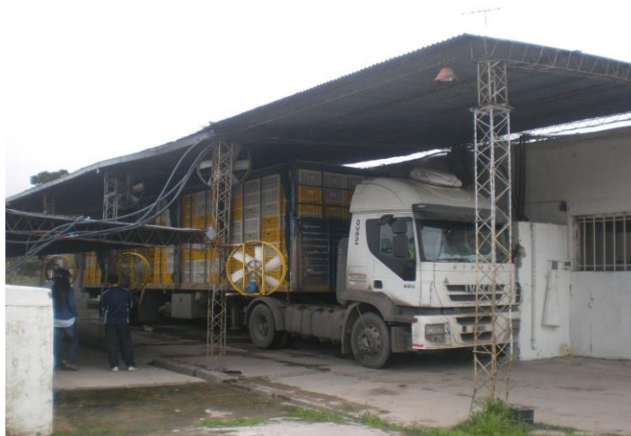
Figura 11: Playa de descarga con instalaciones requeridas (tinglado, ventiladores, luces)
