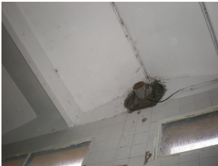
Figura 23: Extractor roto y ventilación deficiente
