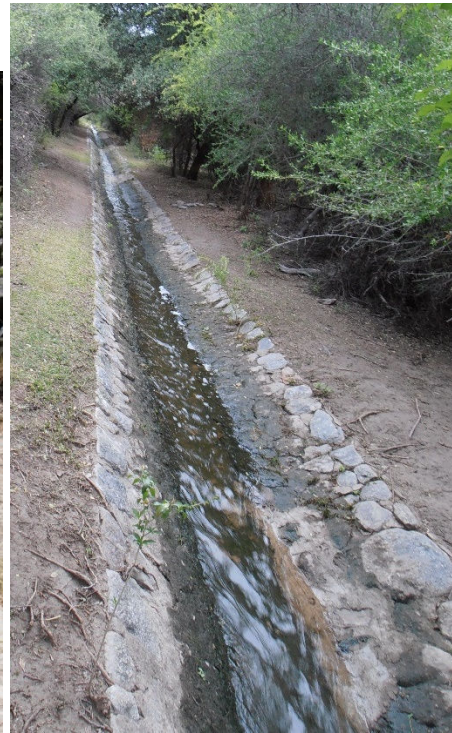
Izq. Fig. 3.2 Paredón y comienzo del canal transportador de agua en las Sierras de Pocho Der. Fig. 3.3 Tramo del canal de 9 km que va del paredón a las represas públicas y el sistema de red
