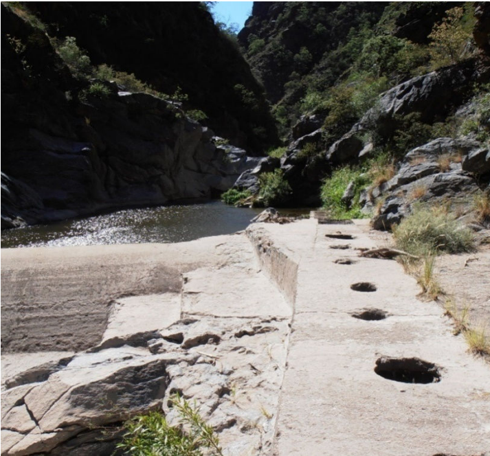
Izq. Fig. 3.2 Paredón y comienzo del canal transportador de agua en las Sierras de Pocho Der. Fig. 3.3 Tramo del canal de 9 km que va del paredón a las represas públicas y el sistema de red
