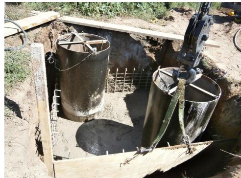
Fotografía N°4 Llenado con hormigón. Aquí podemos observar que se está procediendo a extraer los moldes que forman los orificios en
