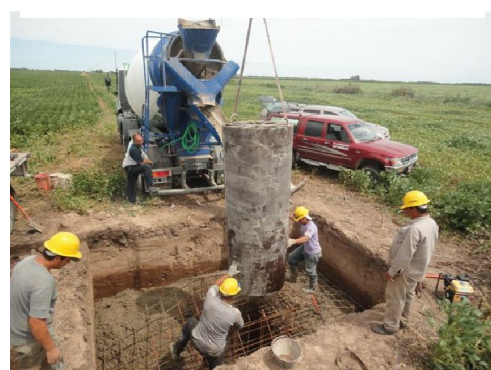
Fotografía N°10 Armadura de fuste y platea. Aquí vemos que no se colocan separadores entre suelo y armadura y en muchos lugares el hierro queda expuesto a la corrosión.
