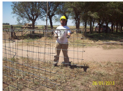
Fotografía N°8 Armadura para fuste. Esta armadura conformada por fierros verticales y horizontales se une mediante soldadora eléctrica.
