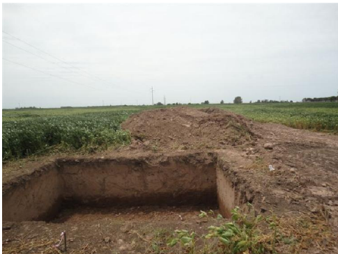
Fotografía N°7 Excavación, esta se realiza mediante retroexcavadora y se termina con pala manual.
