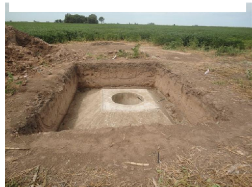
Fotografía N°14 Vertido de hormigón, dando forma mediante palas
