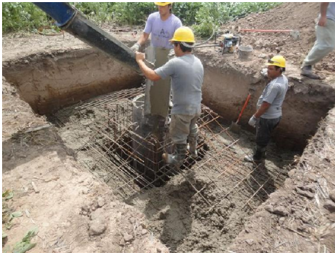
Fotografía N°13 Vertido de hormigón. Se procede a continuar con el vertido de hormigón.
