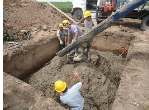
Fotografía N°14 Vertido de hormigón, dando forma mediante palas
