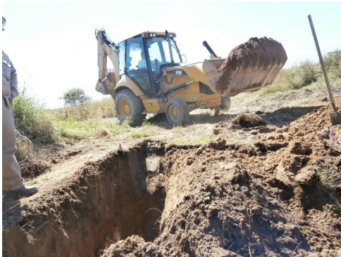
Fotografía N°1 Excavación con retroexcavadora para la fundación en cuestión.
