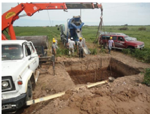
Fotografía N°9 Descenso de armadura de platea.
