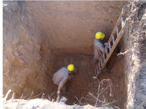
Fotografía N°2 Perfilado a pala para lograr la geometría dada en los planos de obra.
