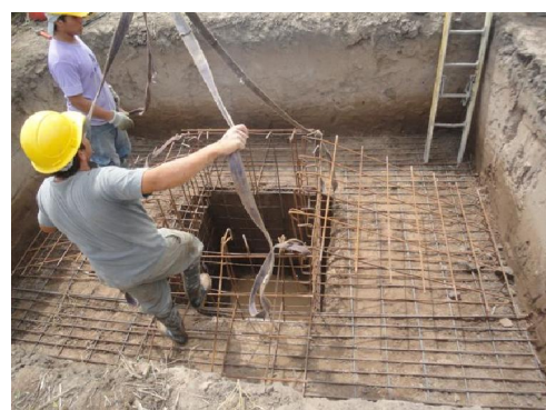
Fotografía N°10 Armadura de fuste y platea. Aquí vemos que no se colocan separadores entre suelo y armadura y en muchos lugares el hierro queda expuesto a la corrosión.
