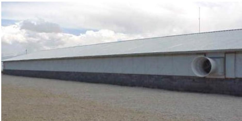
En el proyecto, el único mecanismo de ventilación que se utilizará será el de extractores y cortinas de PVC.
