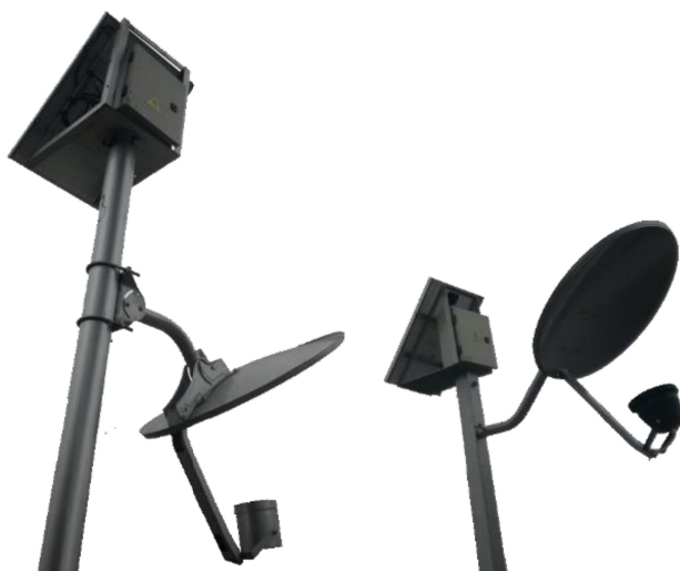
Figura 9: Fotografías de 2 opciones de unión entre fuste, plato, soporte triangular, panel y gabinete.
