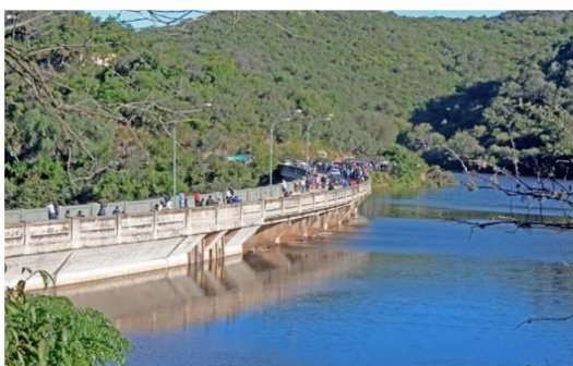
FOTOGRAFÍA N° 3 Dique La Quebrada. Sistema hídrico Cuenca Rio Ceballos. Fuente: IPLAM
