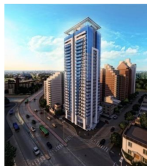
Fig. 6. Torre Betania. Grupo Edisur ubicado frente a la Terminal de ómnibus. Se le otorgó una edificabilidad de 18 mil metros cuadrados como parcela atípica.
