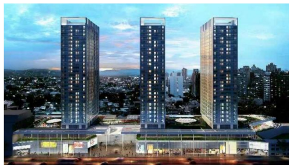
Fig. 4. La ex villa El Pocito, tiene una normativa de excepción para la construcción de un mega emprendimiento de tres torres de 100 metros de altura.
