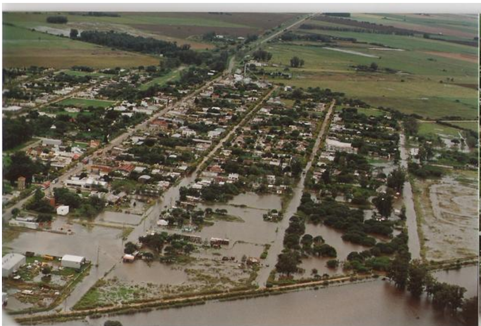
Figura 2.4.3 Sector Sur-Este Localidad de S.M laspiur, fuente: Municipalidad de S.M. Laspiur (abril de 2007)
