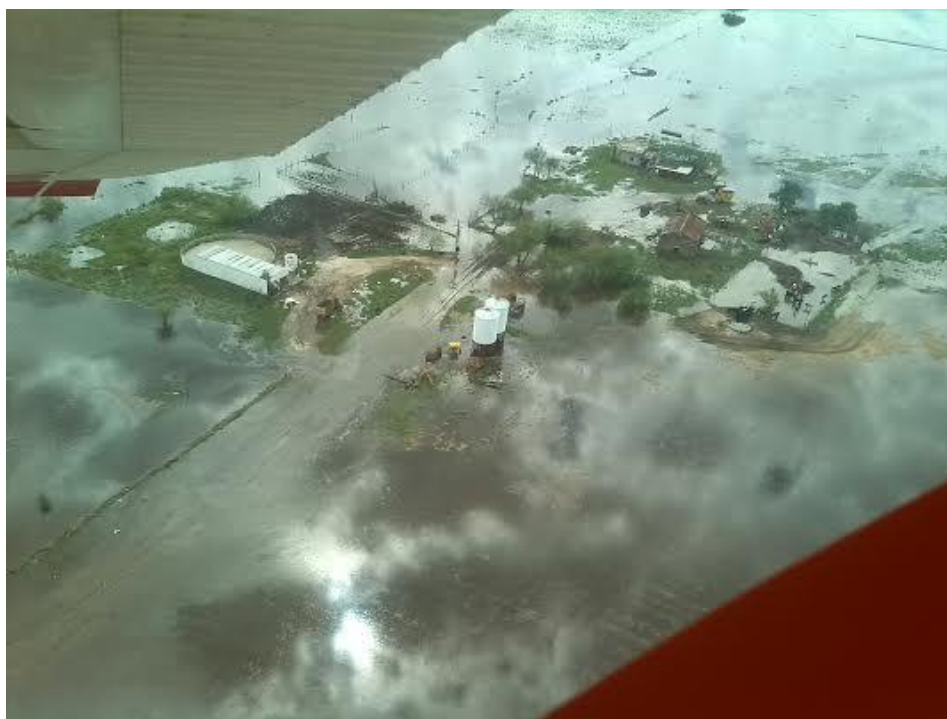
Figura 2.4.7 Anegamiento del sector rural, fuente: Municipalidad de S.M. Laspiur (marzo de 2009)
