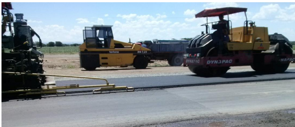
Figura 57: Ejecución de Capa Asfáltica de espesor variable según Deformaciones
