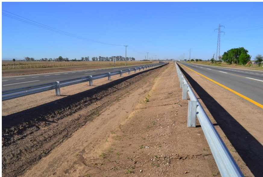
Figura 3: Mediana con cuneta central
