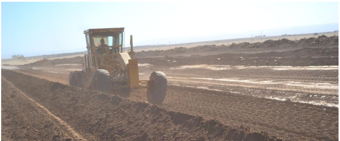
Figura 29: Compactador Pata de Cabra y Motoniveladora trabajando
