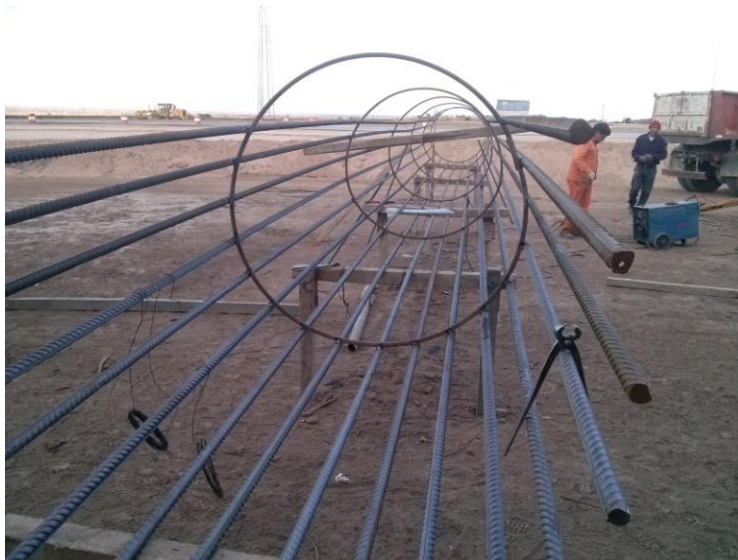
Figura 78: Banco de Armado de Hierros
