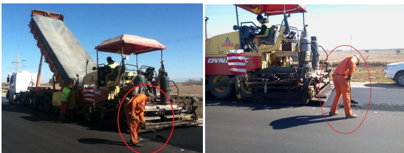
Figura 54: Toma de Juntas
