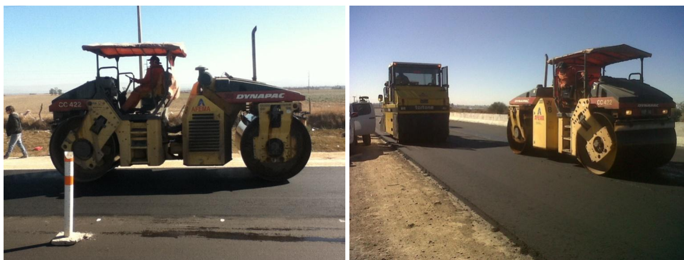
Figura 52: Compactadores tipo Rodillo Liso con vibrador (Aplanadora)
