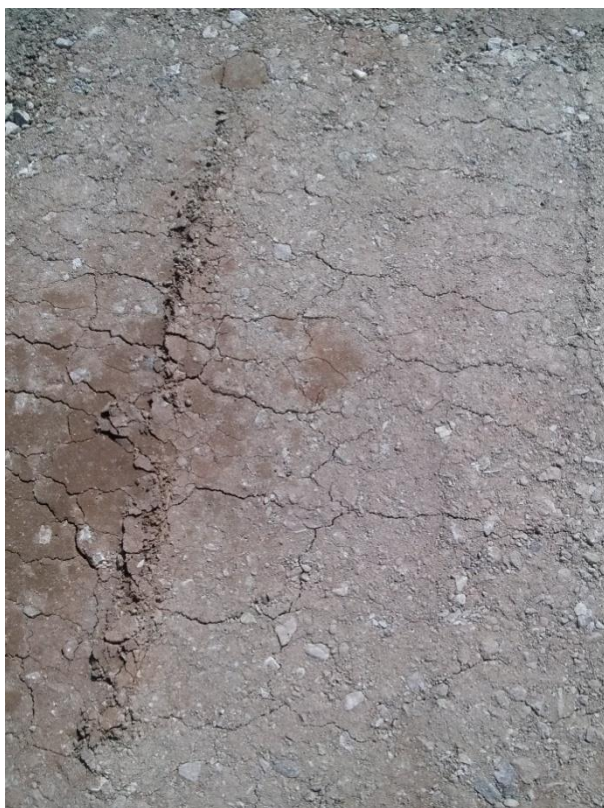
Figura 35: Bache Sobre base Granular
