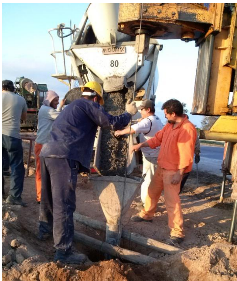
Figura 81: Llenado de Pilote
