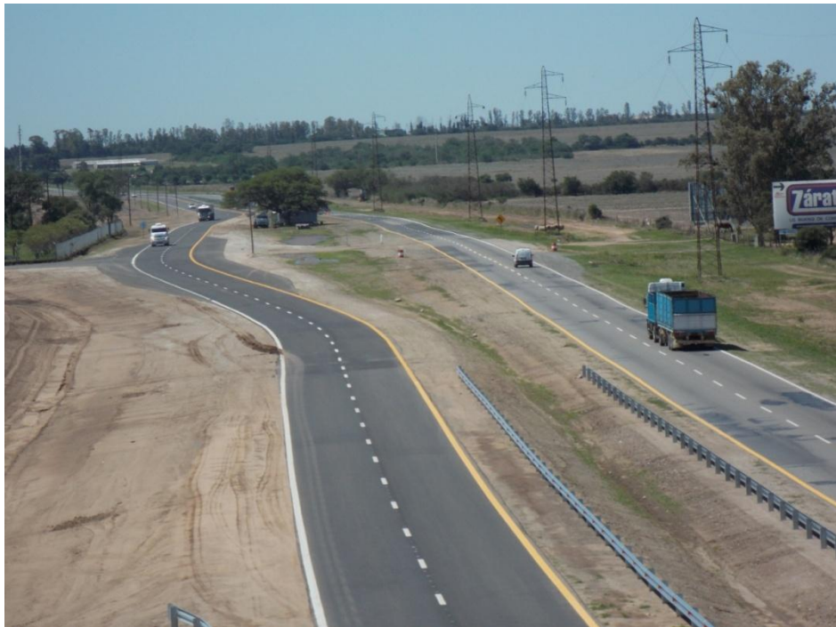
Figura 2: Imagen panorámica de Obra Terminada
