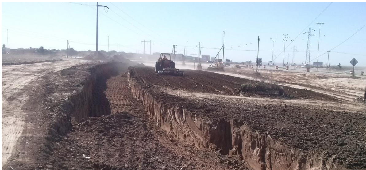
Figura 33: Cuneta ejecutada
