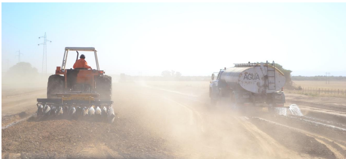
Figura 28: Rastra y Camión de Agua Trabajando
