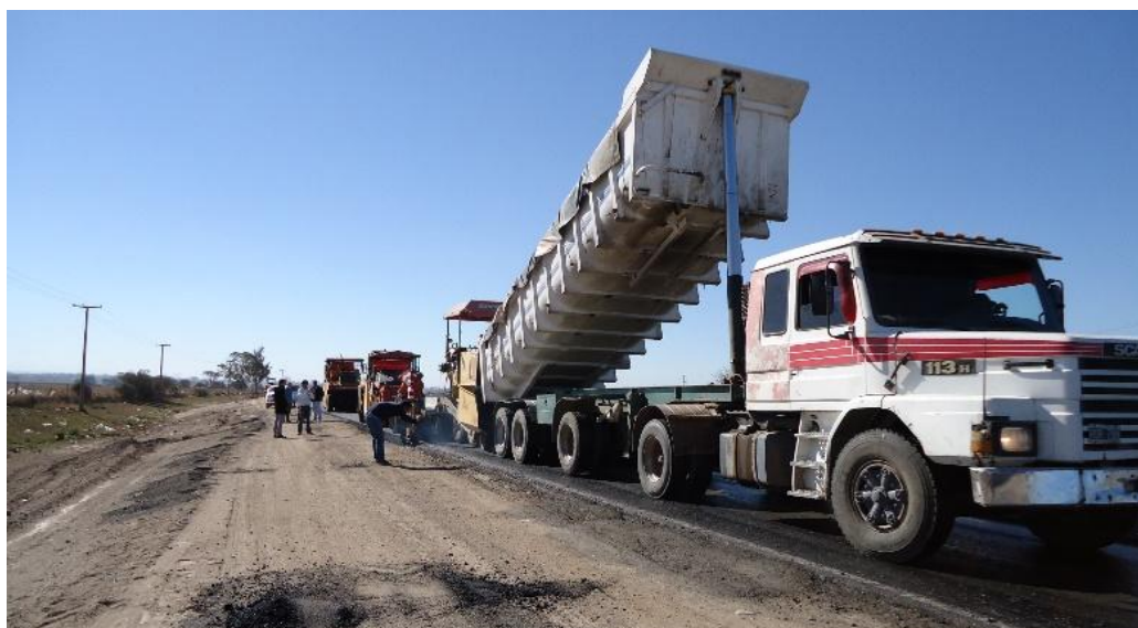
Figura 51: Línea de Distribución de Mezcla Asfáltica con Terminadora
