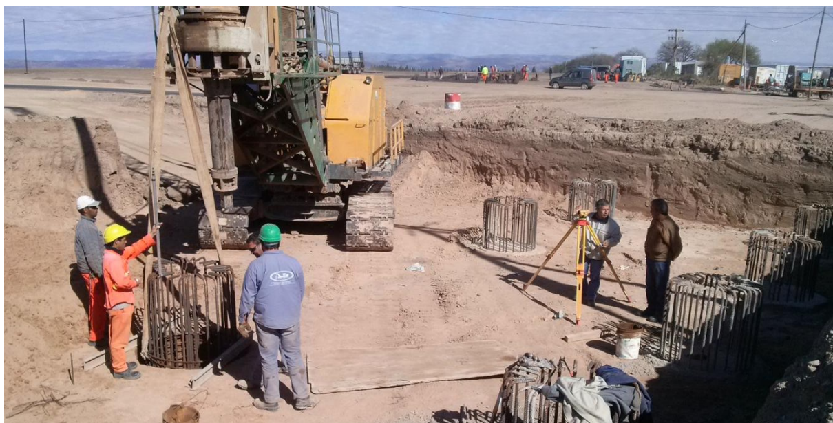
Figura 80: Nivelación de Armaduras
