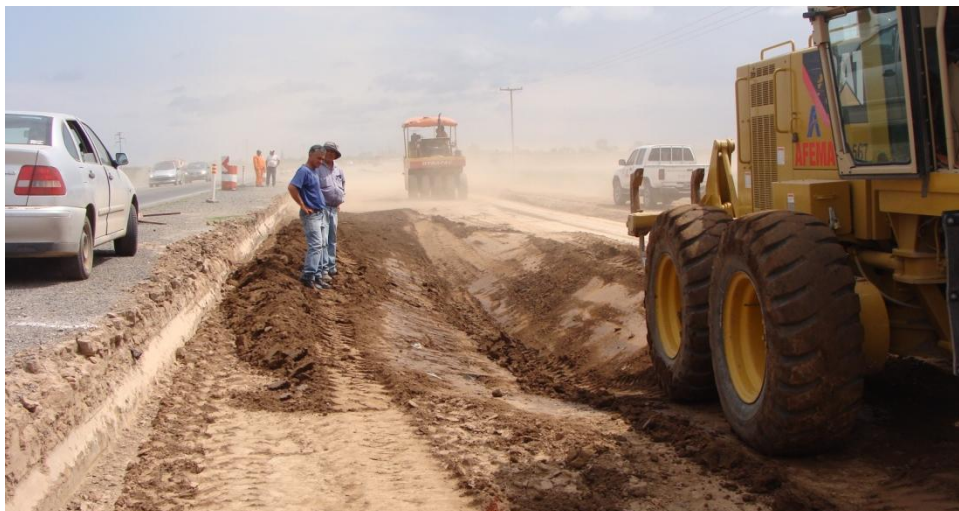
Figura 37: Saneamiento de Bache
