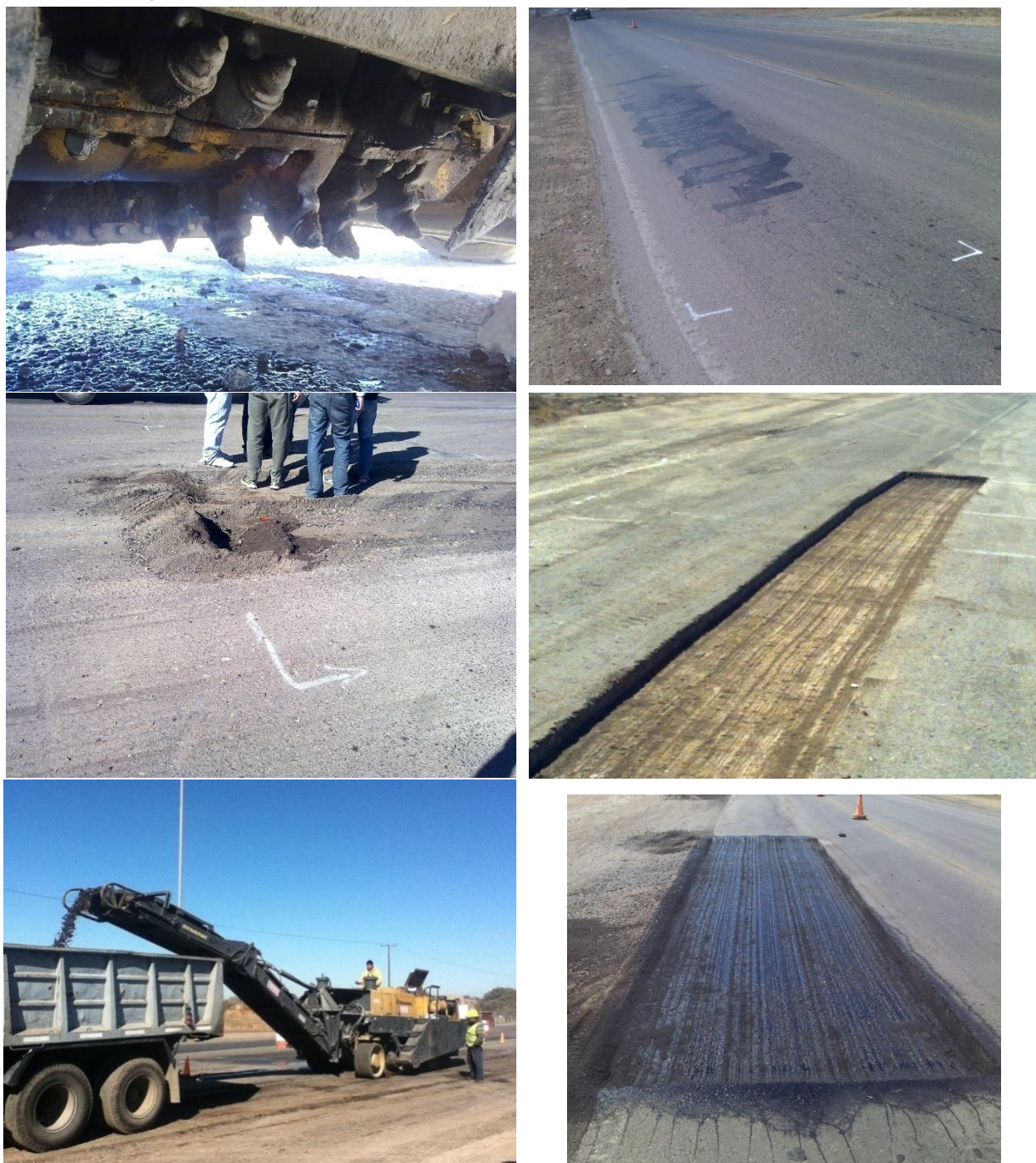
Figura 58: Ejecución de Bacheo con Fresadora
