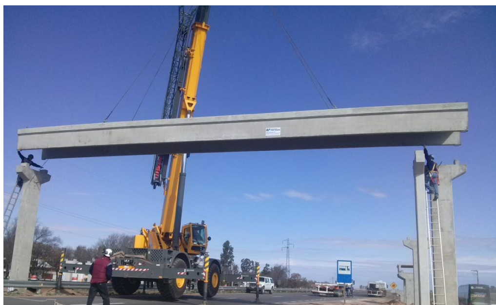
Figura 84: Montaje de vigas
