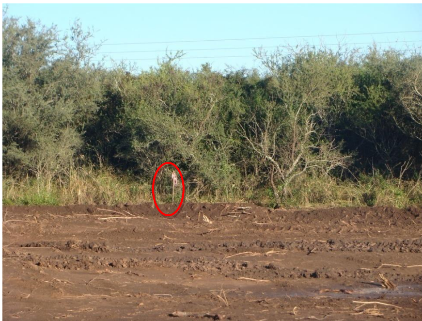
Figura 22: Replanteo para Limpieza
