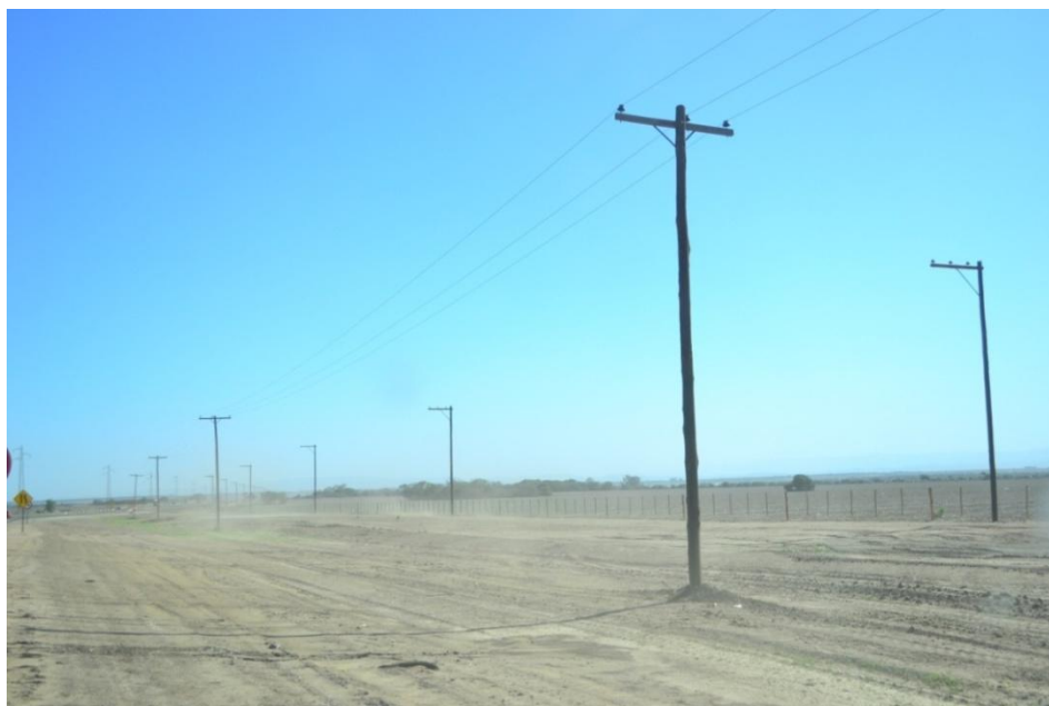
Figura 6: Corrimiento de línea eléctrica de media tensión
