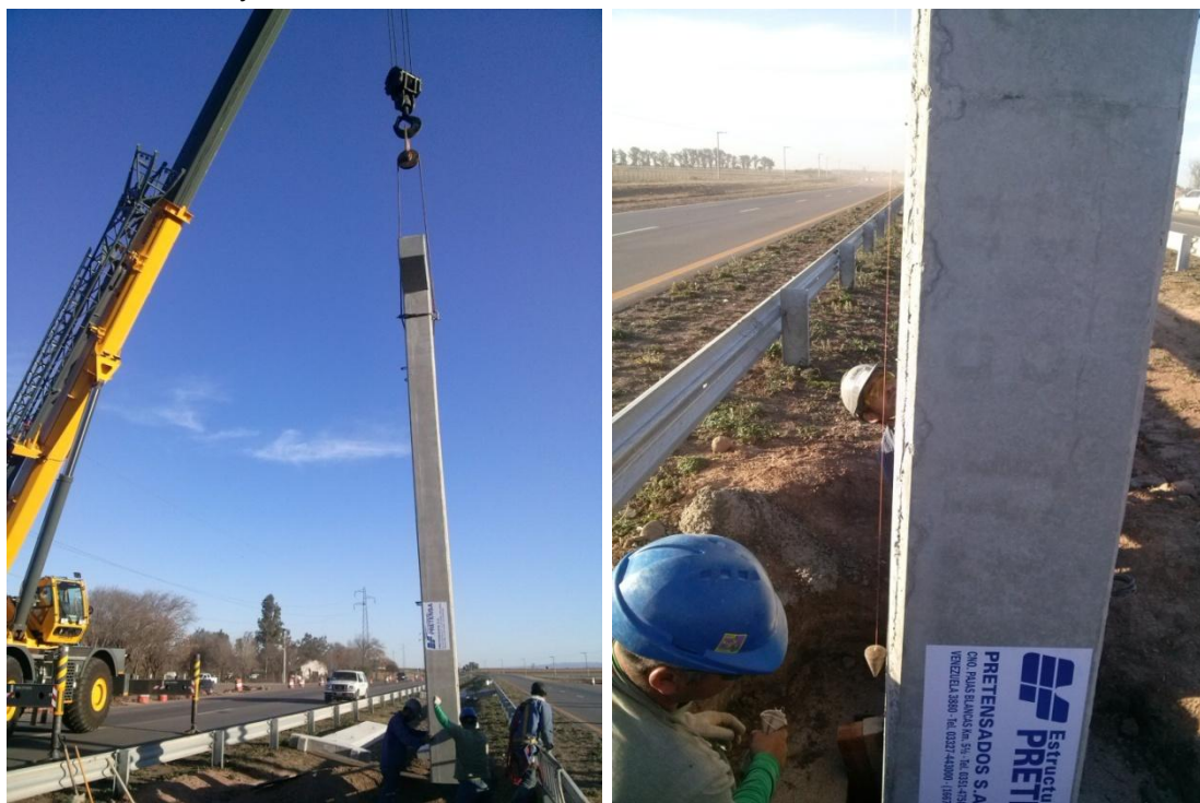
Figura 83: Montaje de Columnas
