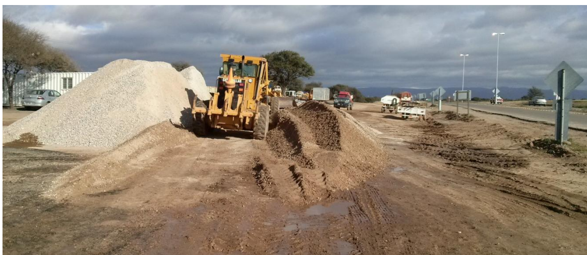
Figura 39: Acopio Humectado
