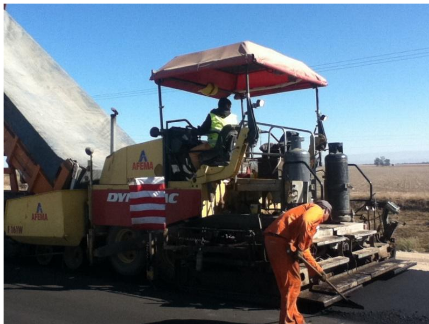
Figura 50: Terminadora Trabajando
