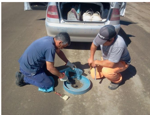
Figura 44: Ensayo de Cono de Arena en Base
