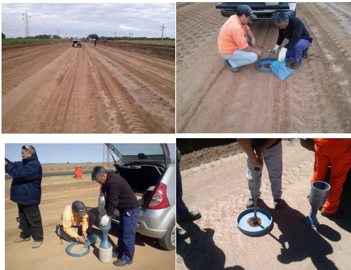
Figura 34: Inspección Terraplén - Ensayo del Cono de Arena
