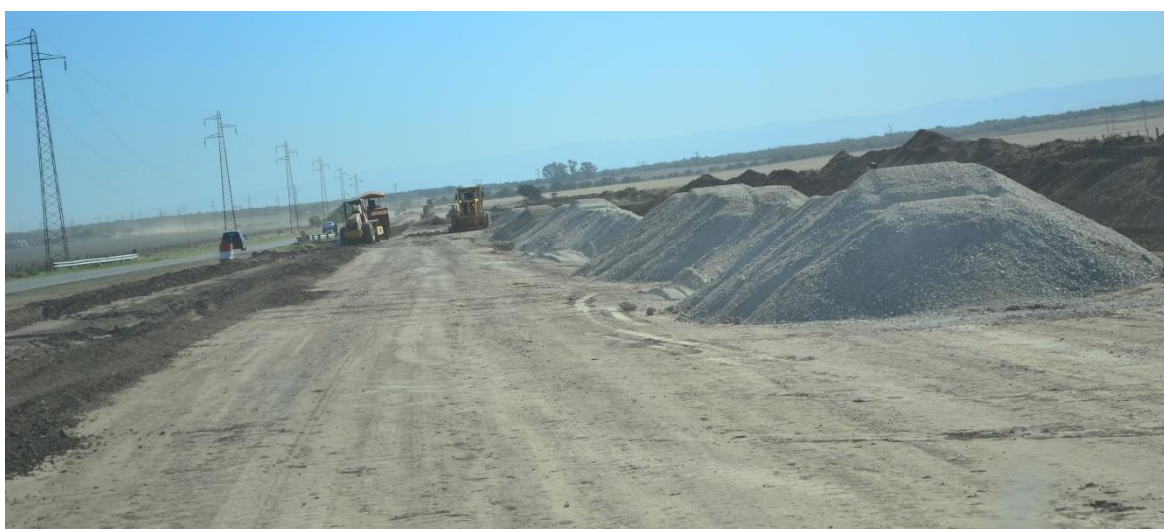
Figura 40: Material de base descargado en el lugar de ejecución
