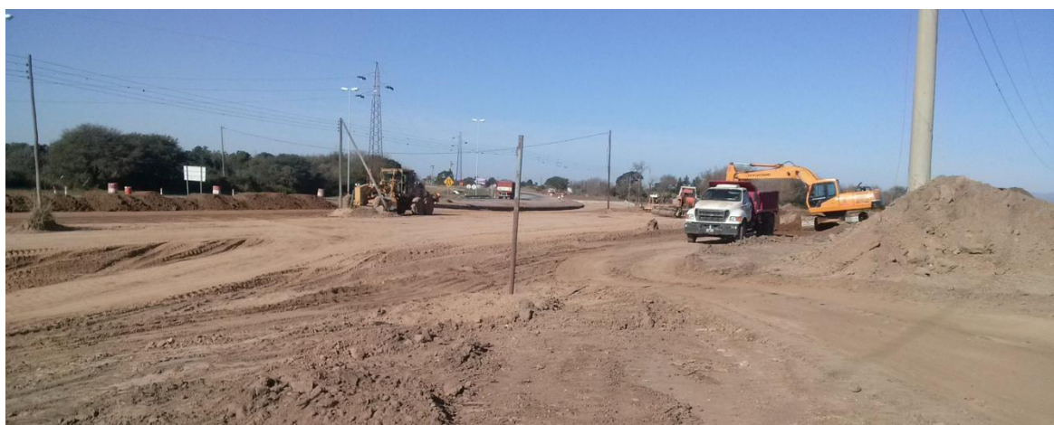
Figura 31: Carga y Descarga de suelo para terraplén
