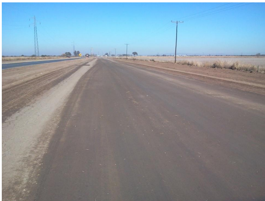
Figura 43: Base Granular Terminada y Perfilada
