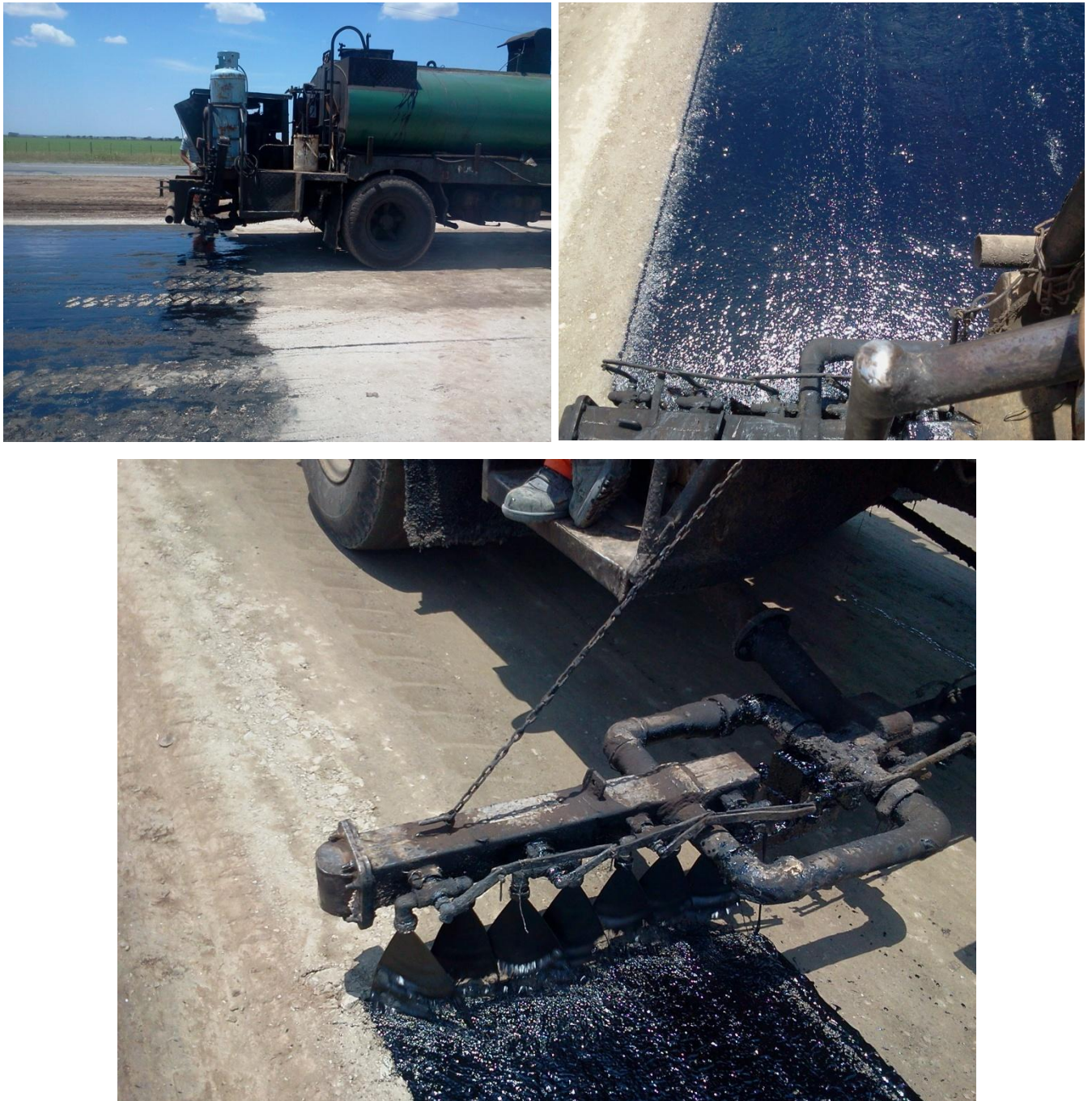
Figura 49: Ejecución de Riego de Imprimación
