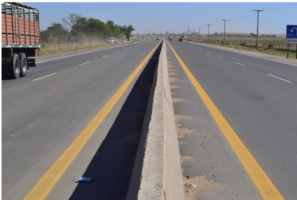
Figura 8: Perfil Tipo N°1 Terminado - Autovía con New Jersey
