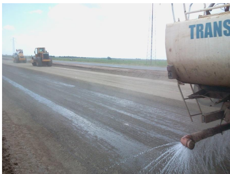
Figura 41: Camion regador y compactadores trabajando
