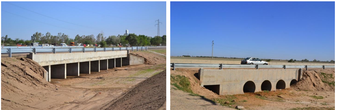
Figura 5: Alcantarillas Terminadas
