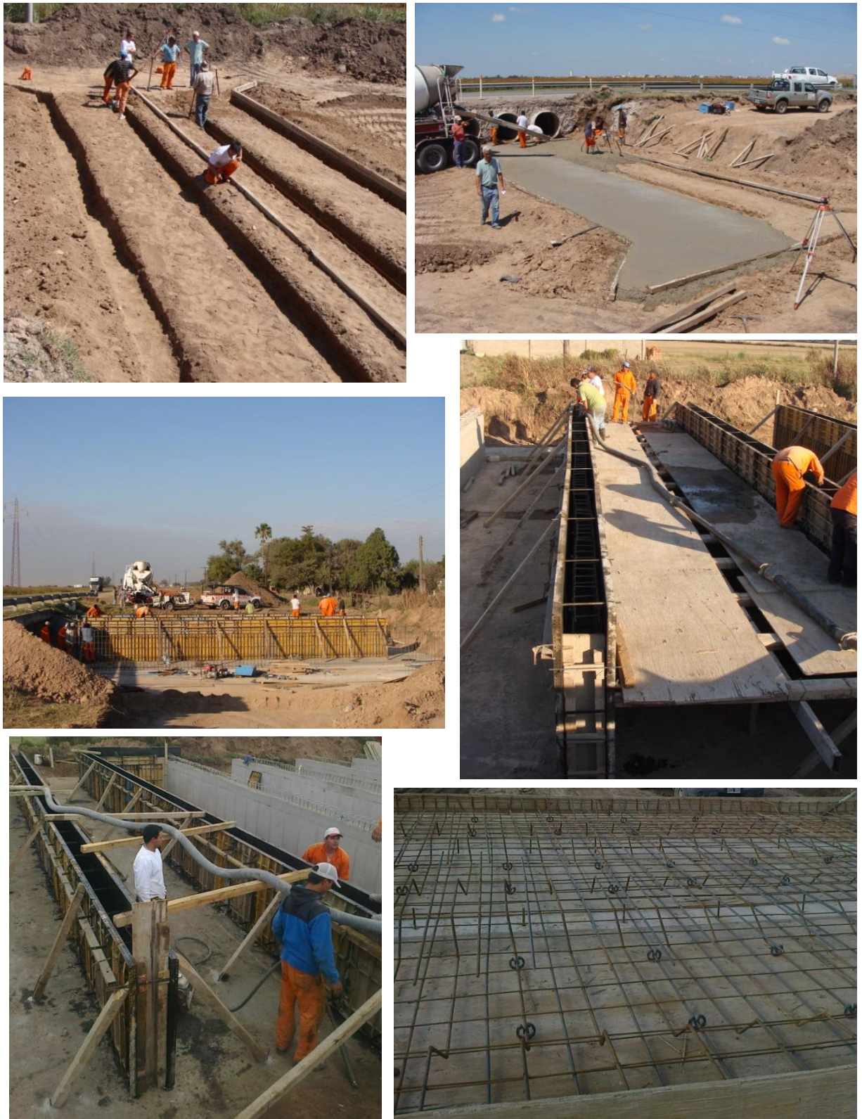
Figura 64: Secuencia y Método constructivo de Alcantarillas
