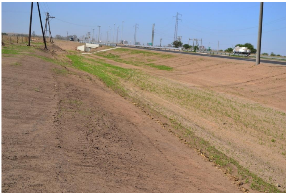
Figura 13: Cuneta de Desagüe
