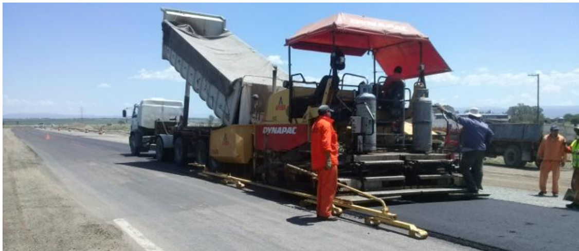
Figura 56: Ejecución de Restitución con Trineo
