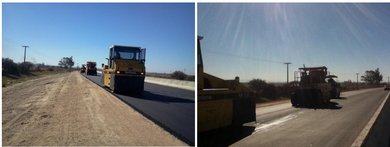
Figura 53: Compactadores tipo Rodillo Neumático trabajando
