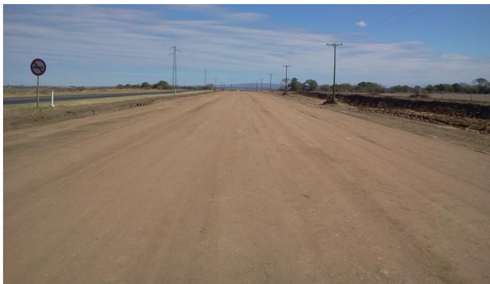
Figura 27: Capa de Terraplén Terminada
