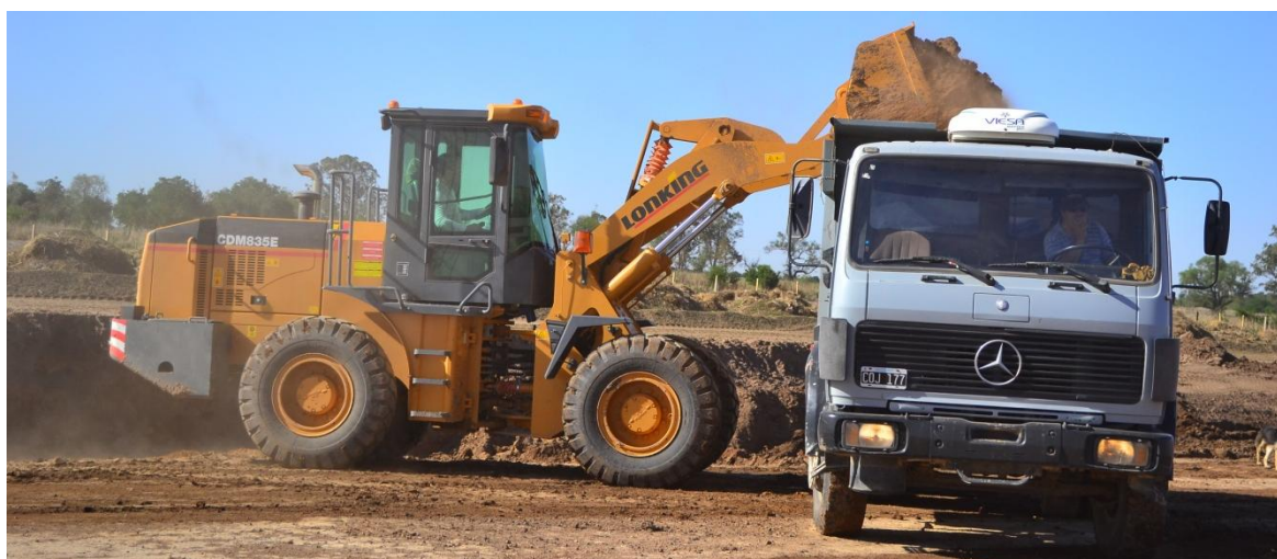
Figura 32: Pala Cargadora cargando suelo
