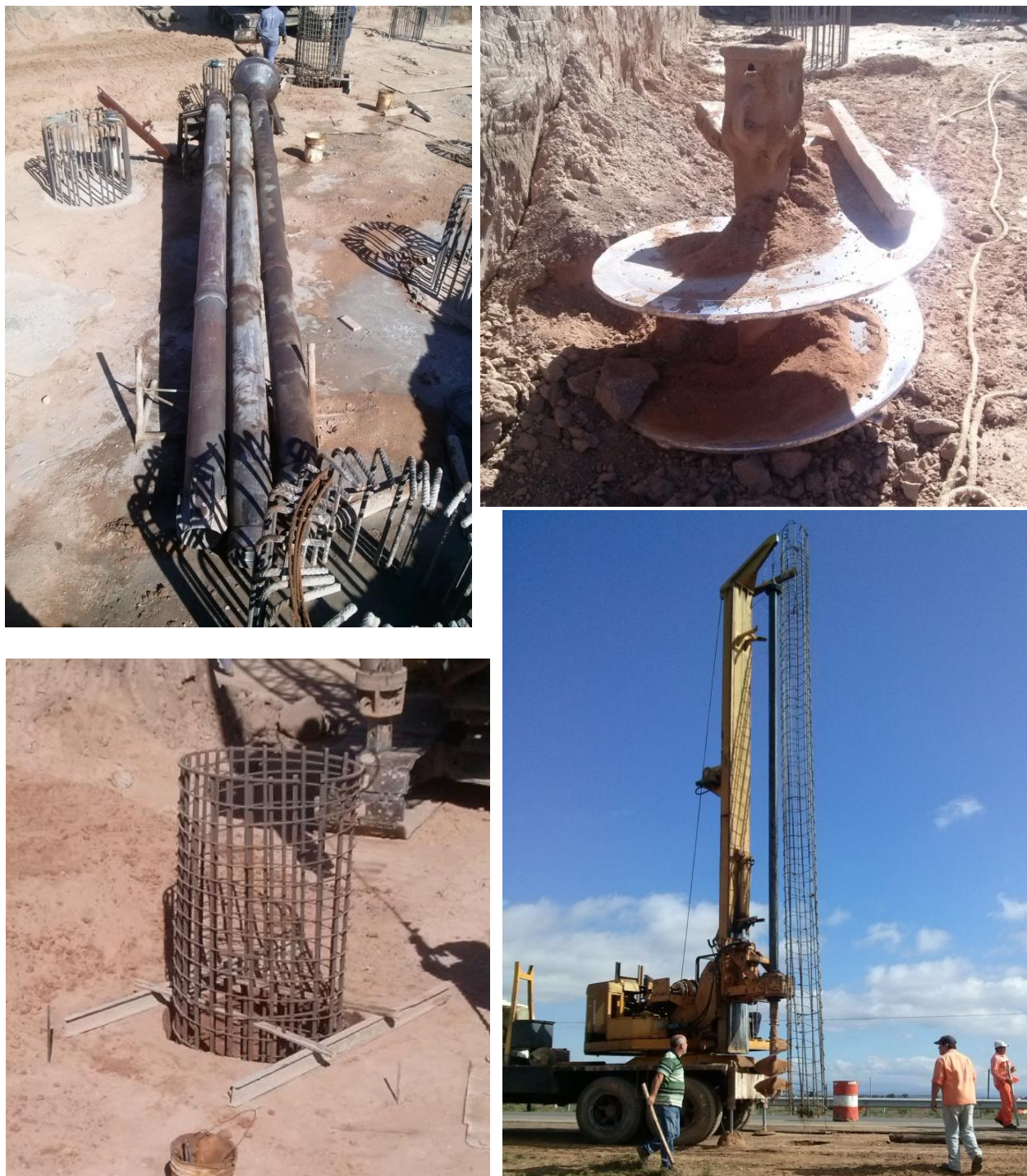
Figura 79: Equipamiento para Ejecución de Pilotes
