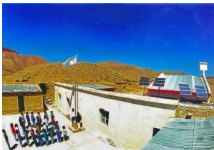
Figura 8: Escuela rural en la Provincia de Jujuy abastecida de electricidad por medio de paneles fotovoltaicos adquiridos por medio del Proyecto PERMER [15].
