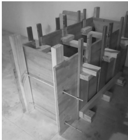
FIGURA 5 Fotografía del encofrado realizado para ejecución de muro tapial.
