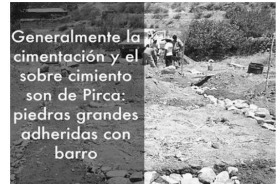
FIGURA 2 Fotografía del cimiento de un muro tapial durante su proceso de ejecución. (Downton, 2013)
