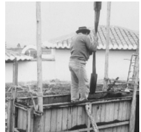
FIGURA 3 Fotografía durante el proceso de ejecución del muro tapial.
