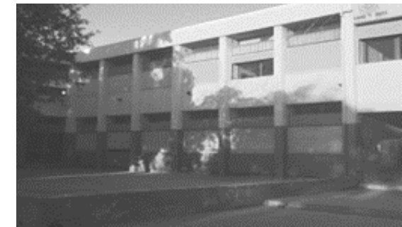
Figura 3. Edificio ISEAM 36 – Escuela Domingo Zipoli y ubicación del caso de estudio
