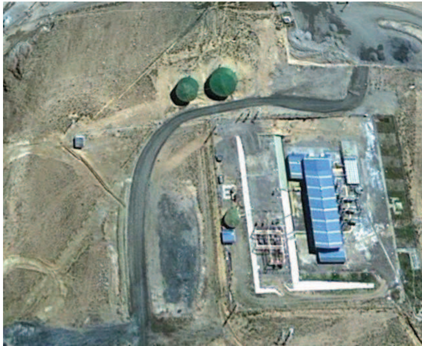
Tanques Industriales y Usina
