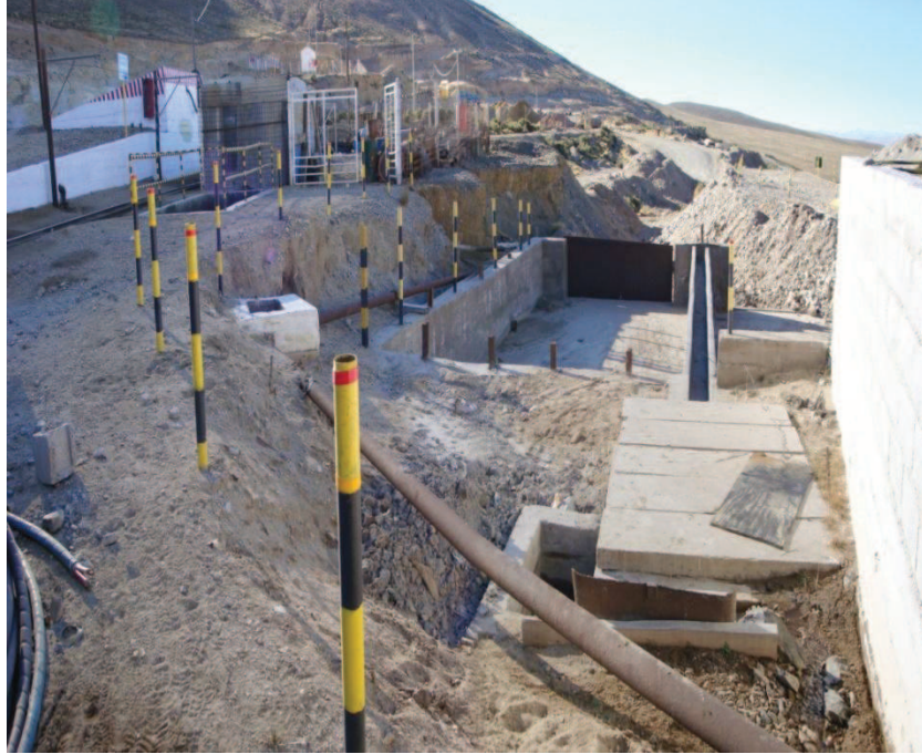
Zona De Emplazamiento Del Sedimentador
