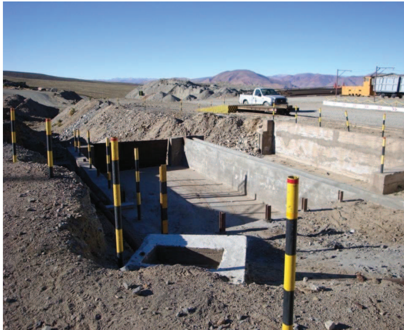
Zona De Emplazamiento Del Sedimentador
