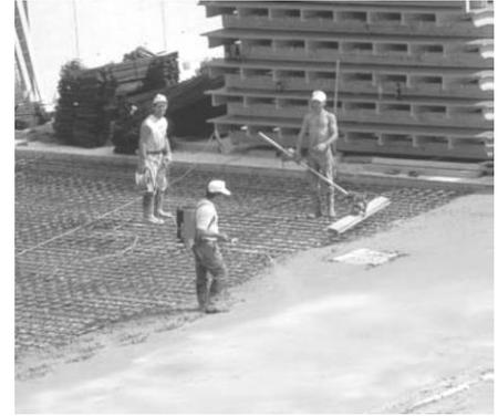
Fig. 7-8. Bombeado del Hormigón Elaborado
