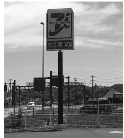
Figura 1.27: esquema de funcionamiento de columnas empotradas- Ejemplos : cubierta cochera-poste Mono columna cartel
