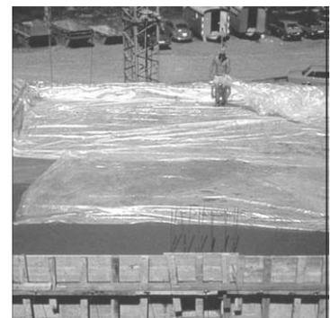
Fig. 7-7. Curado del Hormigón
