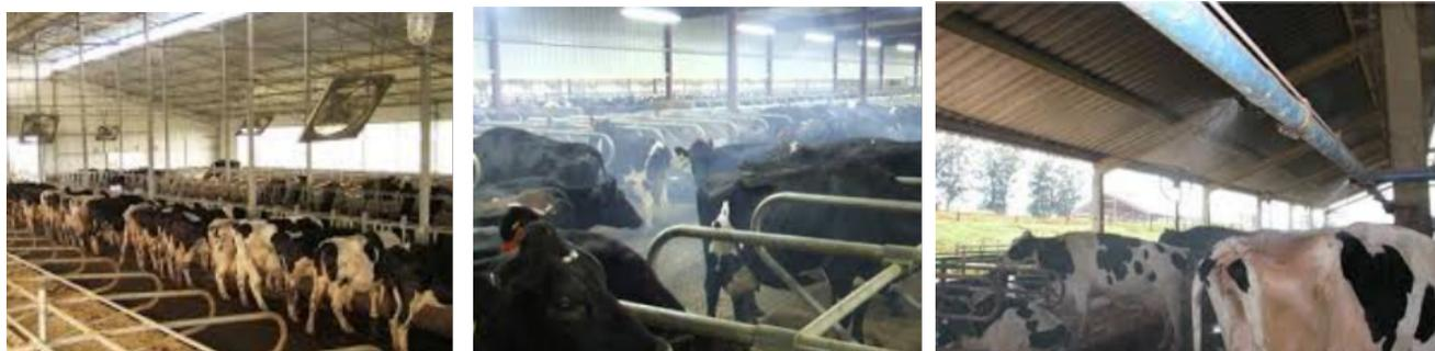
Figuras: Sistemas de refrigeración: Ventilación (izquierda), Nebulización (centro) y Aspersión (derecha).
