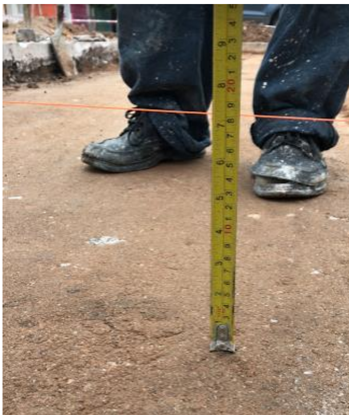
Figura 20. Control de espesores.
