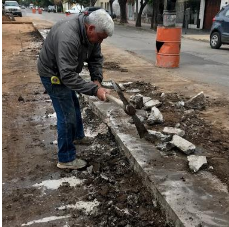
Figura 16. Terminación manual sobre los bordes del hormigón para dejarlos rectos y normales a la base.
