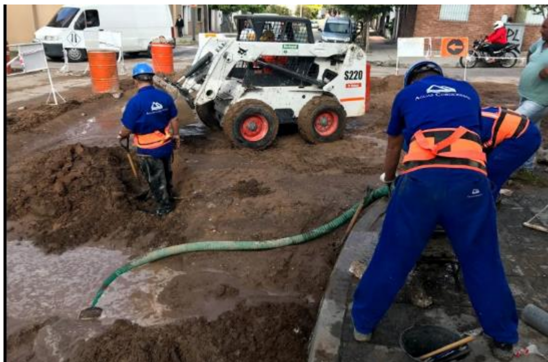
Figura 27. Aguas Cordobesas desagotando el bache para poder anular la conexión.
