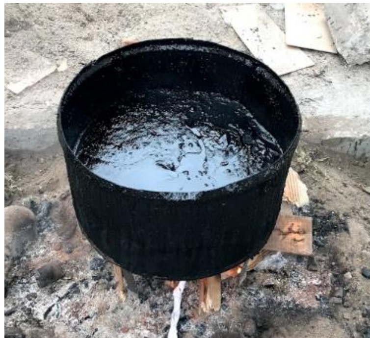
Figura 39. Calentamiento de pan asfáltico.
