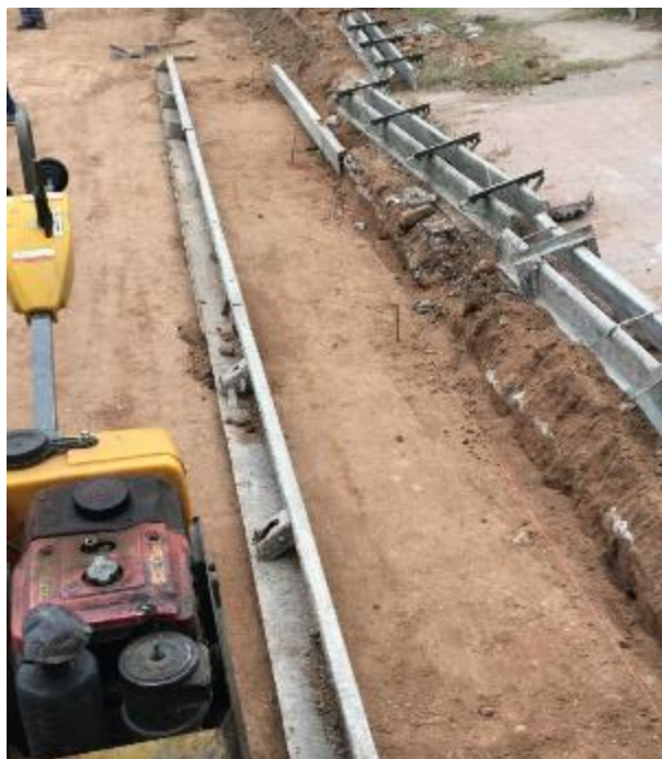
Figura 18. Nivelación de cuneta
