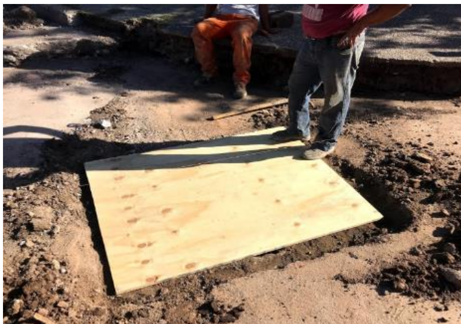
Figura 23. Encofrado perdido para que el hormigón no ingrese a las cloacas.
