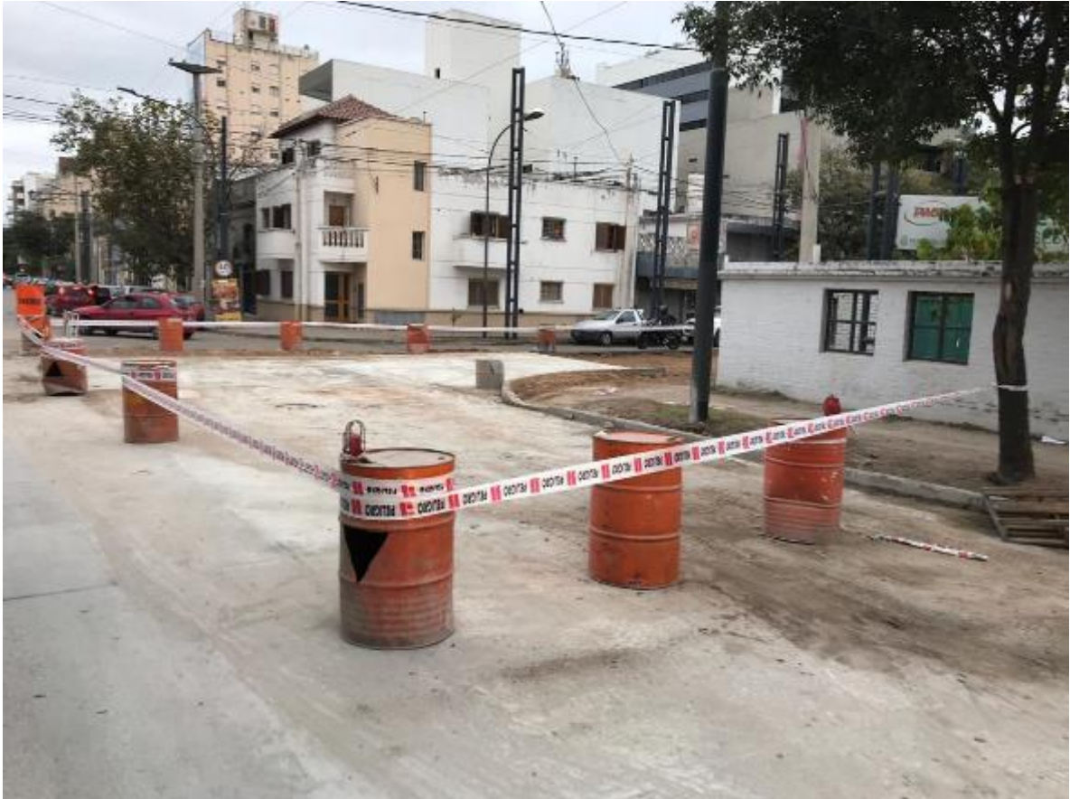
Figura 11. Vallado para impedir el acceso al área de trabajo de vehículos o personas ajenas a las involucradas en la obra
