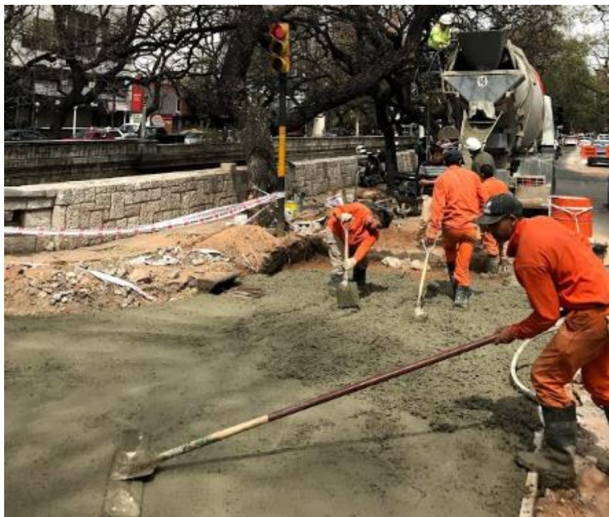
Figura 35. Terminación superficial con palón.
