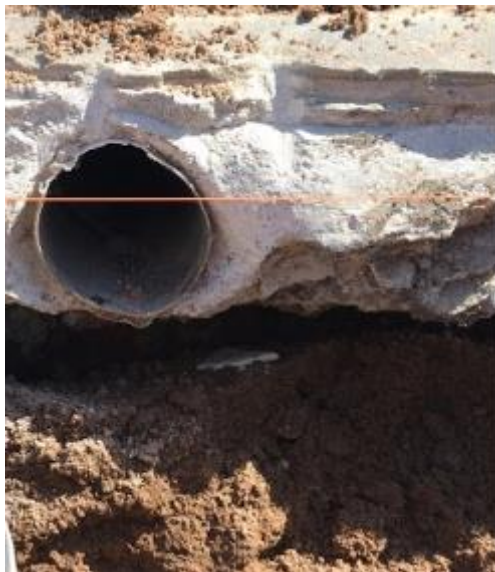
Figura 44. Tanza indica el nivel del hormigón terminado que obstruirá la salida del agua
