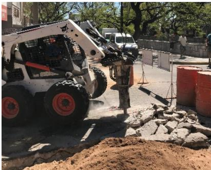
Figura 13. Minicargadora 650 con martillo hidráulico.
