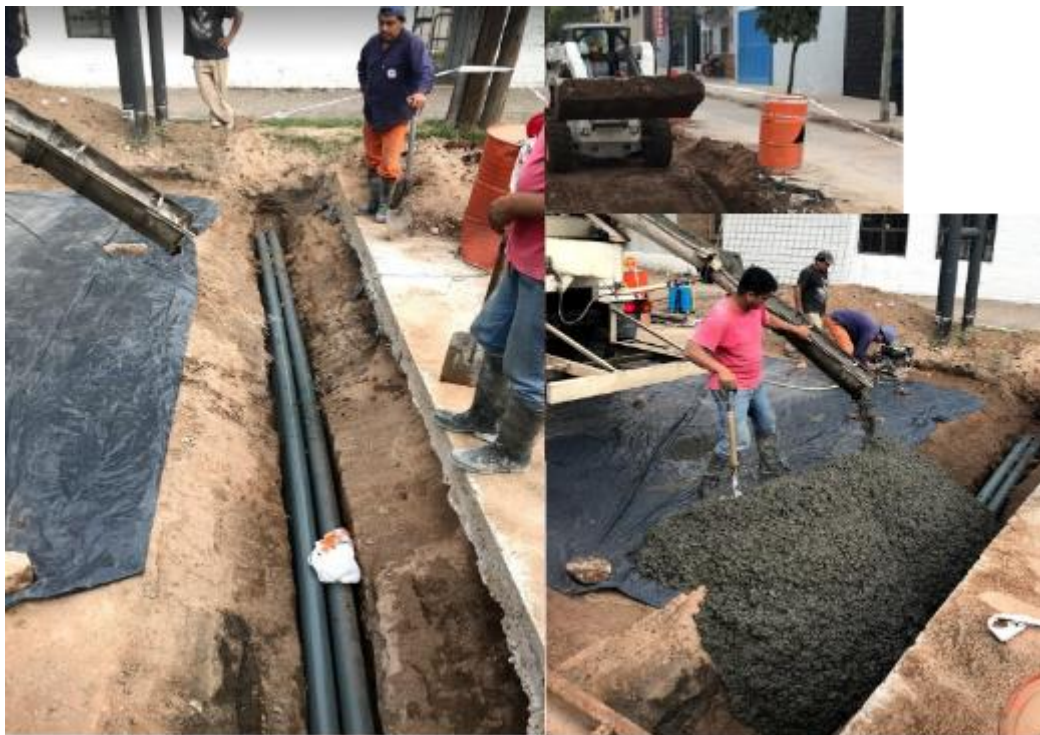
Figura 50. Ejecución del nuevo cableado de Trolebuses
