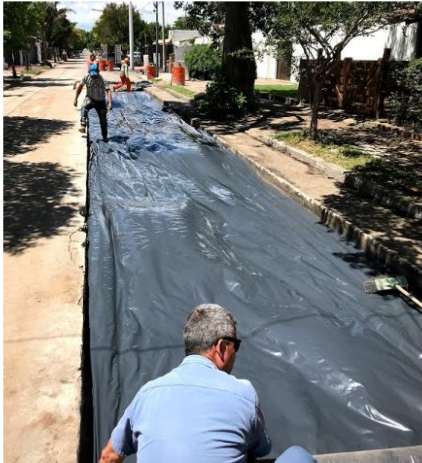
Figura 32. Colocación de Agropol
