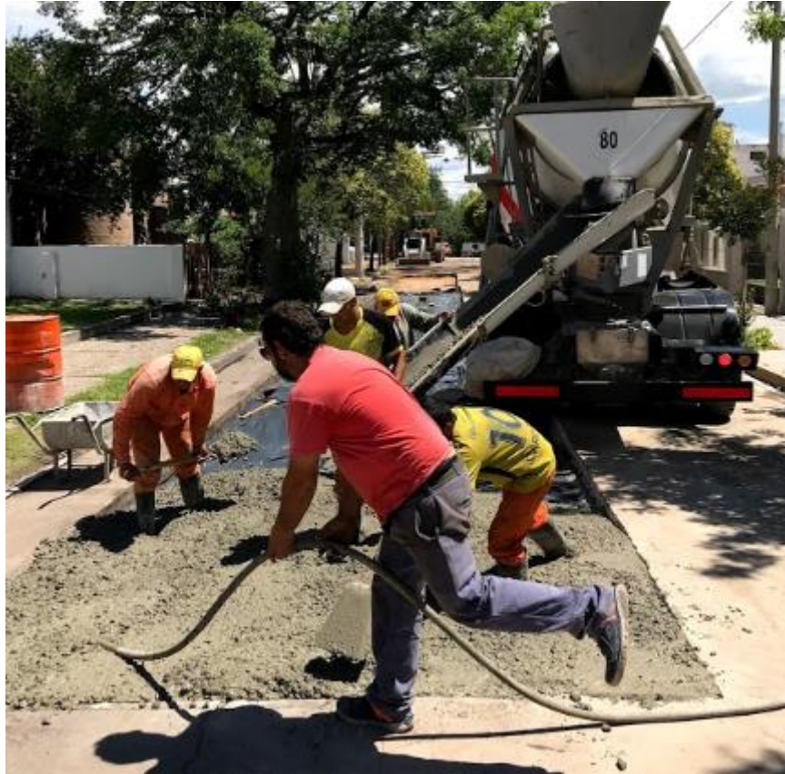
Figura 34. . Vibrado del hormigón
