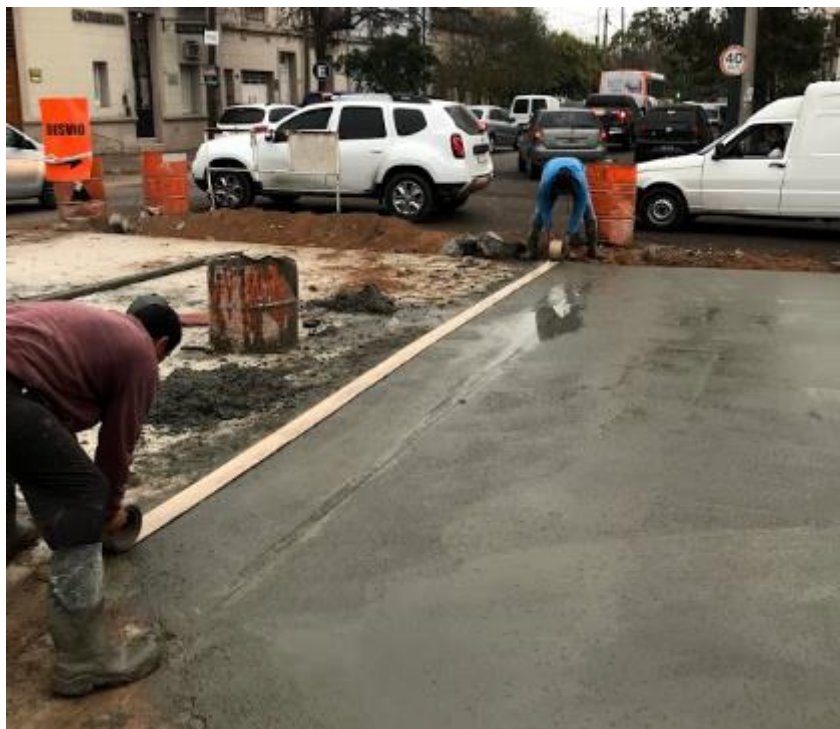
Figura 36. Terminación superficial con cinta.
