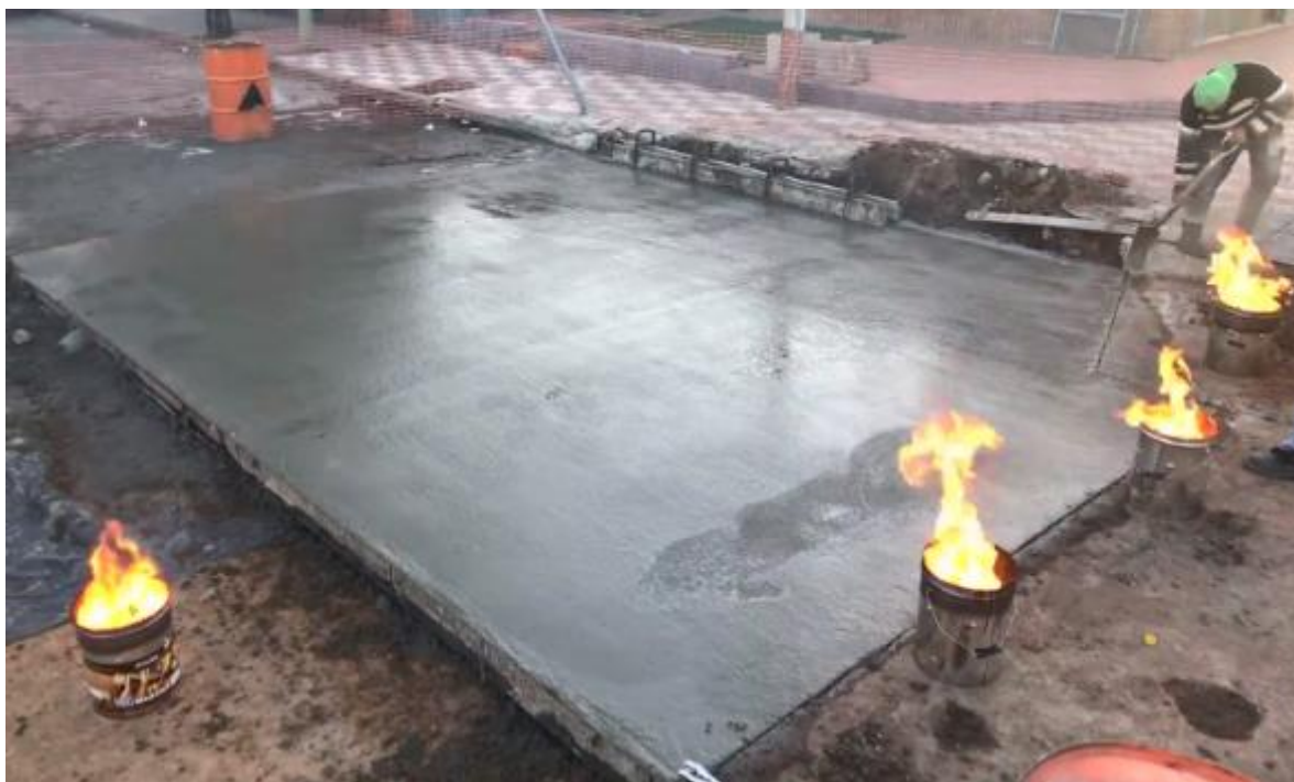
Figura 37. Hormigonado en tiempo frío.
