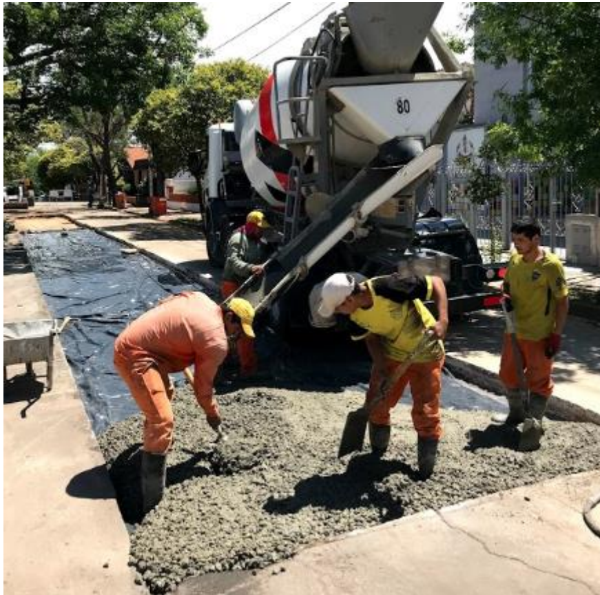
Figura 33. Distribución del hormigón con palas anchas.
