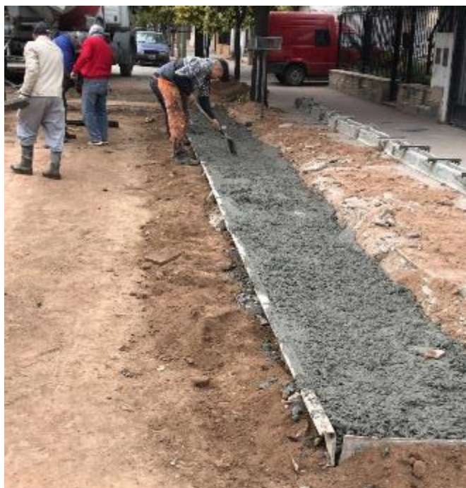
Figura 19. Ejecución de cuneta independiente a la calzada
