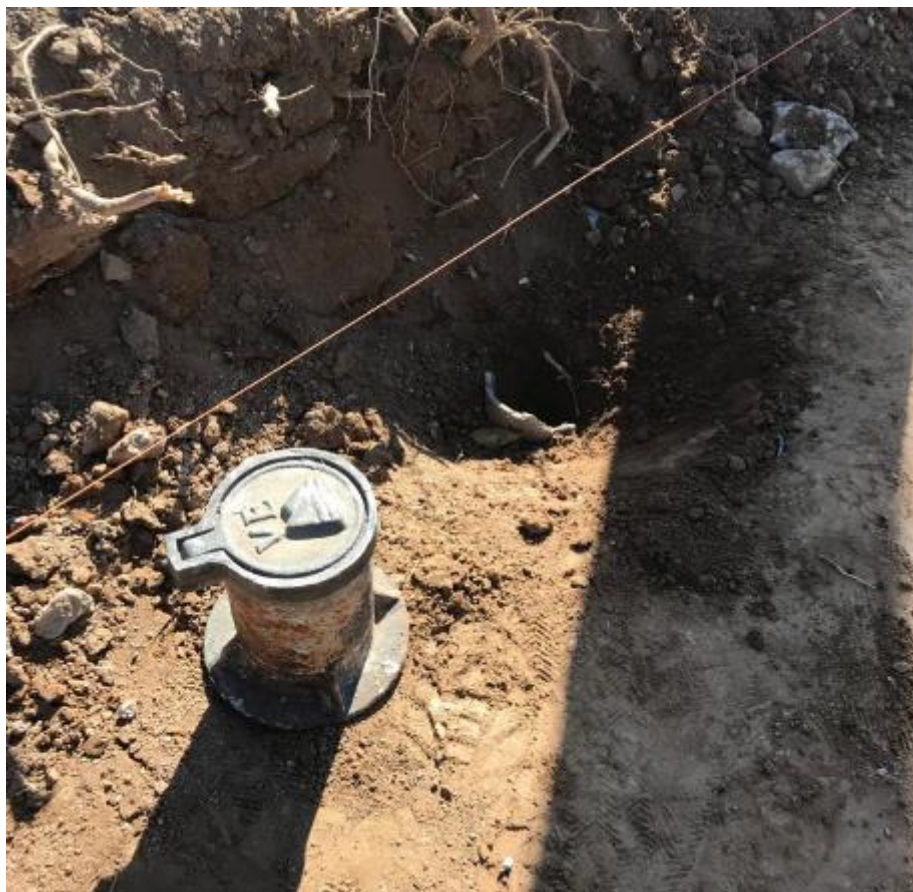
Figura 17. Brasero válvula exclusiva que debe dejarse a nivel.
