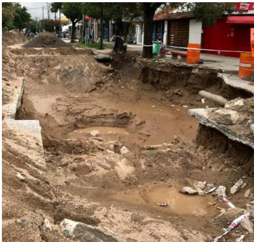
Figura 29. Excavación profunda con material contaminado.
