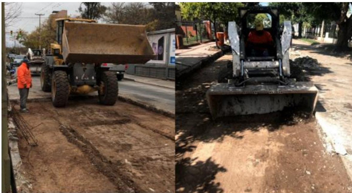
Figura 21. Cortando subrasante con pala cargadora y Minicargadora para llegar a los 18 cm de espesor
