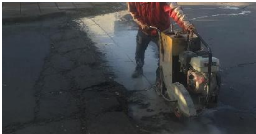
Figura 12. Aserrado con disco de corte
