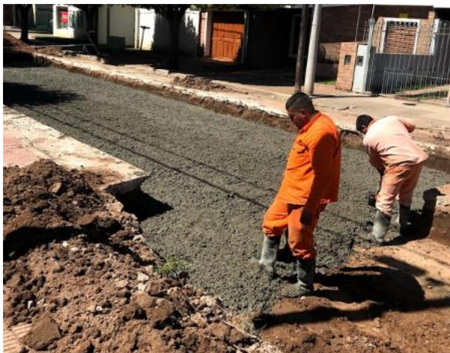
Figura 30. Ejecución de hormigón pobre.
