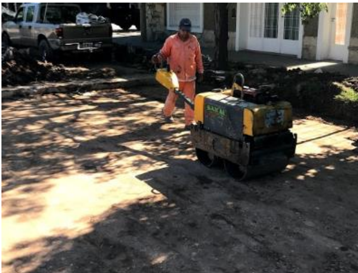
Figura 28. Compactando la subrasante con rodillo liso vibrador
