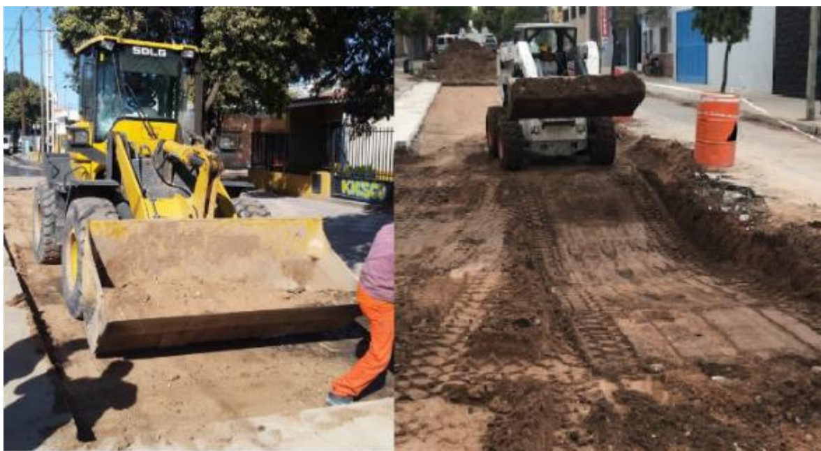
Figura 24. Pala cargadora y Minicargadora realizando excavación profunda
