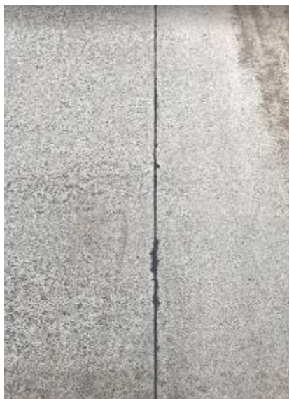
Figura 42.. Correcto tomado de juntas
