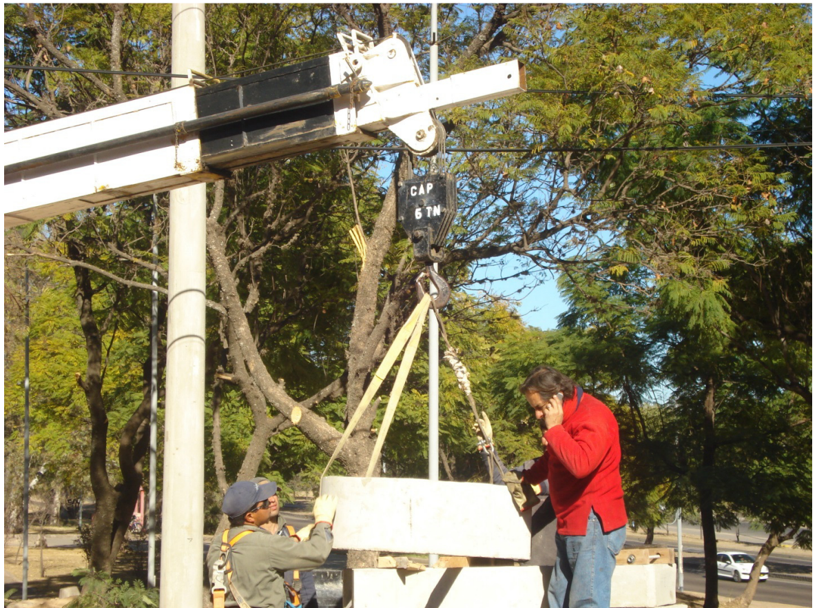
ARMADO DE ESTRUCTURAS – IZADO DE ACCERIOS
