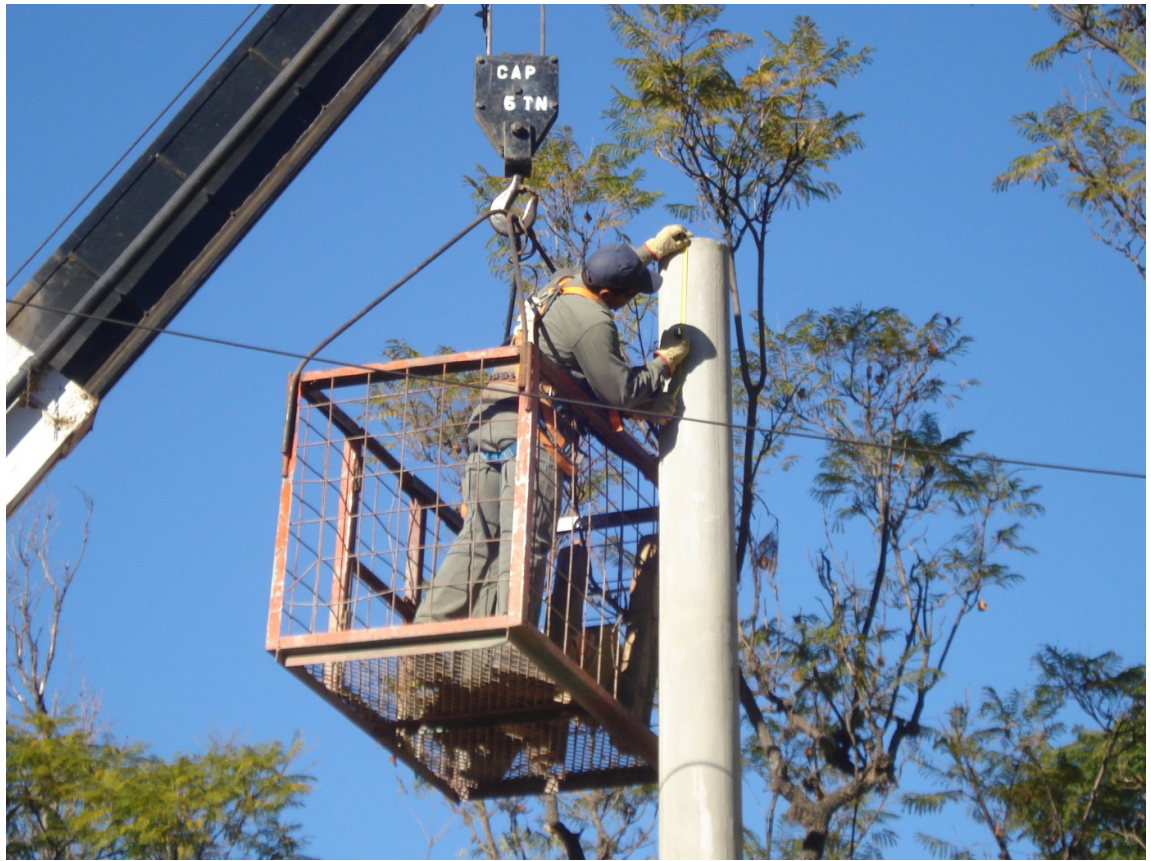
ARMADO DE ESTRUCTURAS
