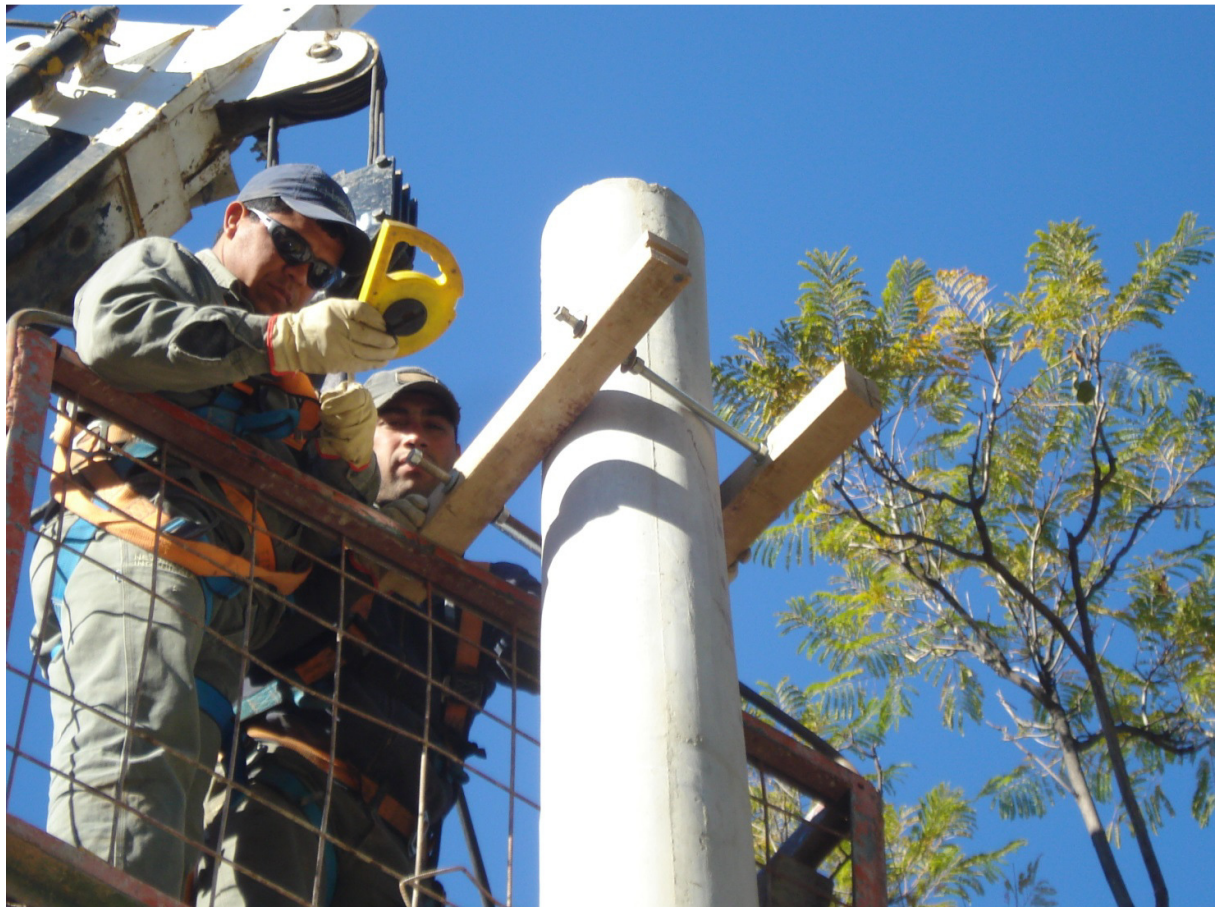
ARMADO DE ESTRUCTURAS – FIJACIÓN DE CEPOS PARA ACCESORIOS
