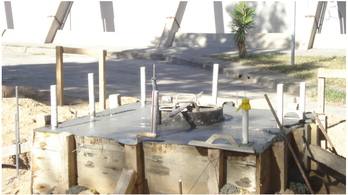
EJECUCIÓN DE BASES DE EQUIPOS
