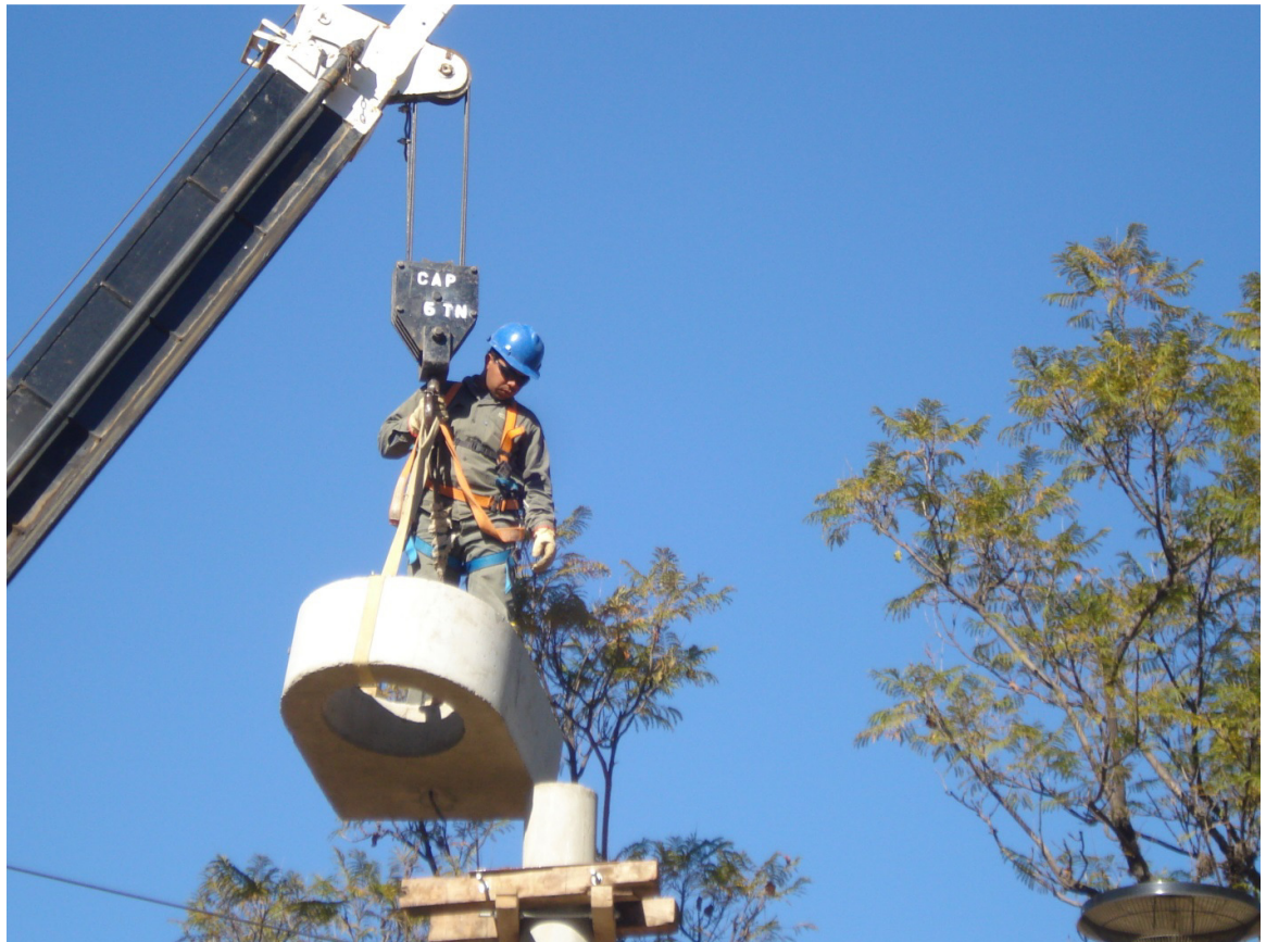
ARMADO DE ESTRUCTURAS – IZADO DE ACEORIOS
