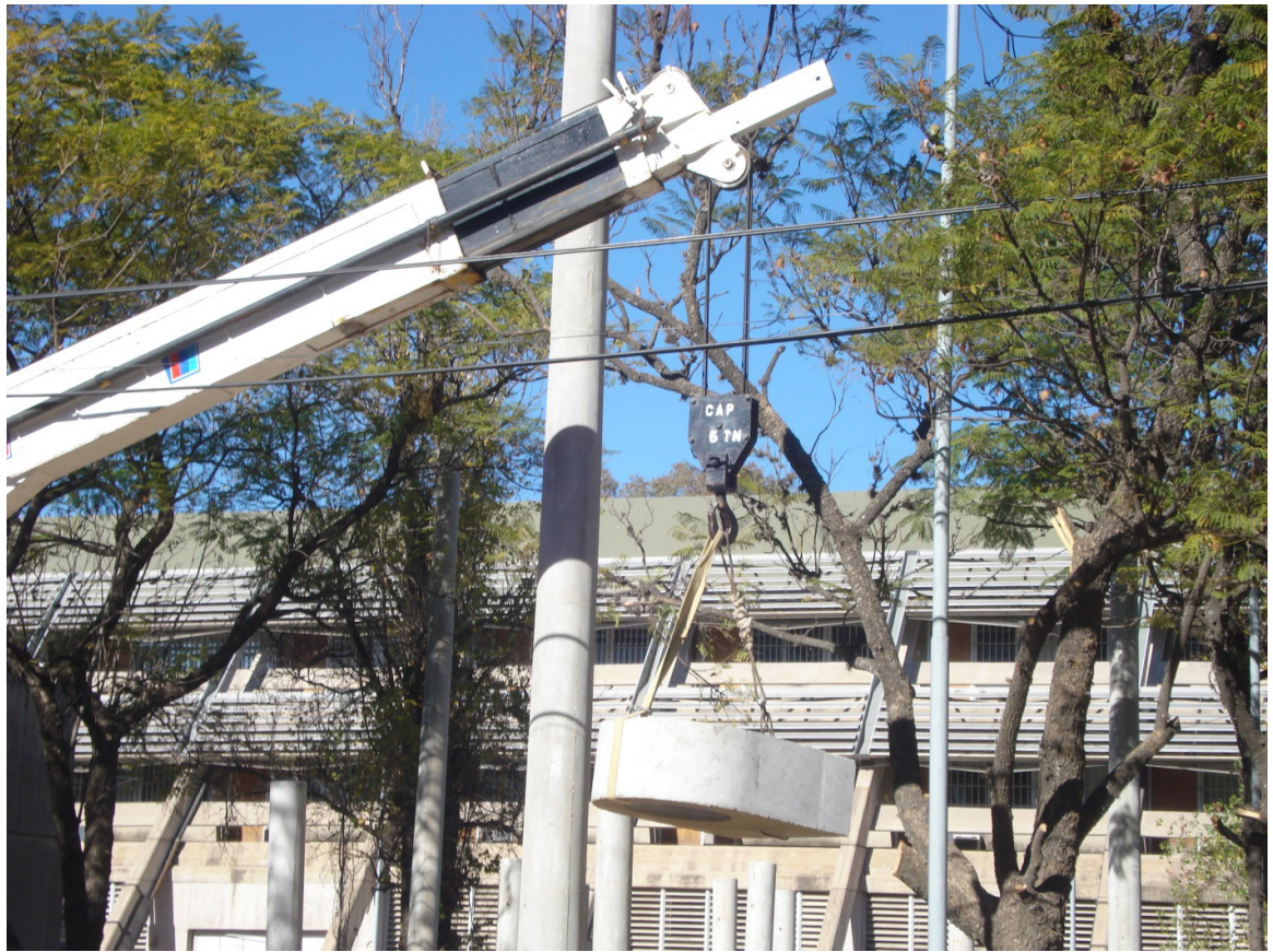
ARMADO DE ESTRUCTURAS – IZADO DE ACEORIOS
