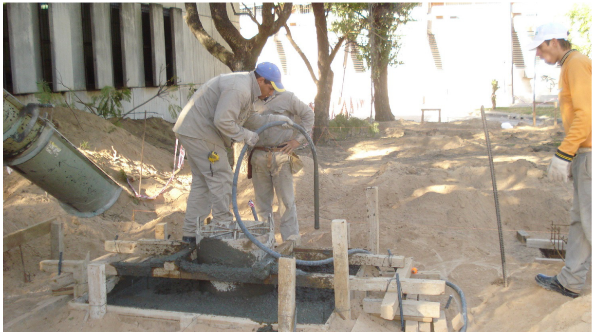
EJECUCIÓN DE BASES DE EQUIPOS
