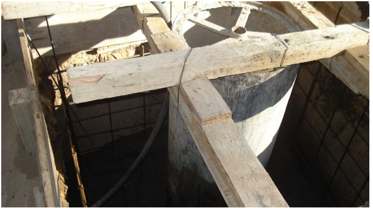
EJECUCIÓN DE BASES DE EQUIPOS
