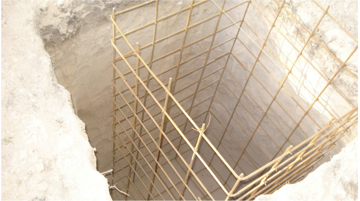
EJECUCIÓN DE BASES DE EQUIPOS – ARMADURA DE HIERRO
