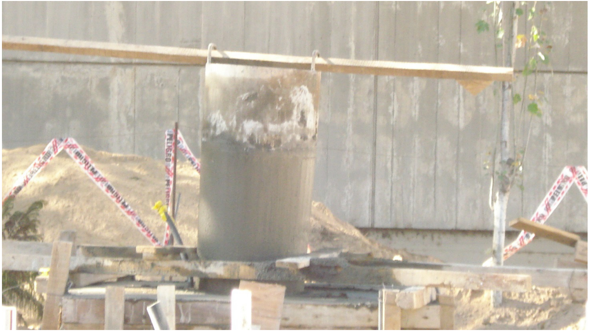
EJECUCIÓN DE BASES DE EQUIPOS
