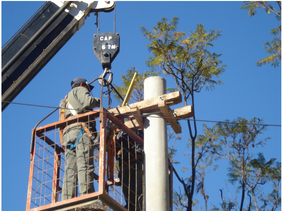
ARMADO DE ESTRUCTURAS
