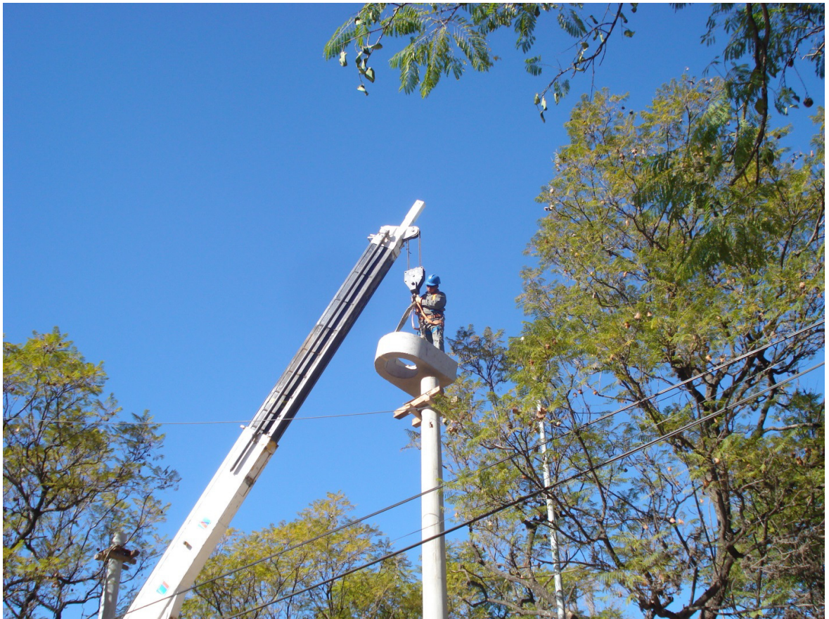
ARMADO DE ESTRUCTURAS – IZADO DE ACCERIOS
