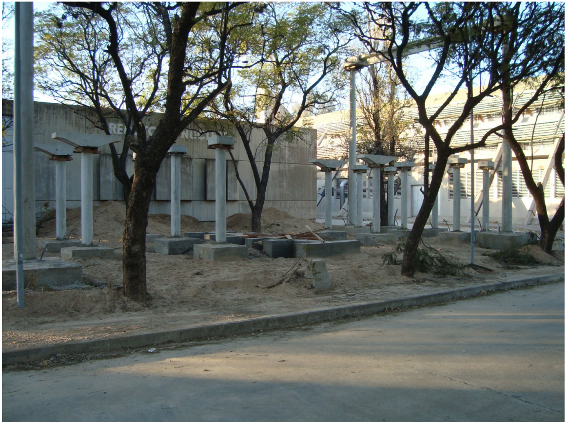
ARMADO DE ESTRUCTURAS
