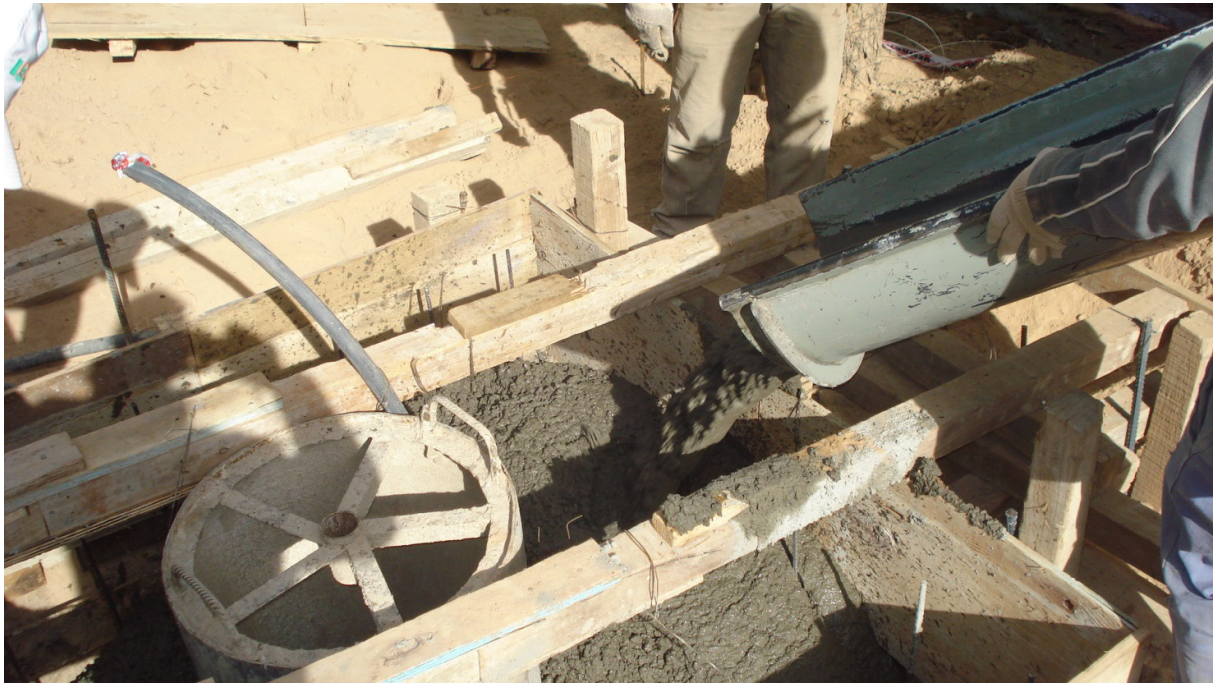
EJECUCION DE BASES DE EQUIPOS – COLADO DEL HORMIGON
