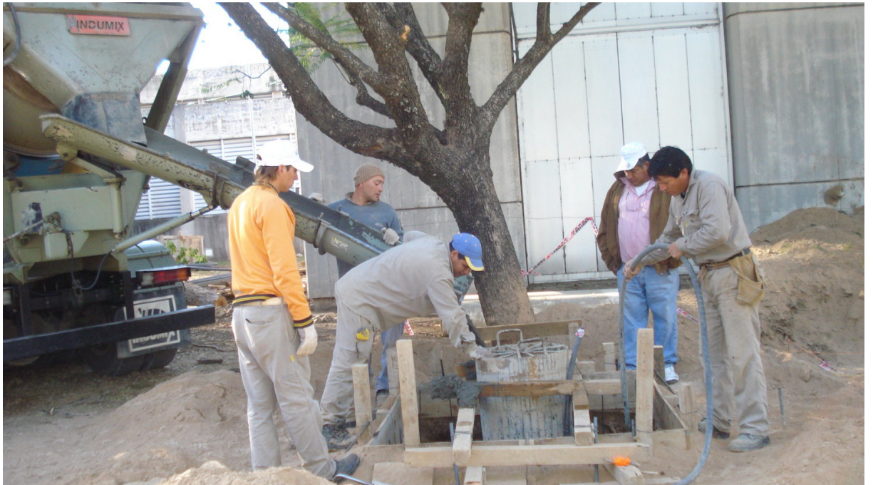
EJECUCIÓN DE BASES DE EQUIPOS
