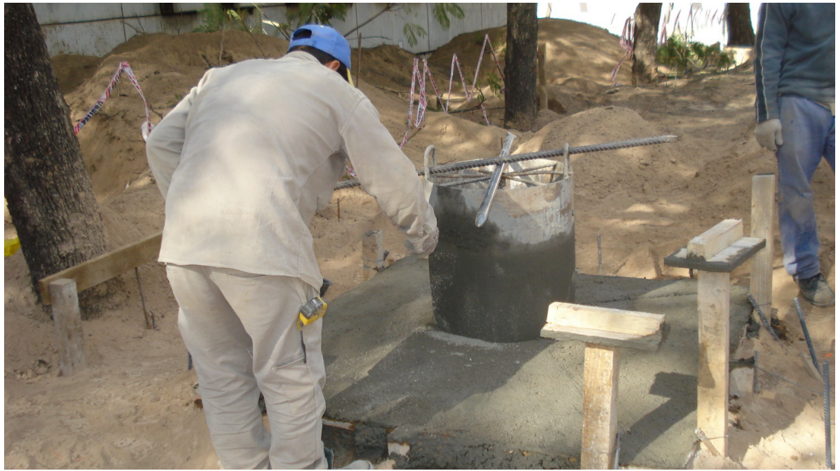
EJECUCIÓN DE BASES DE EQUIPOS – EXTRACCIÓN DEL MOLDE
