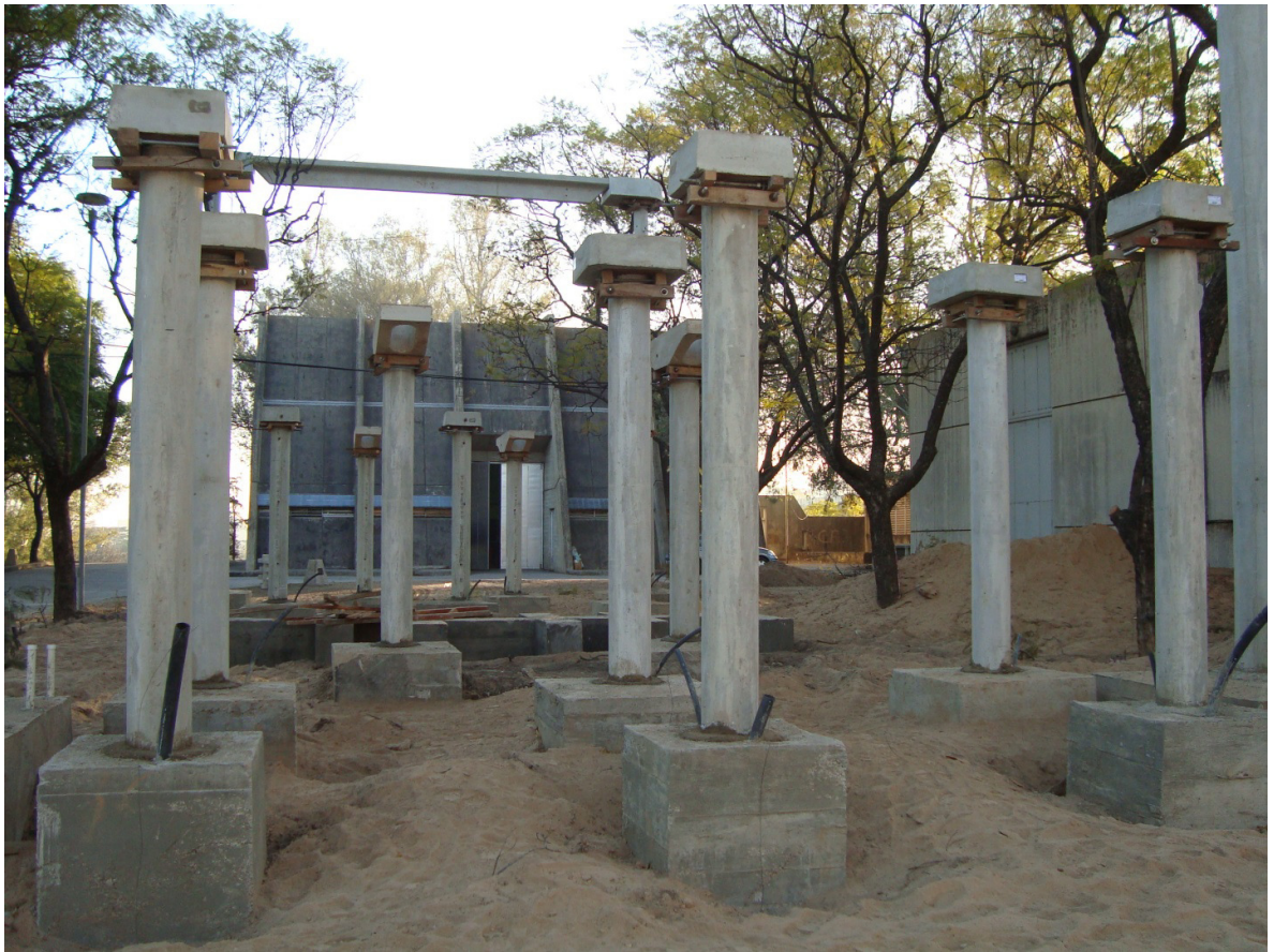
ARMADO DE ESTRUCTURAS
