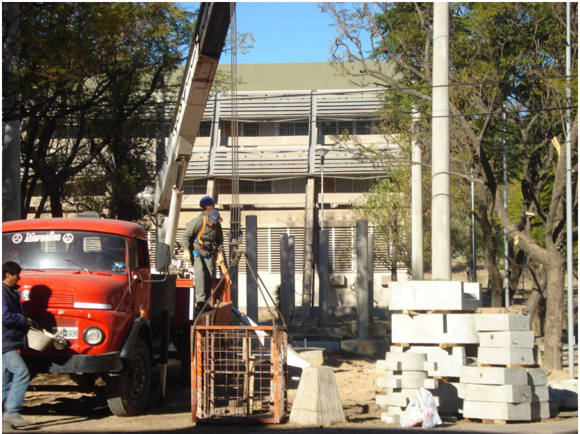
ARMADO DE ESTRUCTURAS
