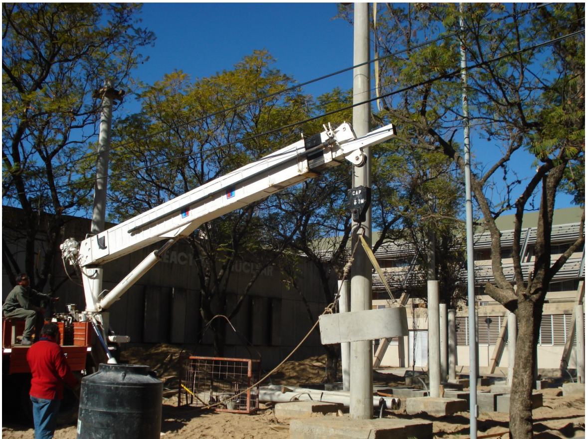
ARMADO DE ESTRUCTURAS – IZADO DE ACCERIOS
