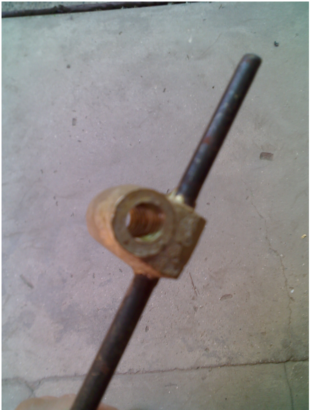
DETALLE DE BLOQUETE DE PUESTA A TIERRA
