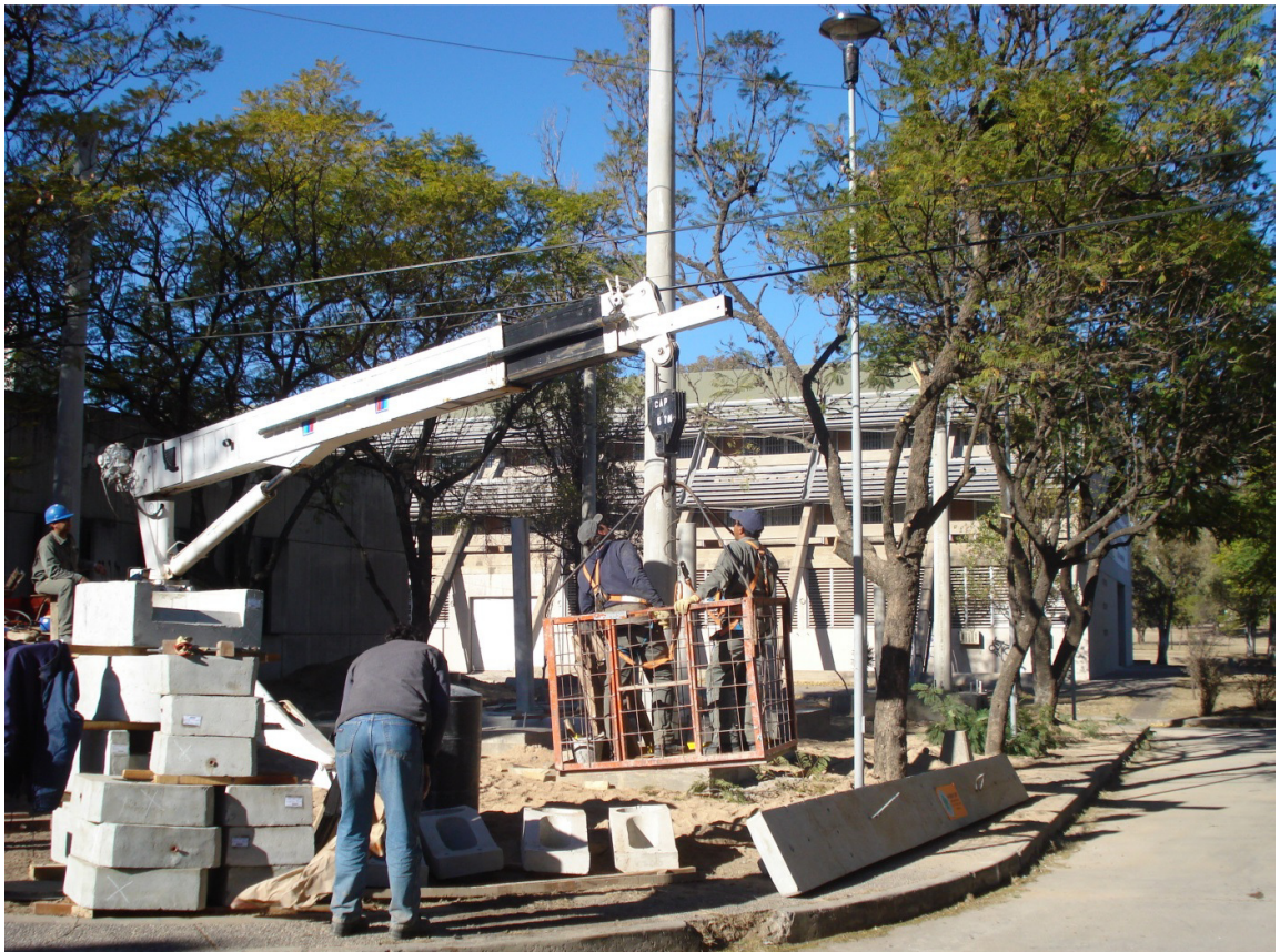
ARMADO DE ESTRUCTURAS
