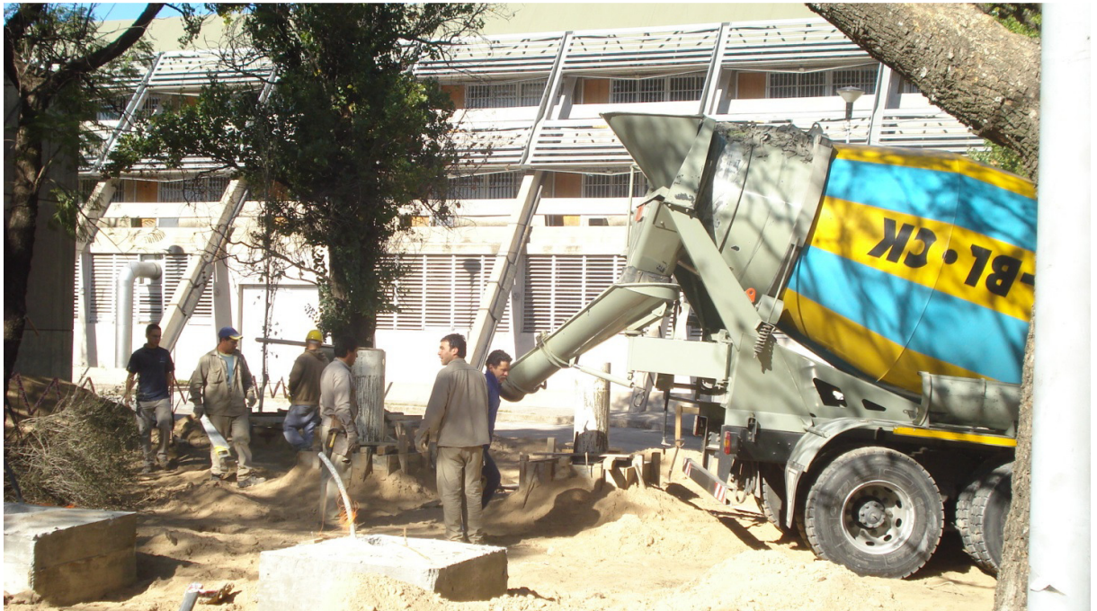
EJECUCIÓN DE BASES DE EQUIPOS
