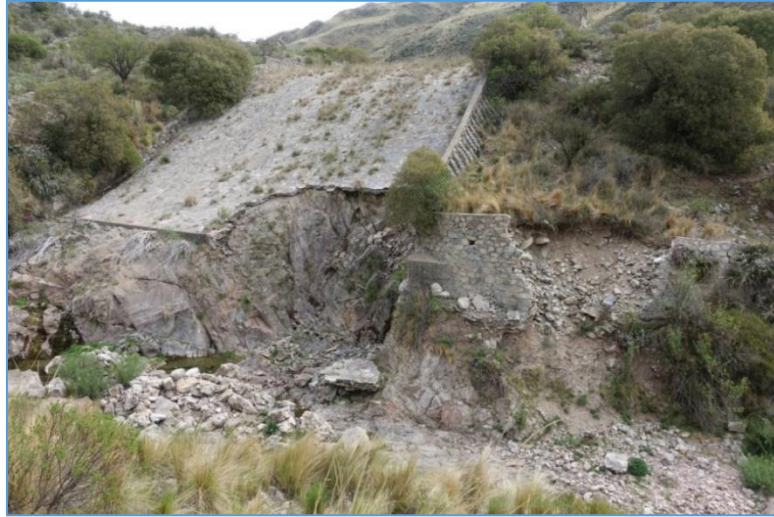
Figura 2. Vista del vertedero lateral del dique.
