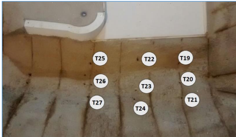
Figura 33. Tomas de presión en el cuenco dissipador aguas abajo del vertedero lateral.
