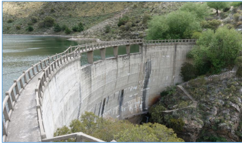
Figura 3. Vista del vertedero sobre la presa arco.
