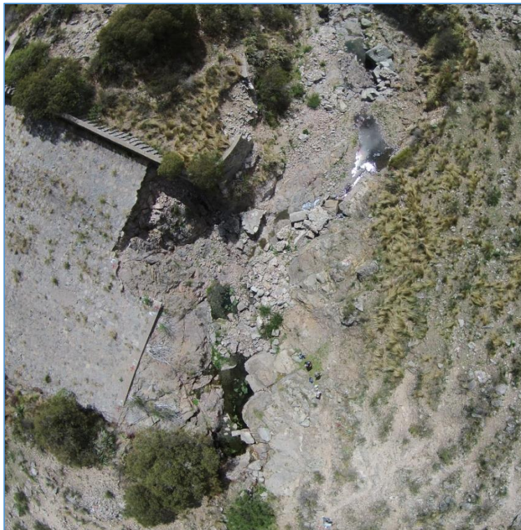
Figura 5. Imagen aérea, tomada mediante un dron, de la topografía aguas abajo del vertedero lateral comprometido del Dique Los Alazanes.
