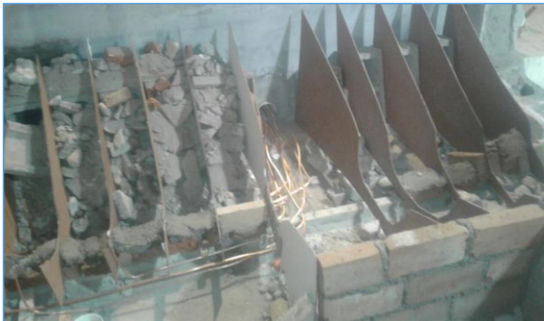
Figura 34. Conductos de cobre de las tomas de presión.
