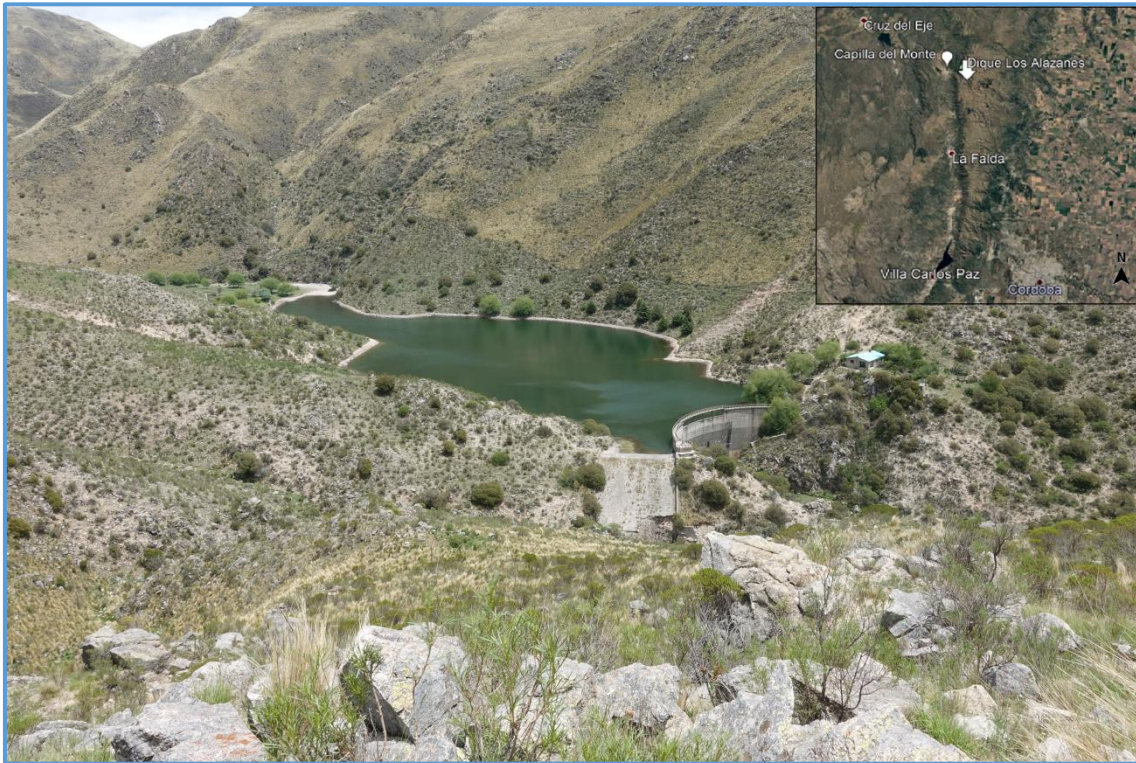
Figura 1. Ubicación y vista general del Dique Los Alazanes.
