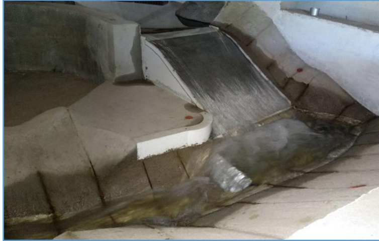
Figura 56. Incorporación de aire al flujo en la solera de la rápida del vertedero.
