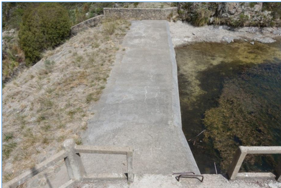
Figura 30. Fotografía del vertedero lateral.
