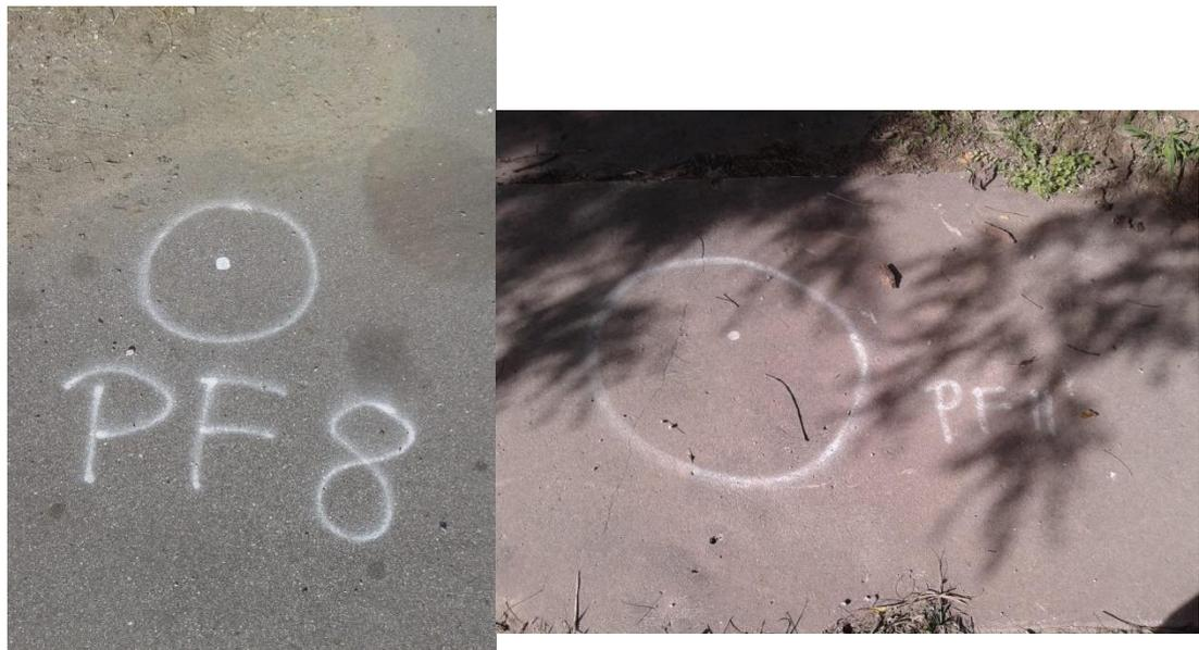
Ilustración 20: Puntos Fijos con aerosol
