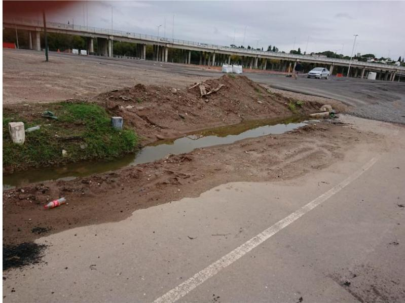
**Ilustración 24: Desagüe mal diseñado cerca al PF 1**
