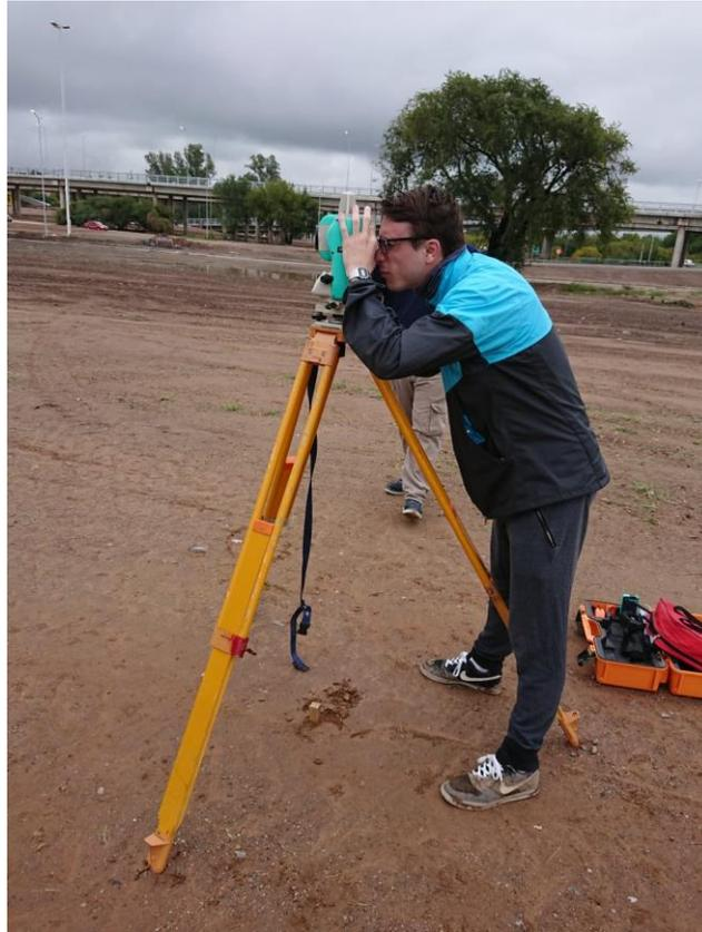
**Ilustración 22: Medición con Estación Total**
