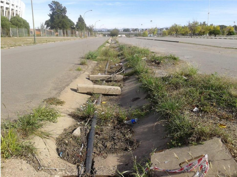
**Ilustración 43: Cuneta de estacionamiento con barro, desechos y escombros**
