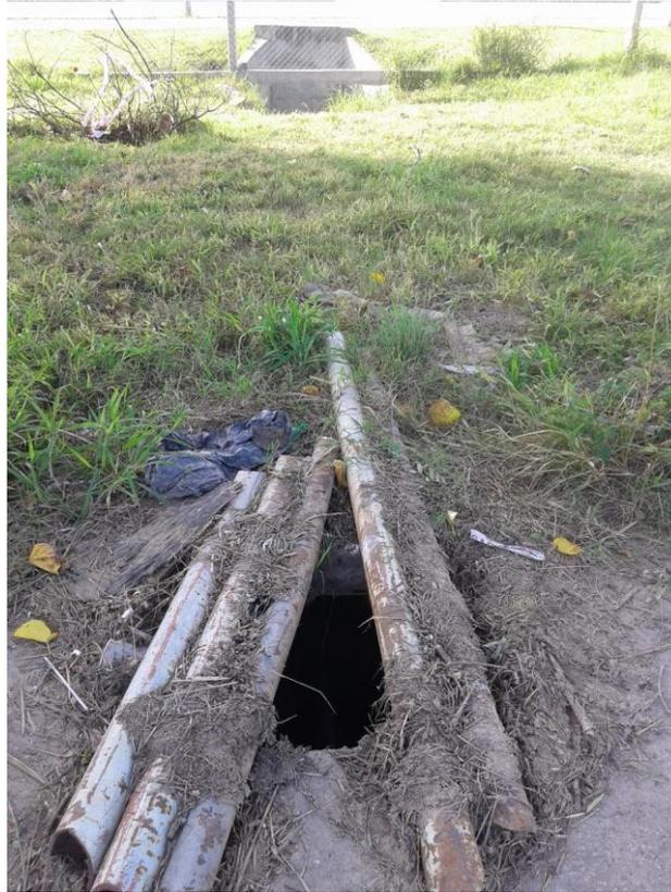
Ilustración 36: Boca de Inspección
