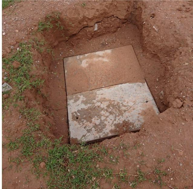
**Ilustración 26: Pozo de Cablevisión**
