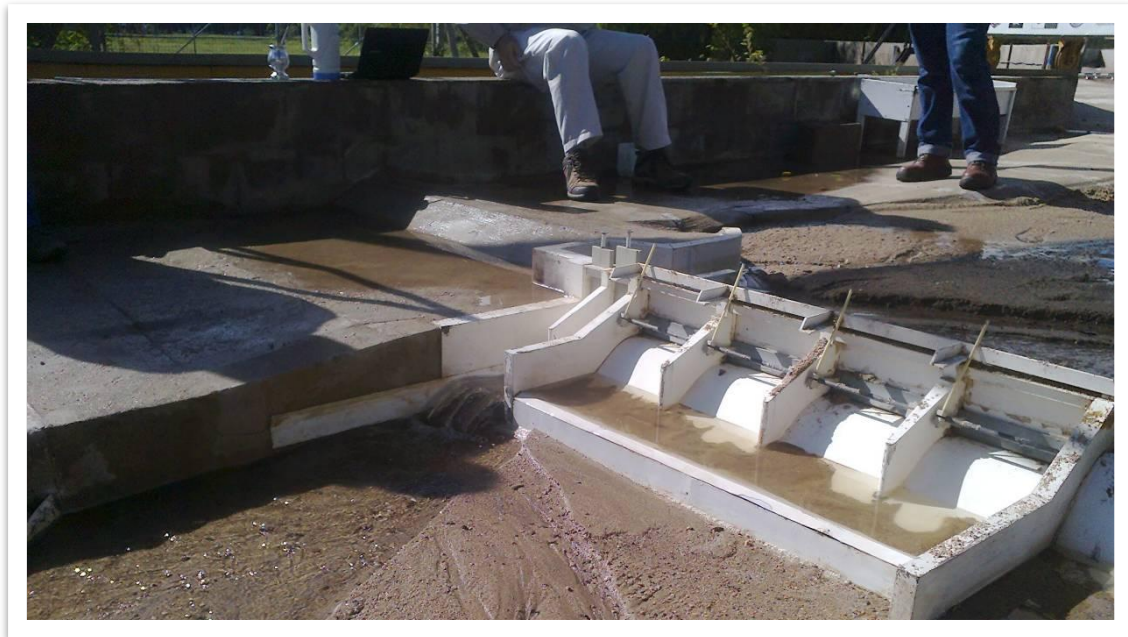
Figura 65: Fosa de erosión aguas abajo de CM con Q=75 \text{ m}^3/\text{s}
