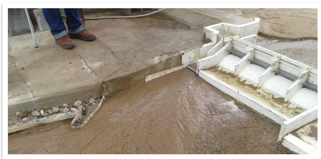
Figura 45: Detalle de zona aguas abajo de la obra con Q=15 \text{ m}^3/\text{s}
