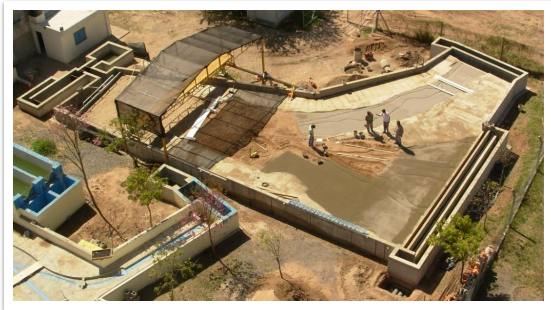
Figura 8: Modelo Físico “Los Molinos” construido en el Laboratorio de Hidráulica de la FCEyN-UNC.
