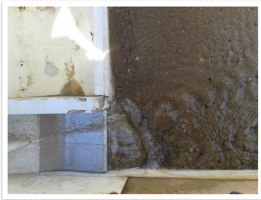
Figura 59: Fosa de erosión aguas abajo de CM con Q=50 \text{ m}^3/\text{s}
