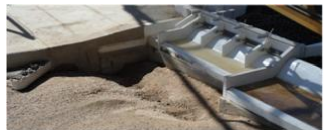
Fig. 6: Foso de erosión aguas abajo del dique móvil. Caudal prototipo: 900 m³/s
