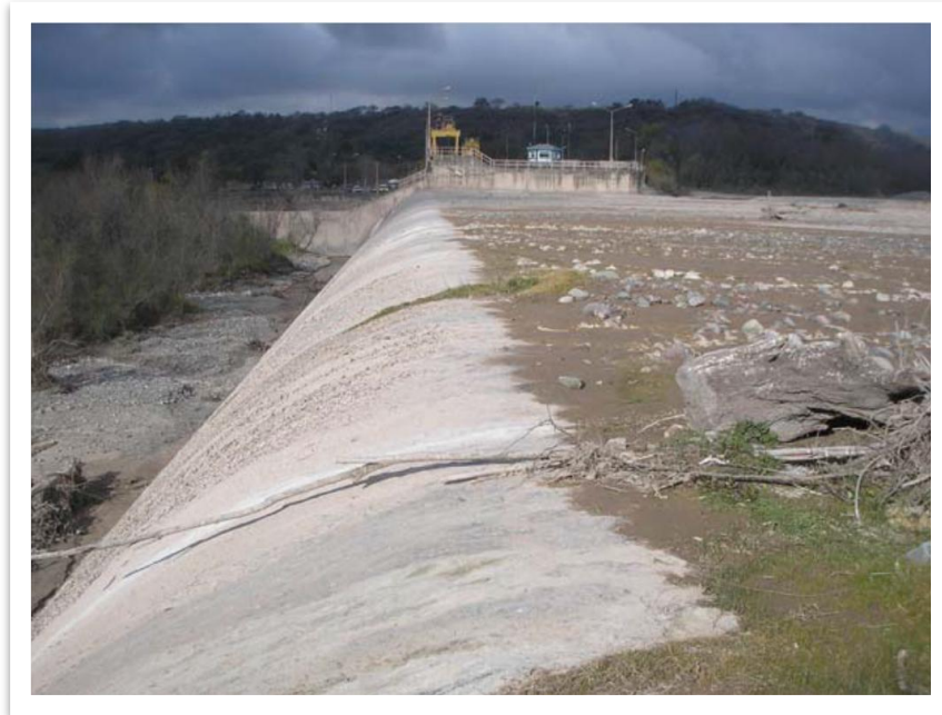
Figura 4. Tarquinamiento Dique Fijo
