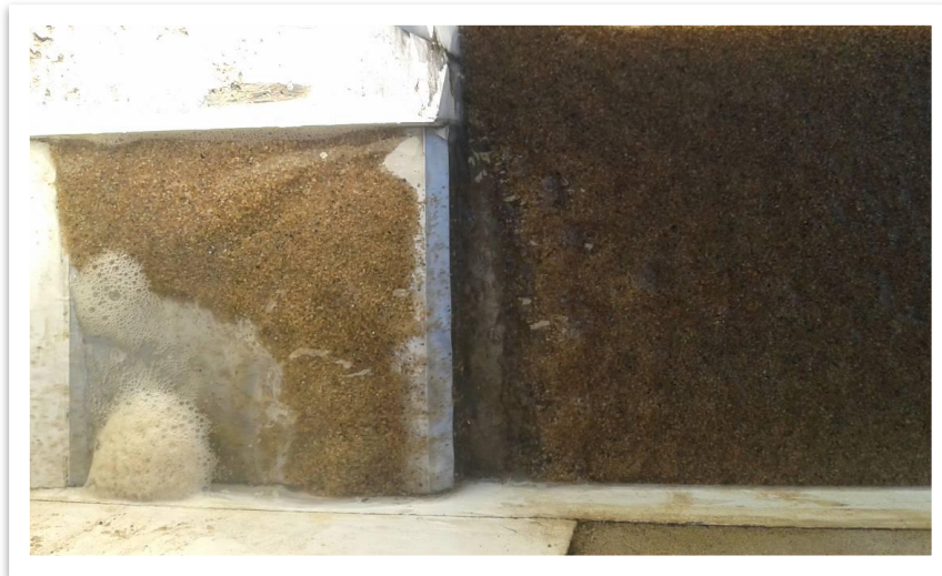
Figura 53: Fosa de erosión aguas abajo de CM con Q=30 \text{ m}^3/\text{s}
