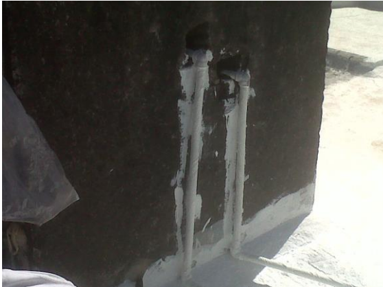
Impermeabilizar zonas de uniones.
