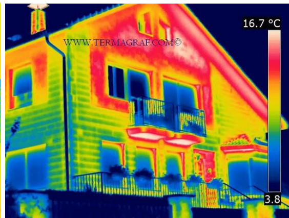
Detección de puente térmico.
