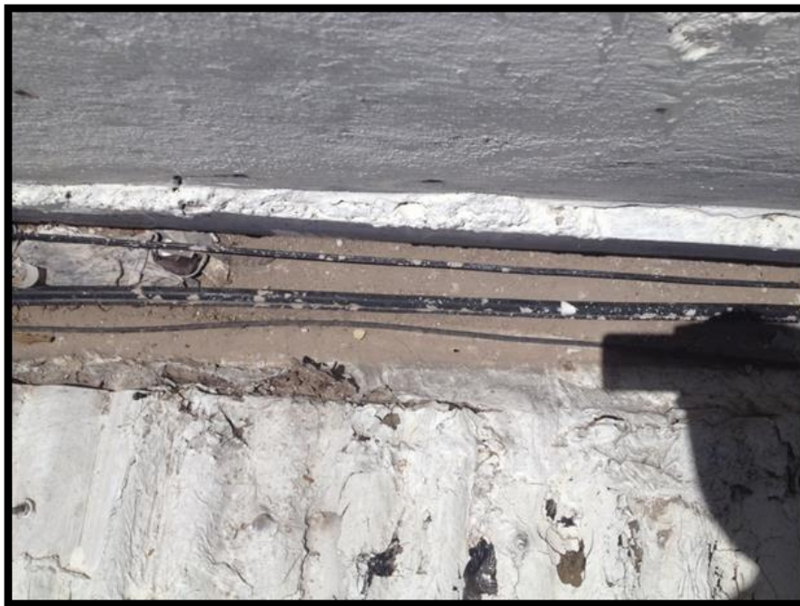
Fotografía 1.1 – Encuentro de chapa con canaleta y pared medianera
