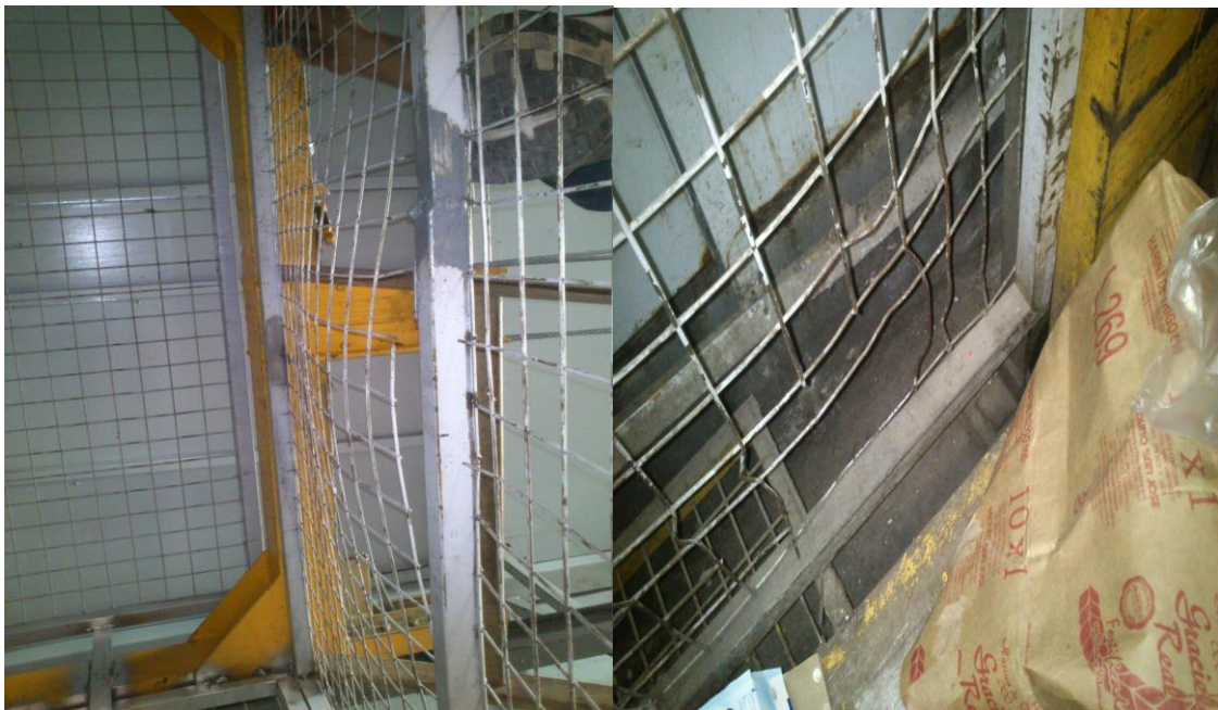
En ambas imágenes se observa el mal estado del panel lateral en malla
