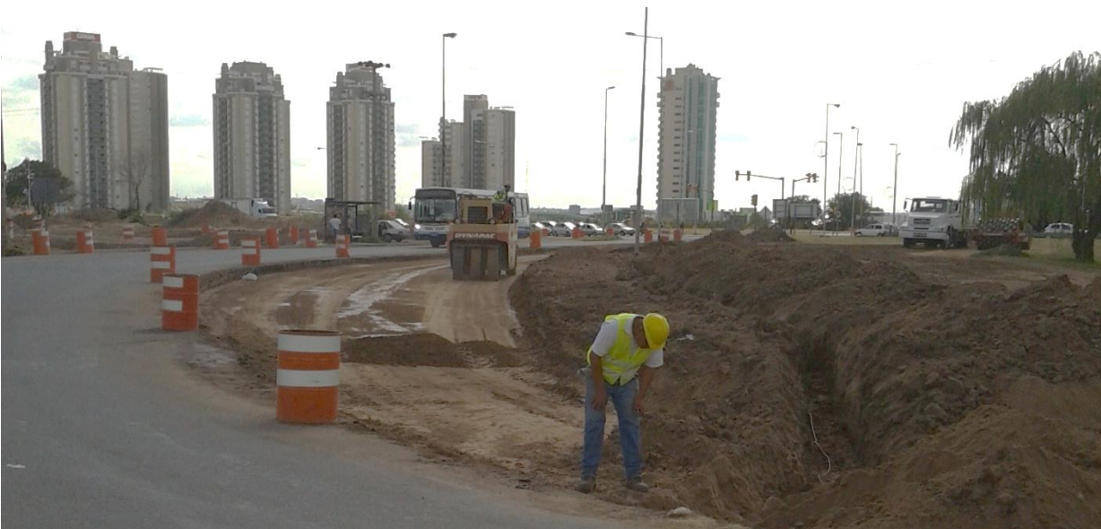
Fig.6.36 – Compactado de los ensanches.
