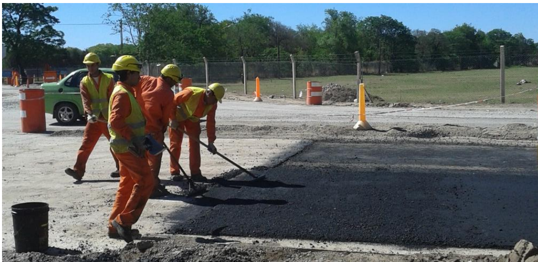
Fig.6.32 – Corrección de junta.
