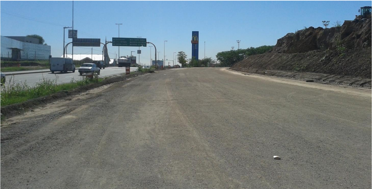
Fig. 6.21 – Predio Compactado y Nivelado.
