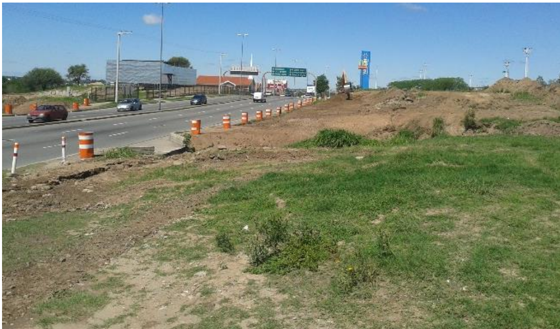
Fig. 6.11 – Predio del Desvío antes y durante la limpieza.
