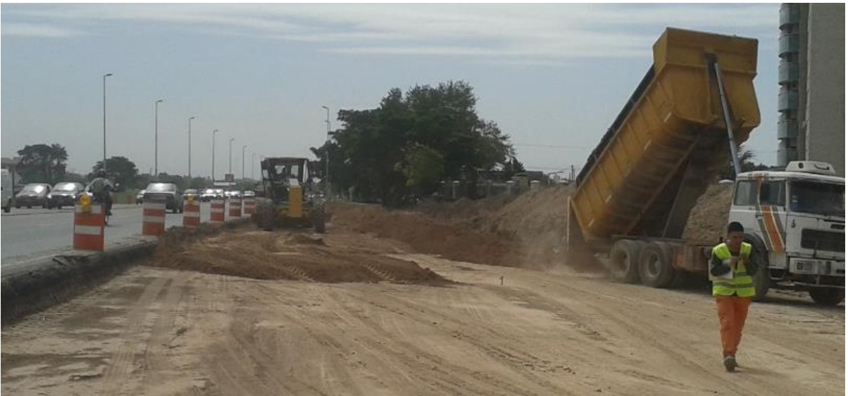
Fig. 6.16 – Distribución de SubBase.
