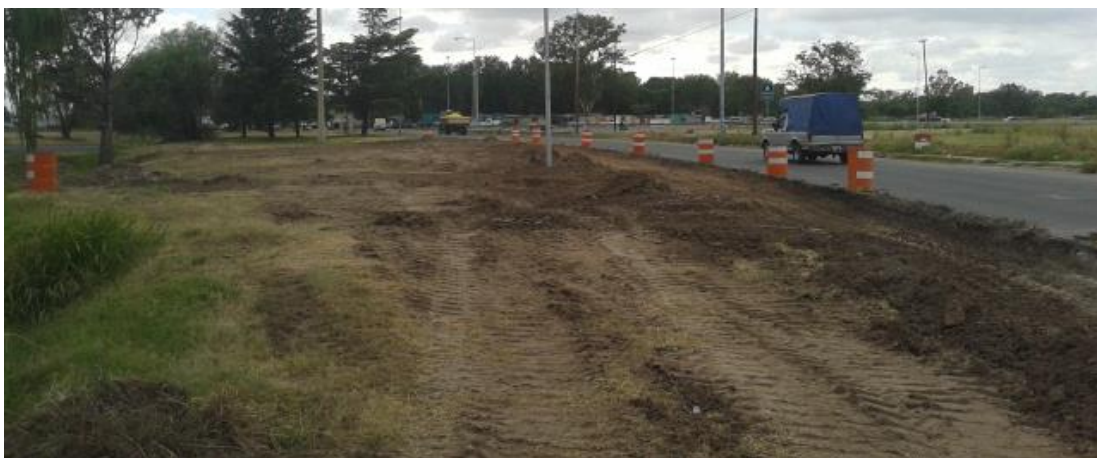
Fig. 6.34 – Desmonte limpieza y apertura de caja.
