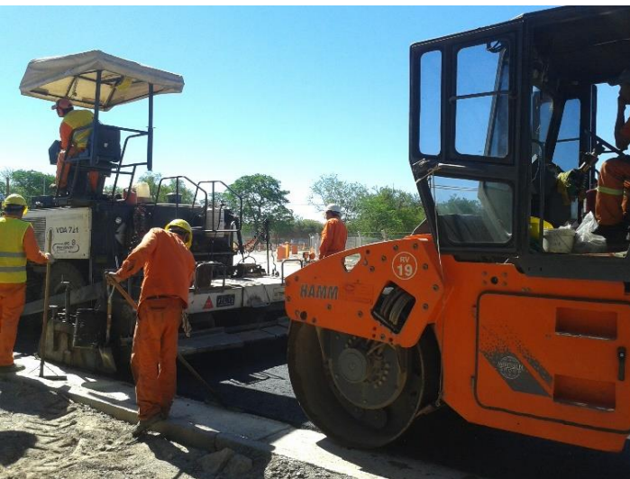
Fig.6.29 – Rodillos compactando.
