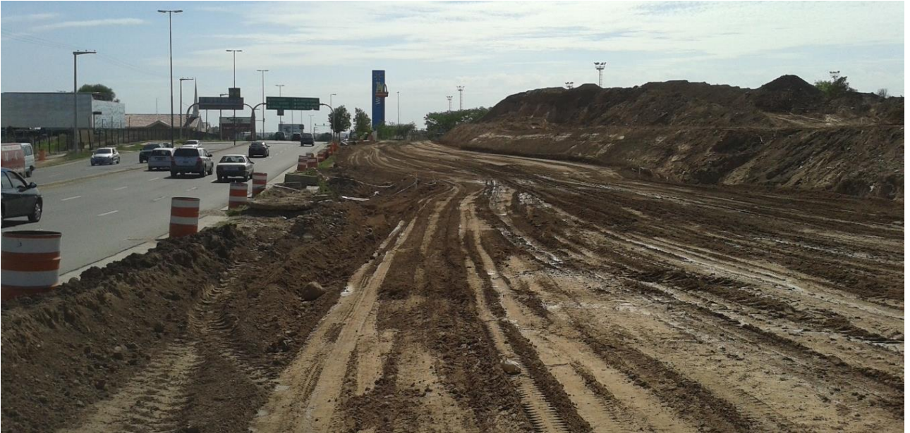
Fig. 6.15 – Predio Limpio y Saneado.
