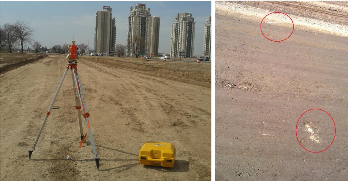
Fig. 6.20 – Nivelación y Estaqueado.
