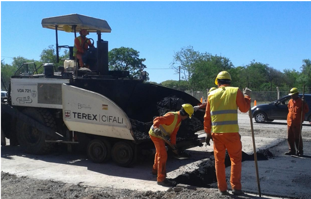
Fig. 6.27 – Terminadora de Asfalto.
