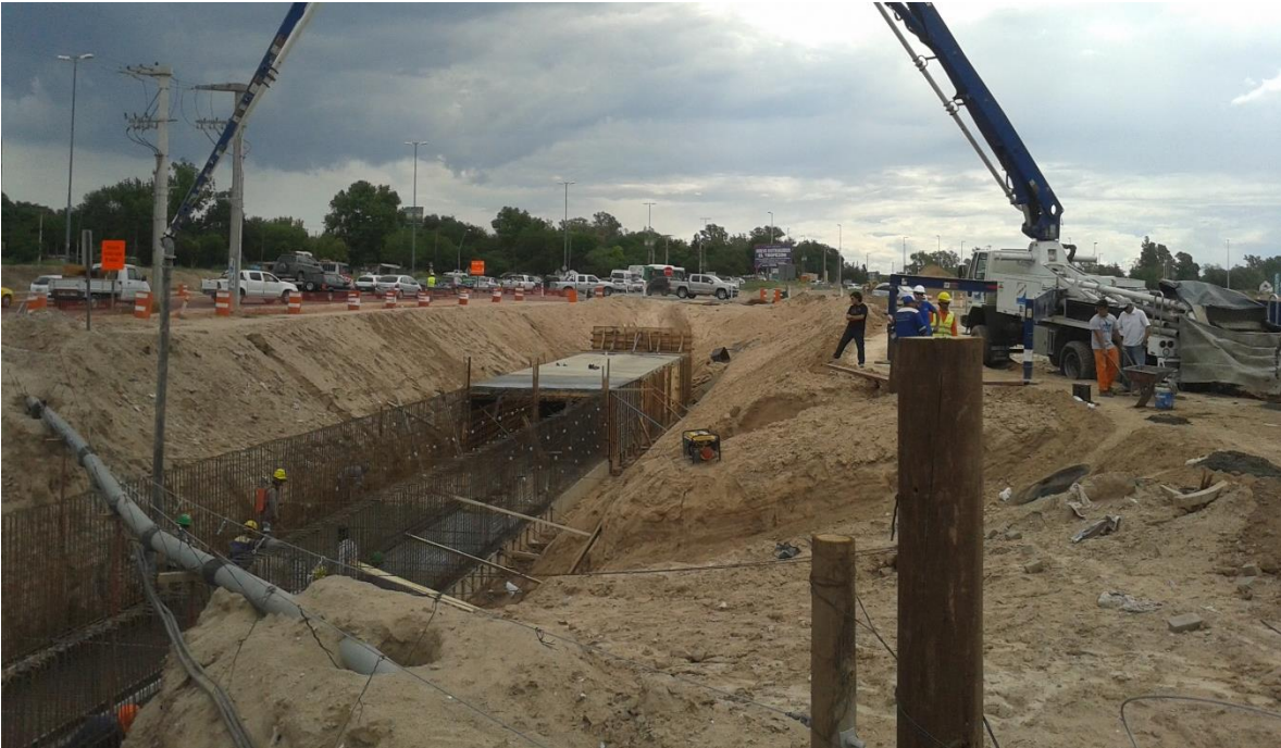
Fig.6.3 – Ejecución de Alcantarillas 17.
