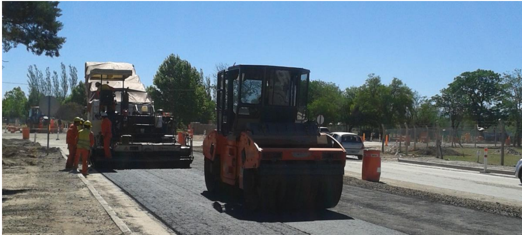
Fig.6.31 – Rodillo neumático compactando.
