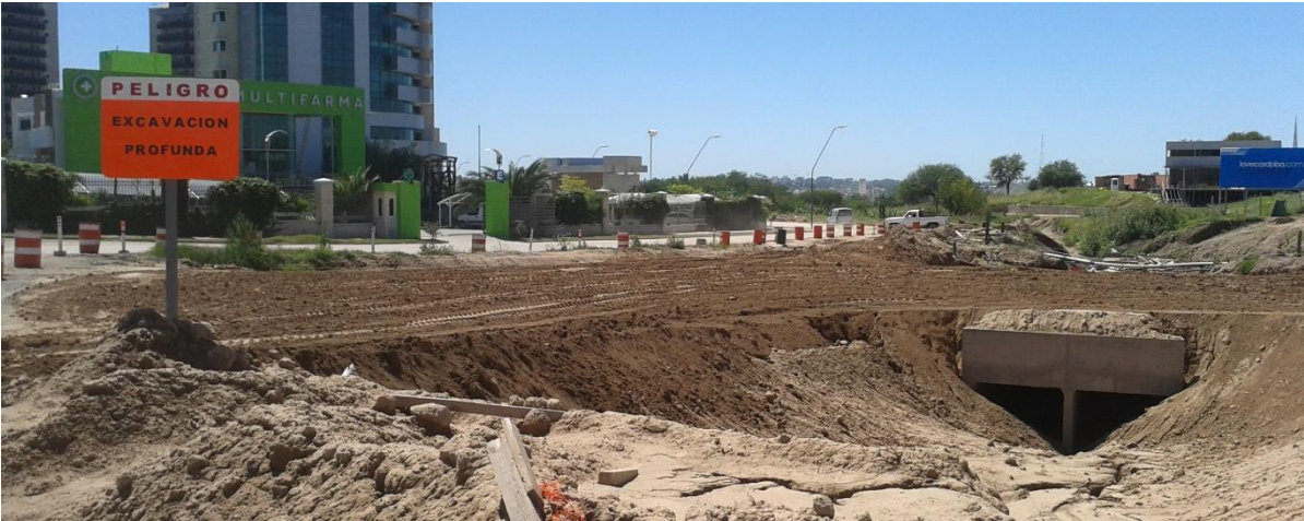
Fig.13.9 – Señalización de la Obra.
