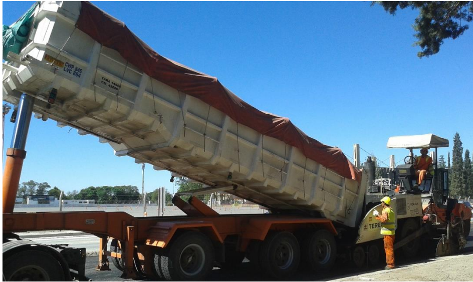
Fig. 6.28 – Cargado de la terminadora.
