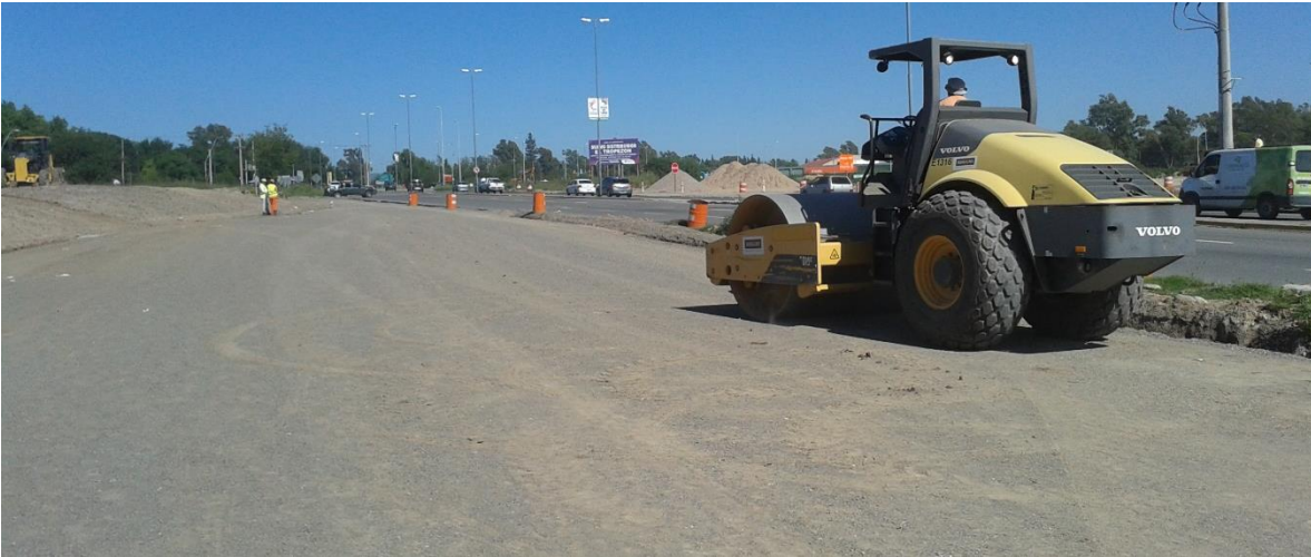
Fig. 6.19 – Rodillo Liso Compactando SubBase.
