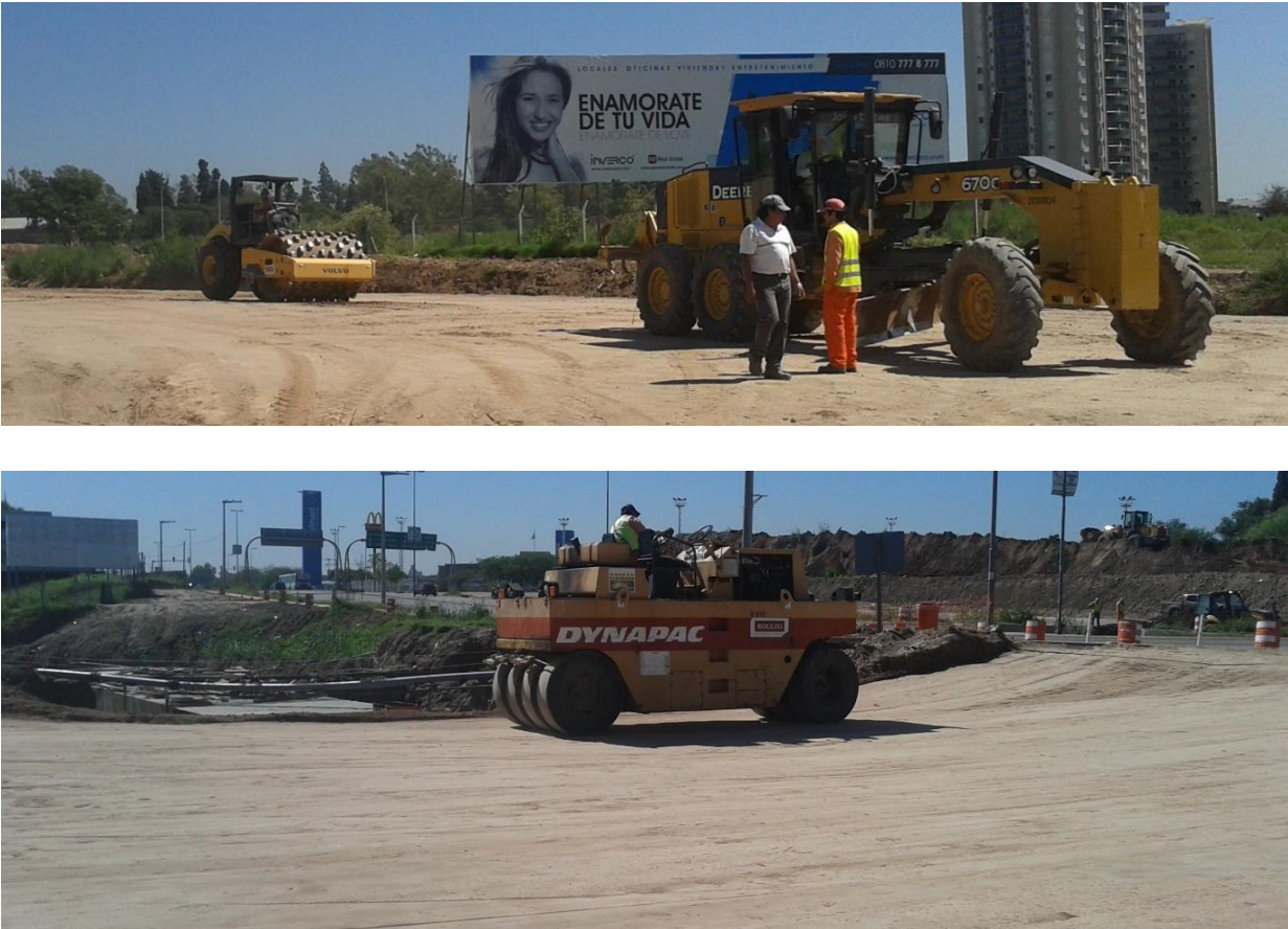
Fig. 6.14 – Maquinaria dispuesta en obra.
