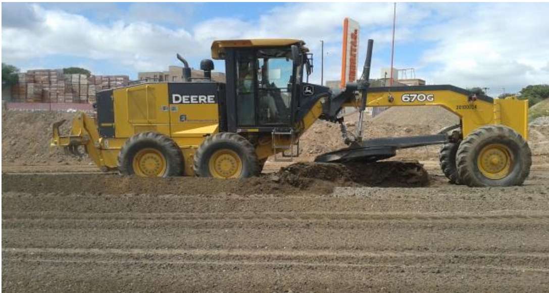
Fig. 6.17 – Motoniveladora distribuyendo material.
