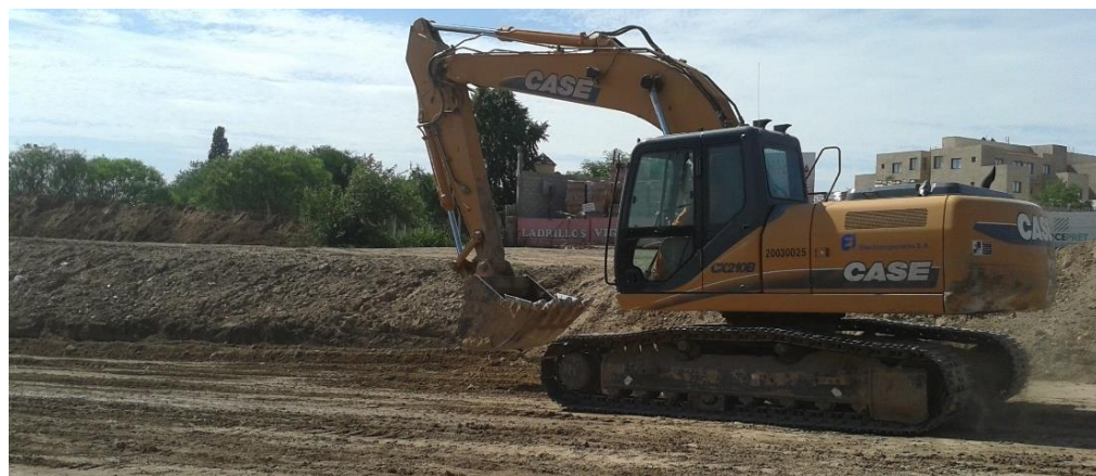
Fig. 6.9 – Excavadora CASE utilizada para la obra.
