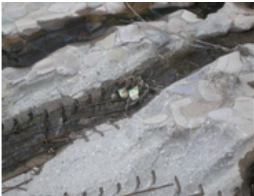
Figura 6: Abrasión del dique móvil.
